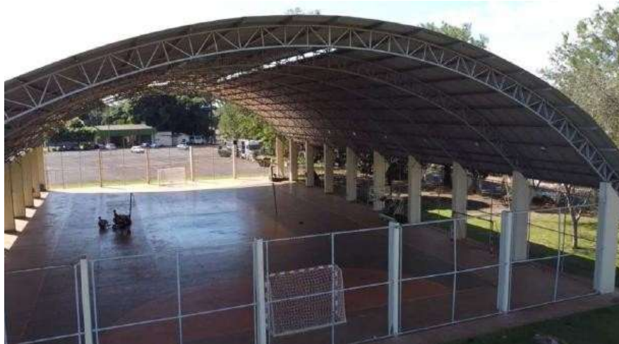
Figura 10 - Estrutura do interior da quadra
