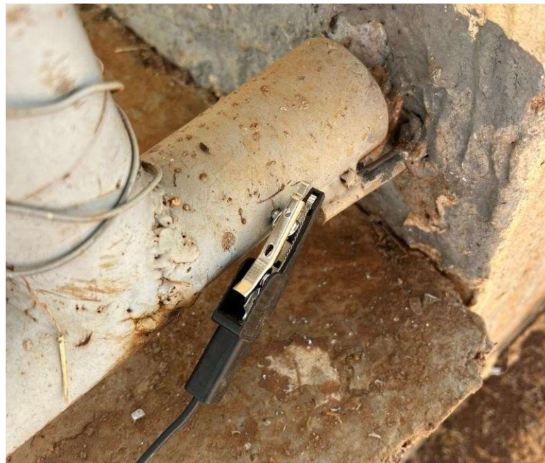
Figura 27: Medição realizada para verificação da execução da equipotencialização no tubo (Garra de tomada de terra).
