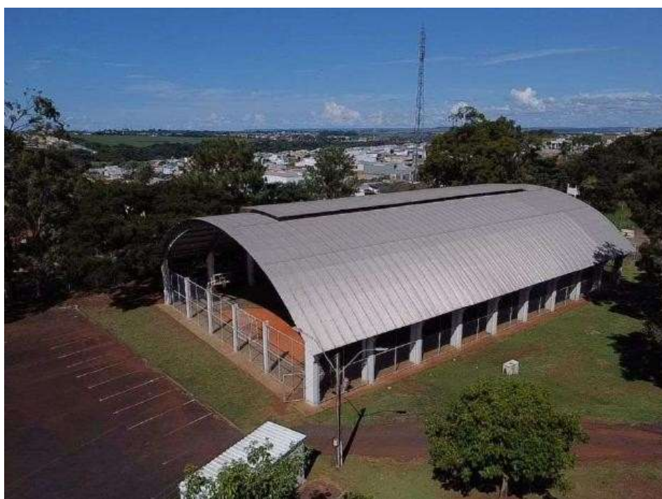
Figura 1 - Cobertura metálica e estrutura da quadra poliesportiva, passíveis de aproveitamento como componentes naturais do SPDA externo.
