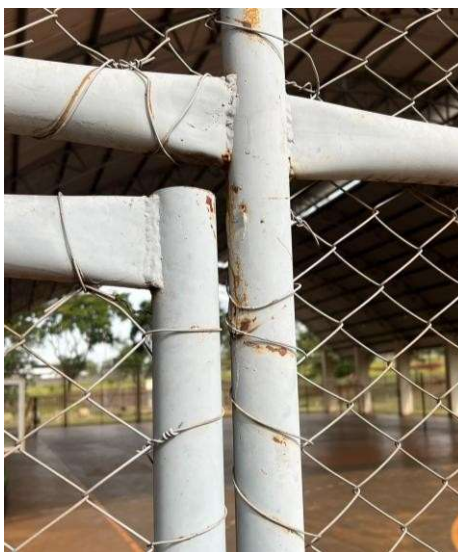
Figura 18 – Portão de entrada da quadra
