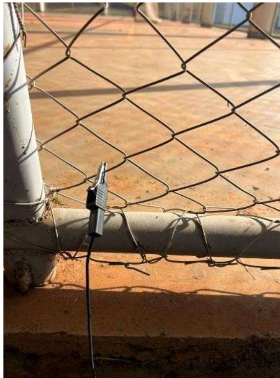
Figura 29: Medição realizada para verificação da execução da equipotencialização na tela da grade (garra de tomada de terra).
