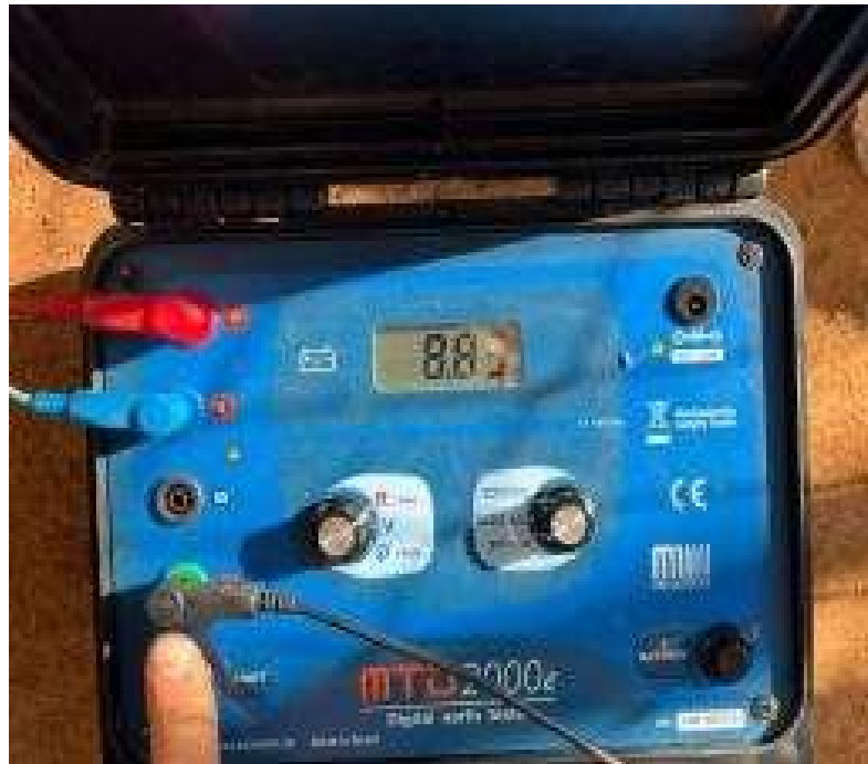
Figura 28: Medição realizada para verificação da execução da equipotencialização (visor terrômetro).
