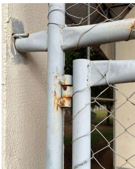
Figura 17 – Portão de entrada da quadra
