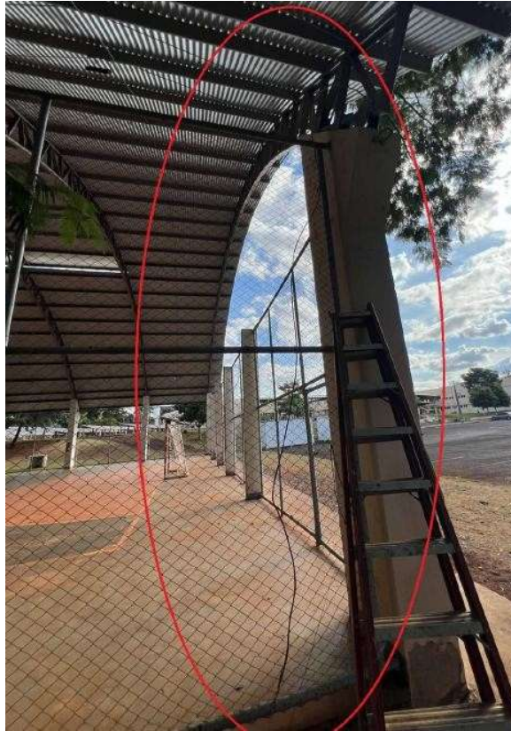
Figura 23 - Condutor de equipotencialização adequado.
