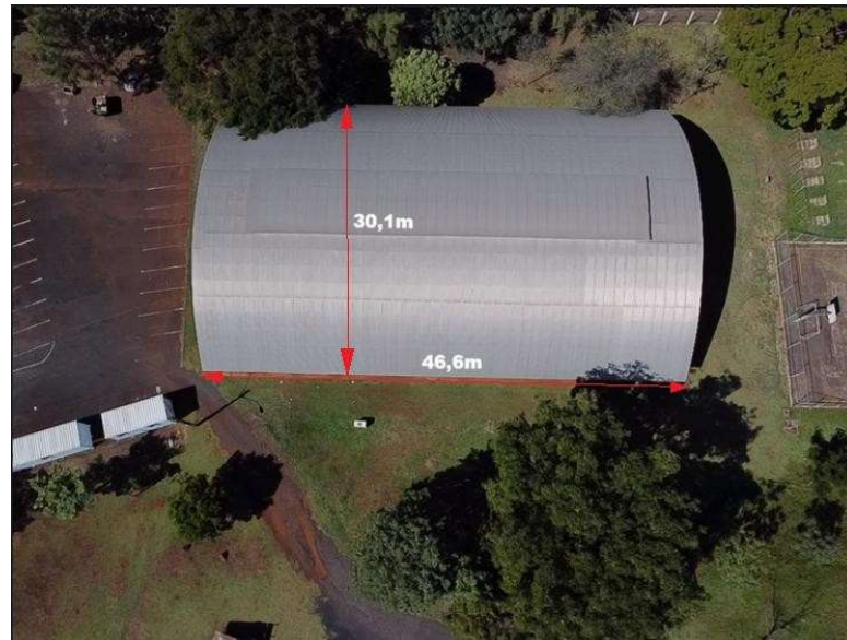
Figura 6 - Vista aérea da quadra com suas dimensões.
