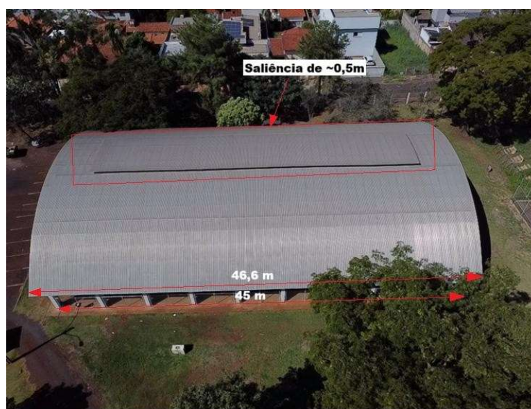
Figura 5 - Vista aérea da quadra com suas dimensões.
