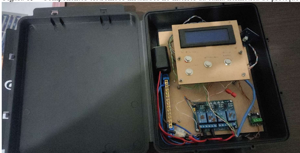
Figura 15 – Componentes eletrônicos instalados no interior da caixa hermética de proteção.
