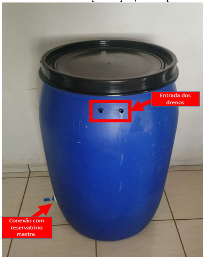
Figura 11 – Reservatório escravo utilizado para ampliação da capacidade de armazenamento.
