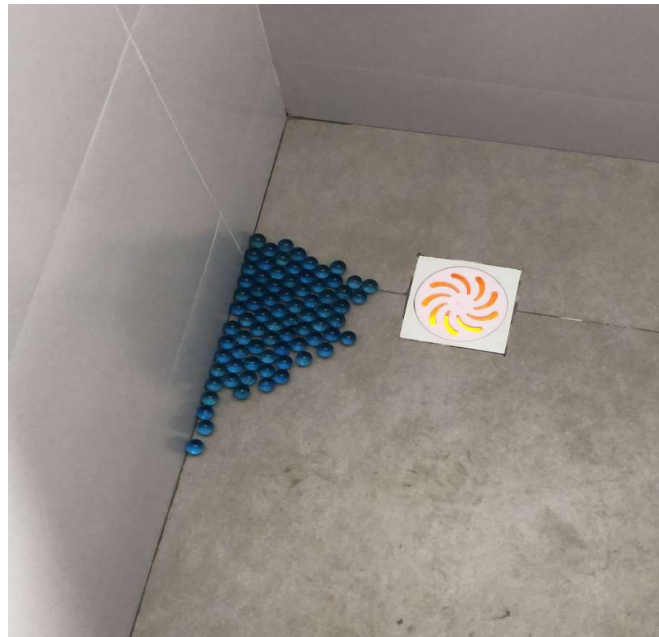
Figura 24 - Limitação do caimento em decorrência da paginação adotada.
