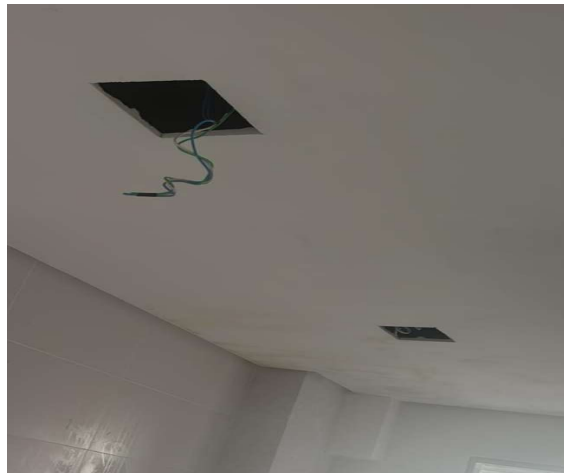
Figura 30 - Recorte para passagem de fiação na cozinha
