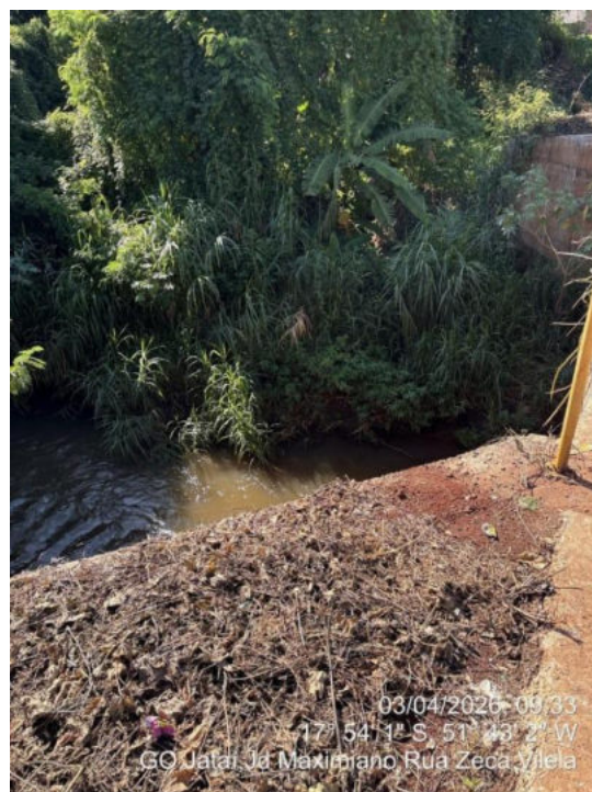
Figura C.4 — Talude com vegetação densa.
