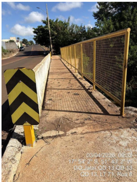
Figura C.5 — Sinalização e guarda-corpo.
