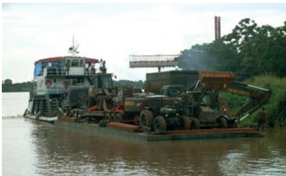
Figura 13 – Transporte de equipamentos e materiais na Região Norte
