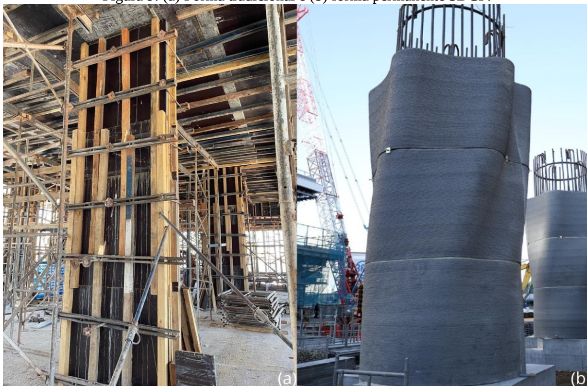
Figura 9: (a) Fôrma tradicional e (b) fôrma permanente 3DCP.
