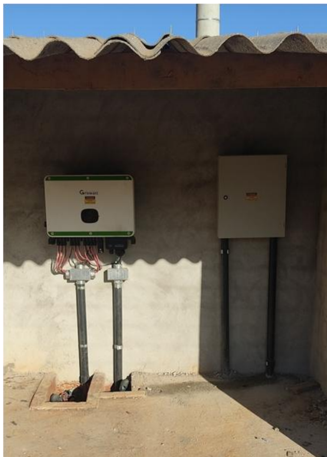
Figura 96. Usina Fotovoltaica concluída – Quadro de Distribuição.
