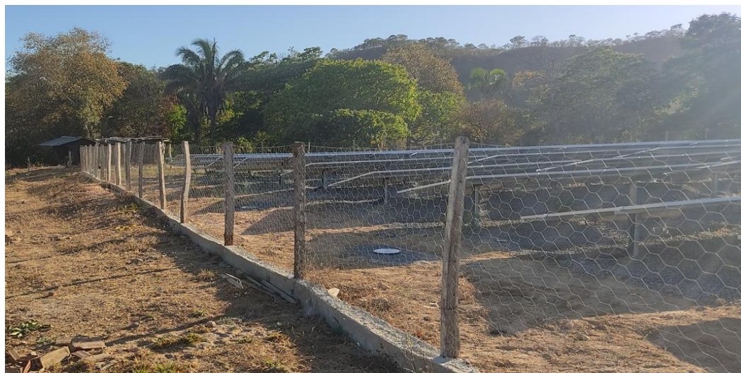
Figura 91. Usina Fotovoltaica concluída – detalhe do alambrado.
