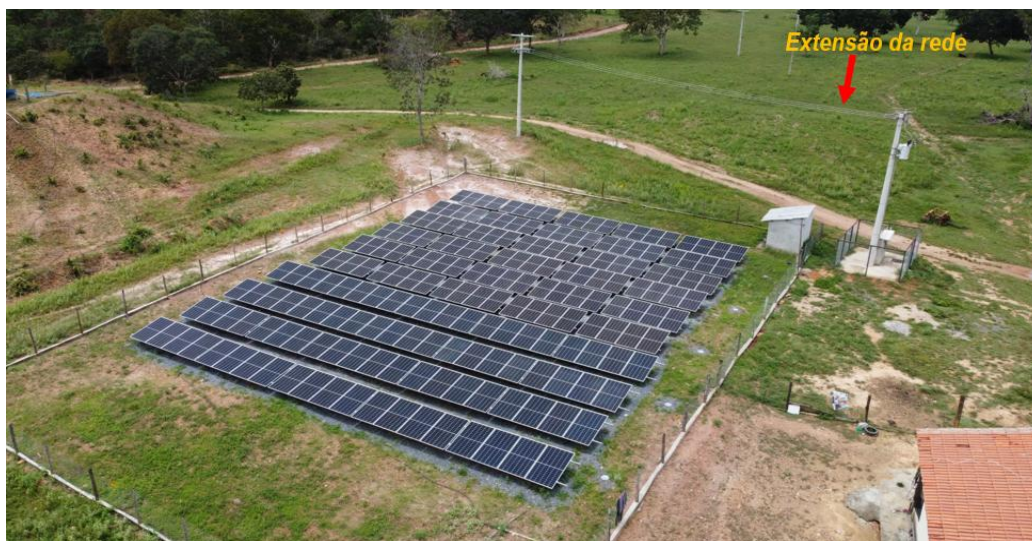
Figura 103. Extensão da rede realizada pela concessionária ENEL.
