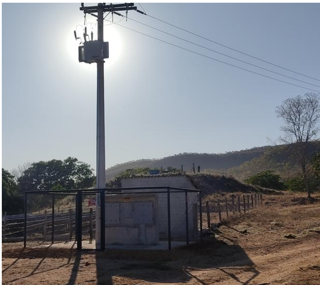
Figura 100. Subestação de 75kVA – detalhe do Transformador.
