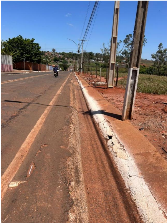
Figura 4.23 - Canaletas utilizadas como bueiros para o escoamento das águas pluviais em trecho urbano.
