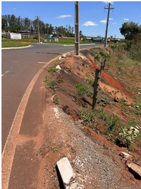
Figura 4.5 - Área com talude.
