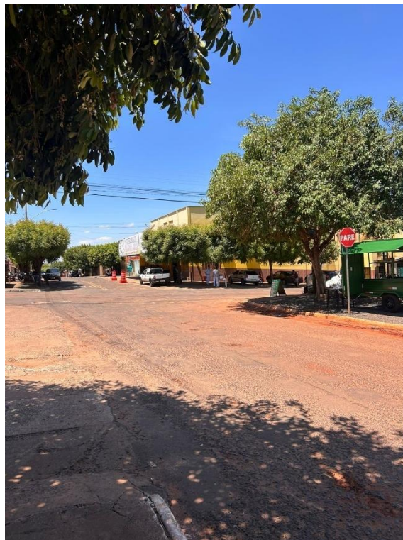
Figura 4.12 - Ausência de sinalização horizontal no trecho urbano.
