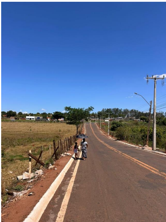
Figura 4.6 - Pedestre utilizando a pista de rolamento devido à inexistência de calçada.
