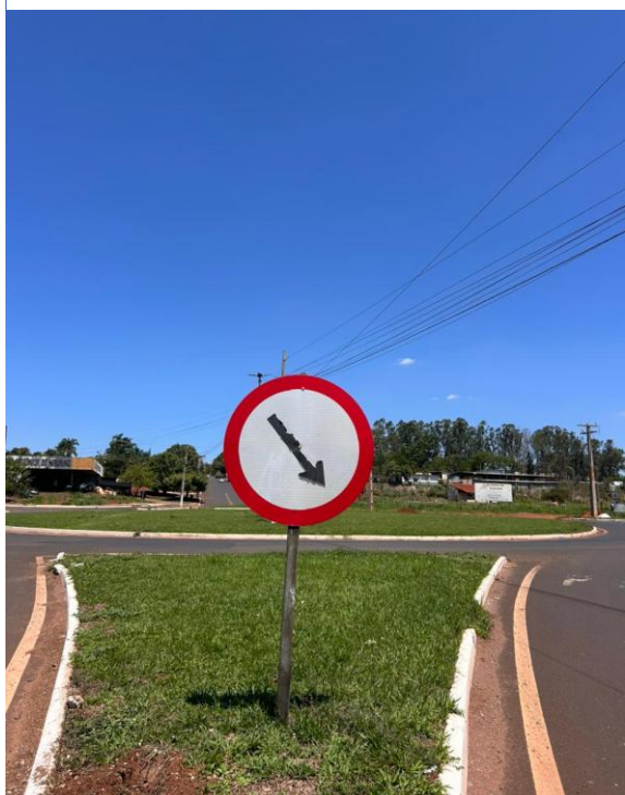
Figura 4.10 - Exemplo de sinalização vertical desgastada.
