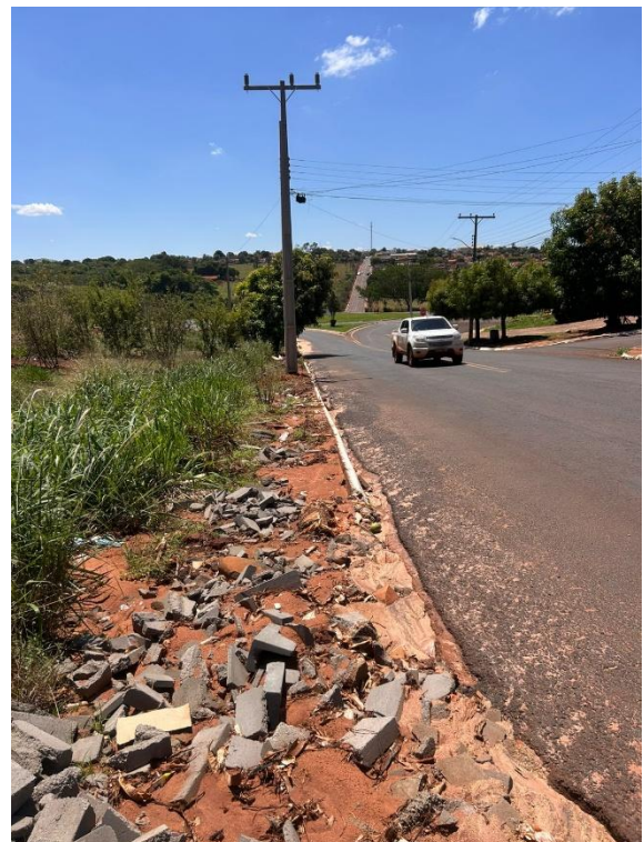
Figura 4.7 - Acúmulo de entulho no espaço destinado à calçada.
