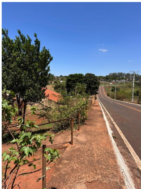
Figura 4.16 - Trecho urbano sem guarda-corpo em área de desnível.
