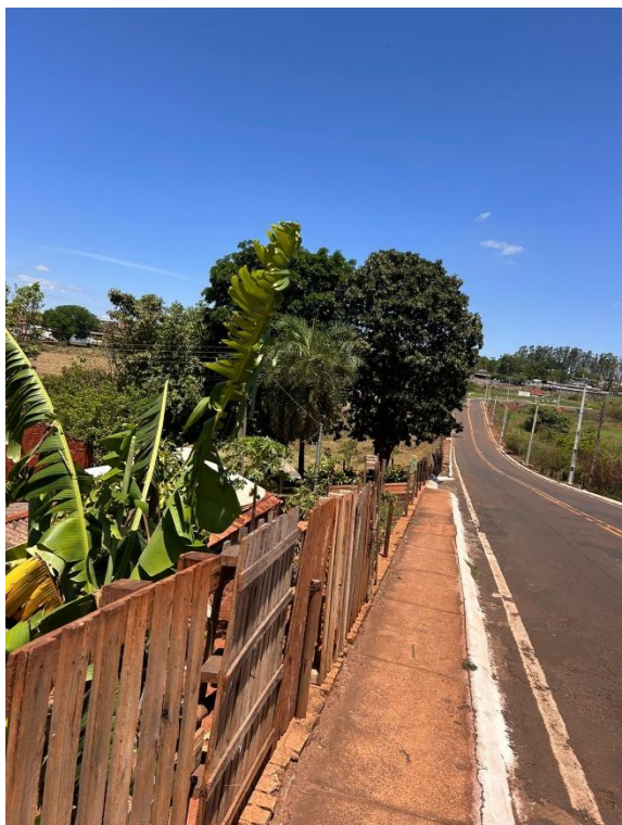
Figura 4.15 - Trecho com ausência de barreira de contenção lateral para pedestres.
