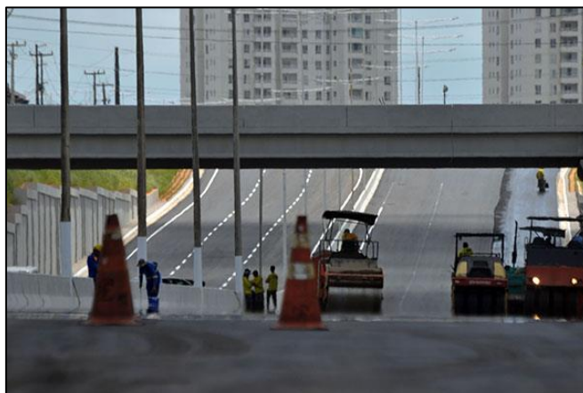
Figura 3 - Obra de implantação de passagem inferior em área urbana.
