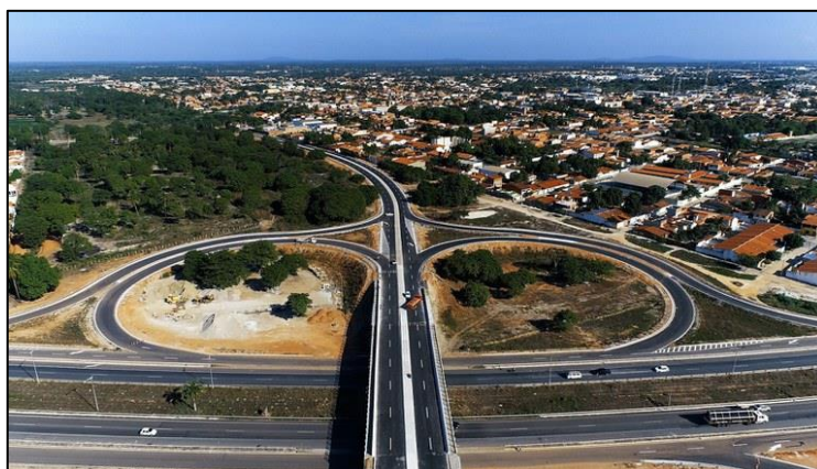
Figura 2 - Viaduto implantado na rodovia BR-116/CE com alças de acesso laterais.
