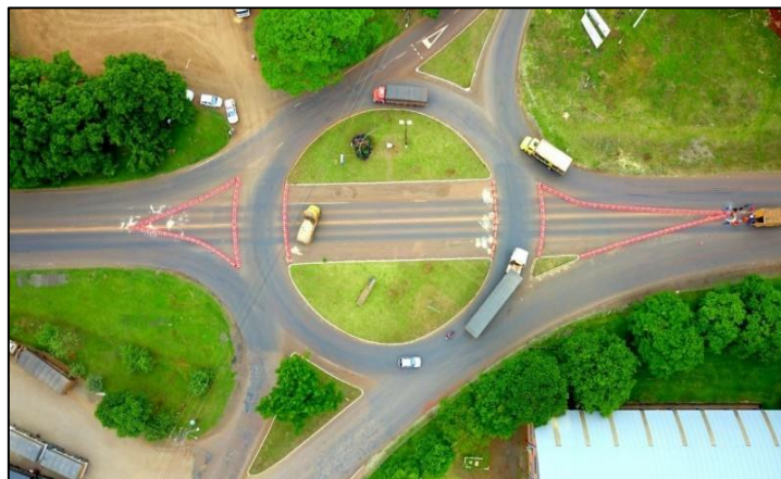
Figura 10 - Rótula vazada em entroncamento urbano (ERS344 com BRS 472, Santa Rosa - RS).
