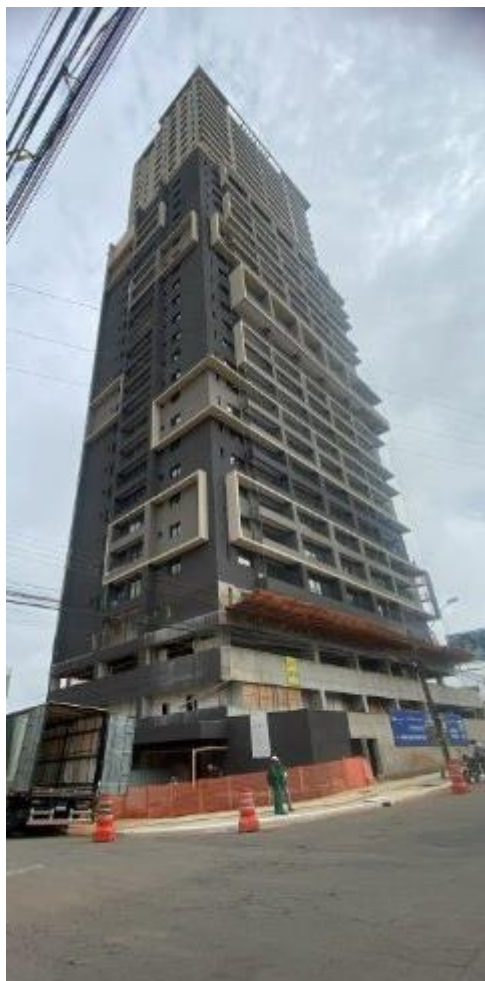
Figura 3.1: fotografia das fachadas frontal e esquerda do edifício.
