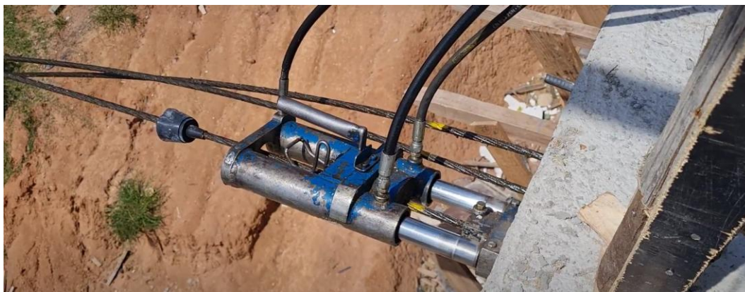
Figura 9 – Atuador hidráulico (macaco de protensão)
