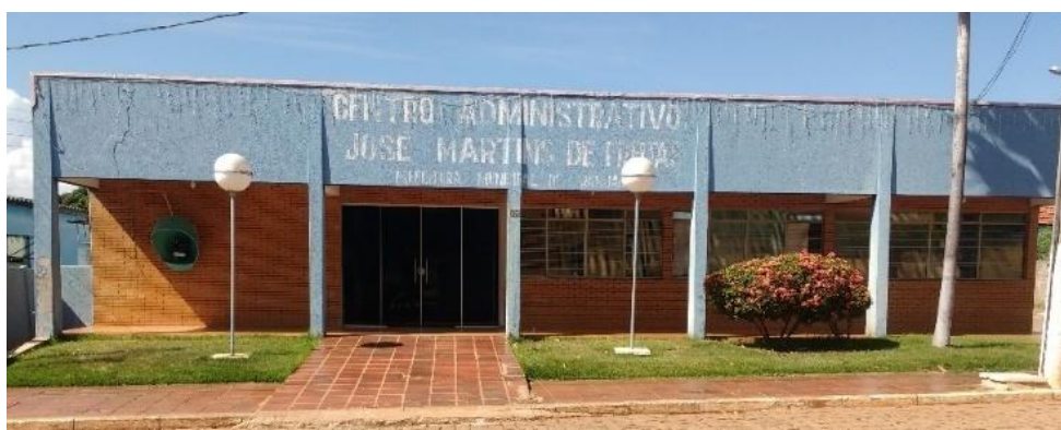
Figura 5: Edificação da Prefeitura Municipal de Varjão-GO.
