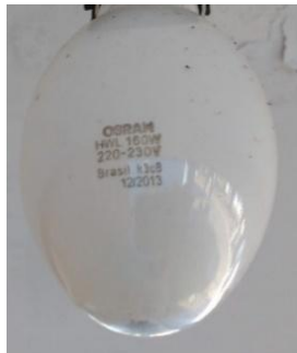
Figura 9: Lâmpada vapor de mercúrio na edificação da Prefeitura Municipal de Varjão-GO.
