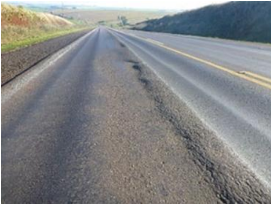
Figura 2. 6 – Afundamento
