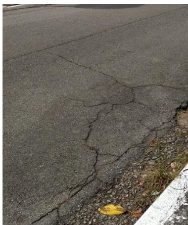
Figura 2. 5 – Trincas
