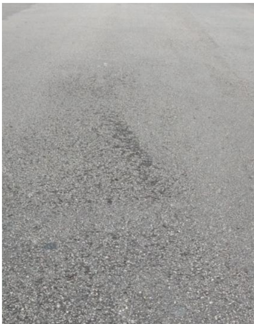
Figura 2. 9 – Desgaste
