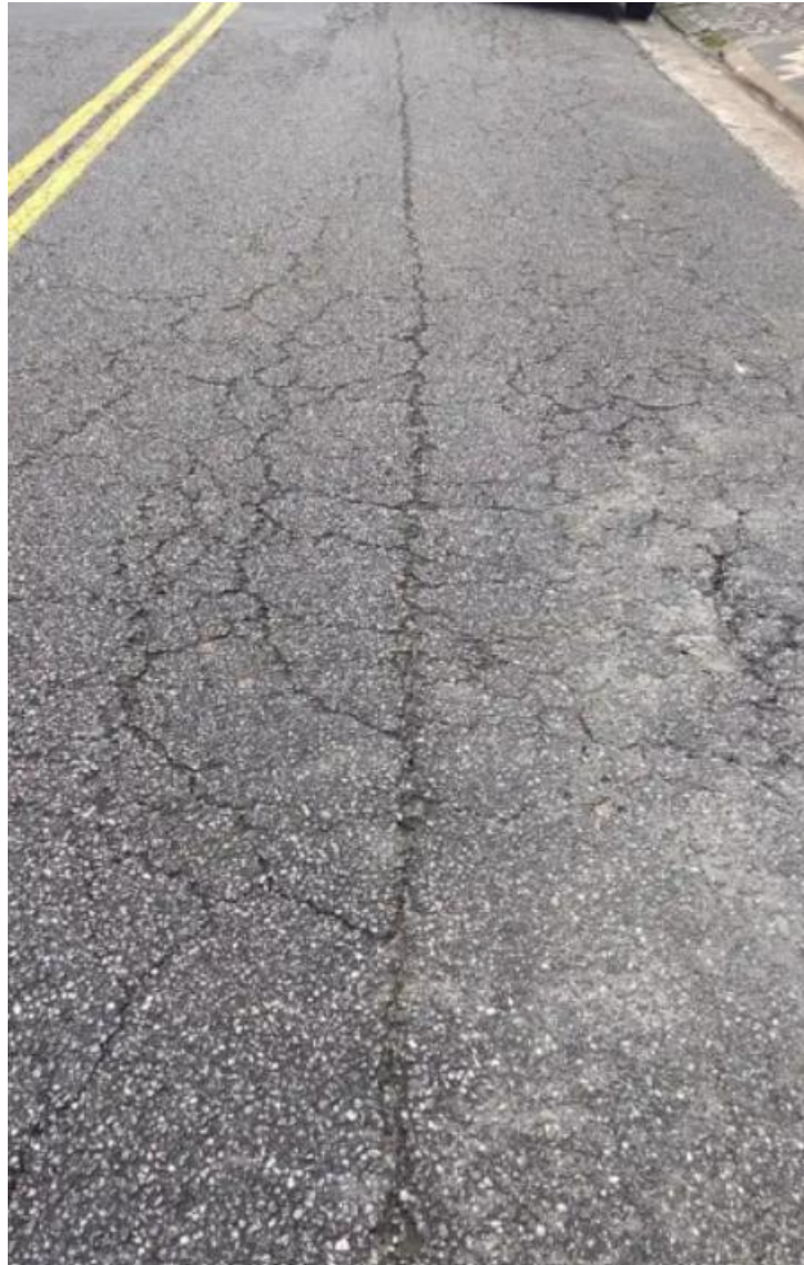
Figura 2. 11 – Trinca Longitudinal
