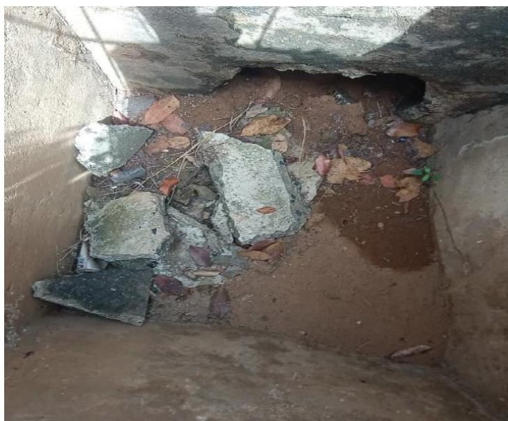
Figura 4. 23 – Interior de bueiro do residencial
