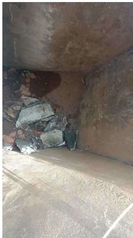
Figura 4. 8 – Condição interna do Bueiro
