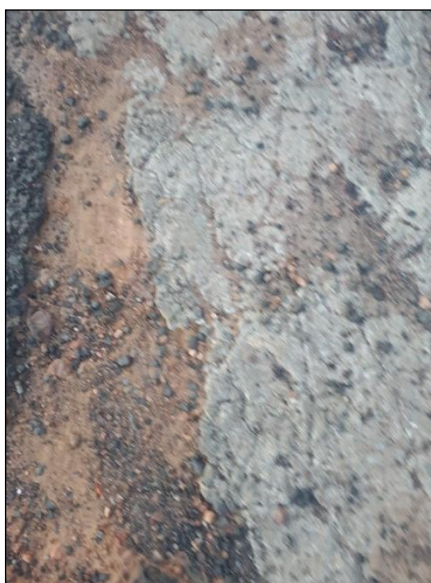
Figura 4. 9 – Desgaste da Via
