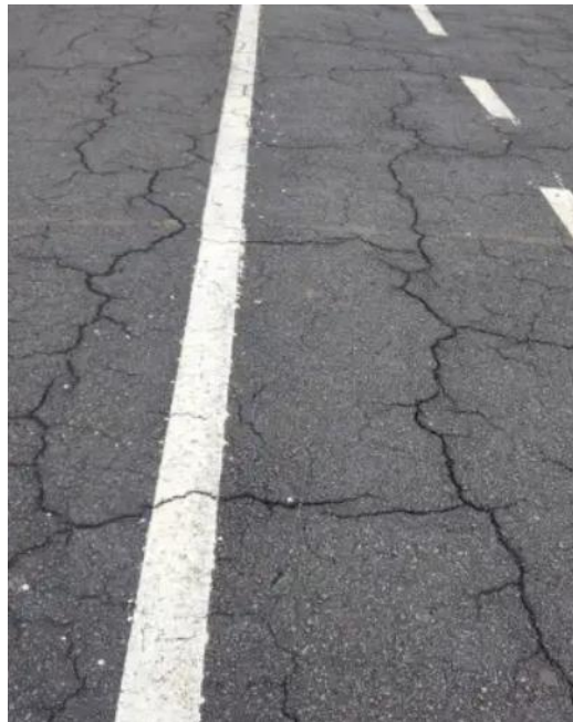
Figura 2. 12 – Trinca de Bloco
