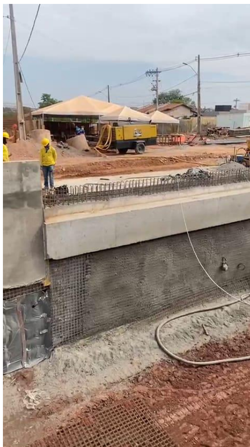
Figura 3.32 - Cortina armada em fase de pré-execução
