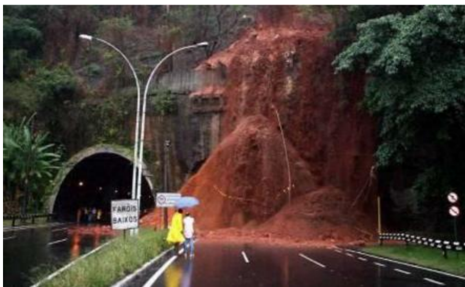
Figura 2.17 - Deslizamento de um talude sem contenção
