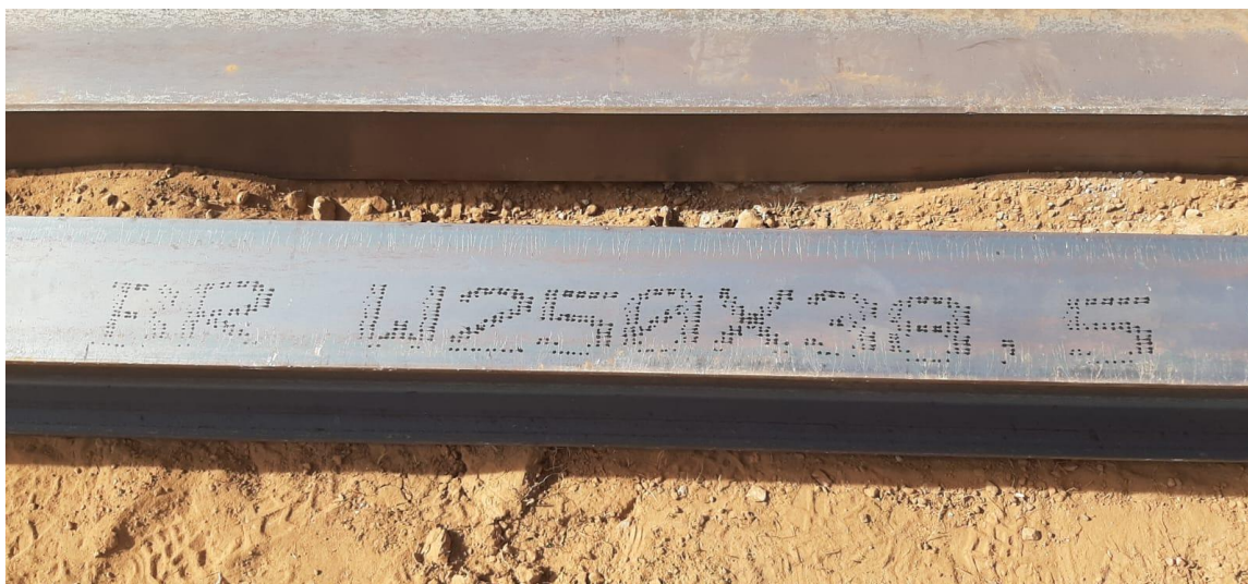
Figura 3.15 - Identificação em campo de perfil metálico da série W
