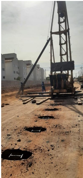
Figura 3.20 - Içamento do perfil metálico
