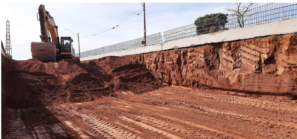
Figura 3.30 - Trecho previamente escavado
