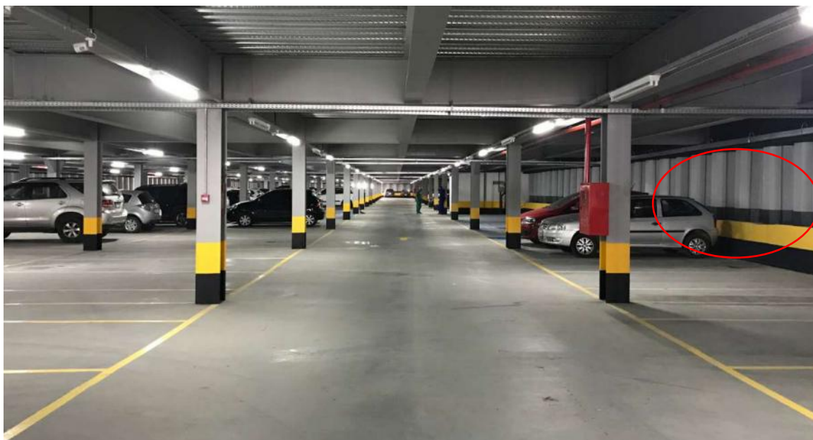
Figura 2.29 - Uso de estaca prancha em subsolo no Rio de Janeiro
