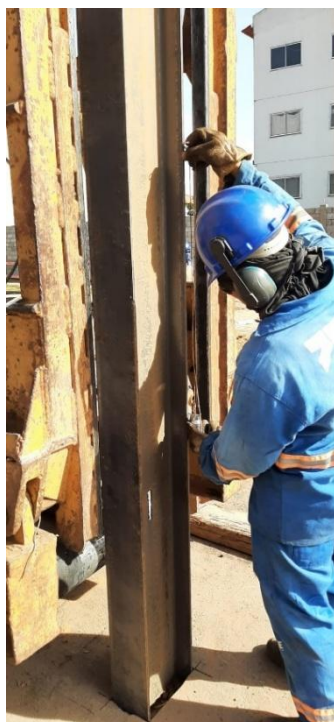
Figura 3.22 - Verificação do prumo
