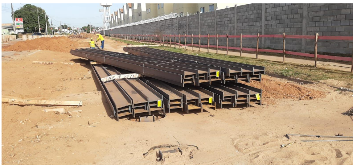
Figura 3.18 - Perfis metálicos posicionados ao longo da trincheira, antes da cravação
