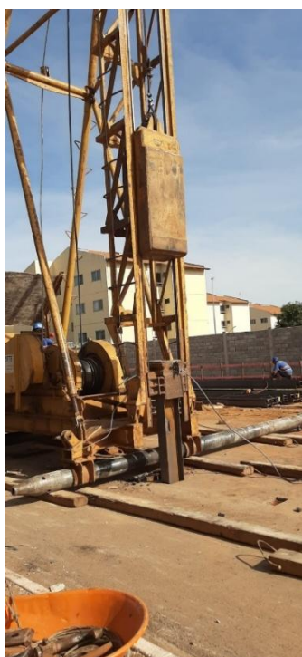
Figura 3.23 - Cravação do perfil
