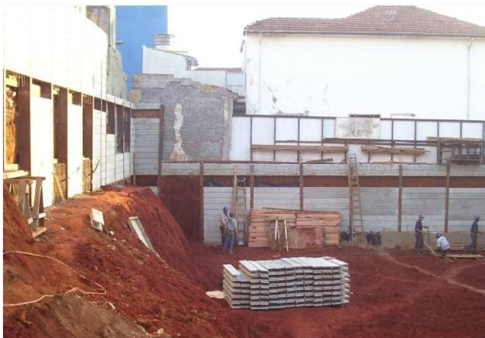
Figura 2.26 - Cortina tipo perfil pranchado em construção
