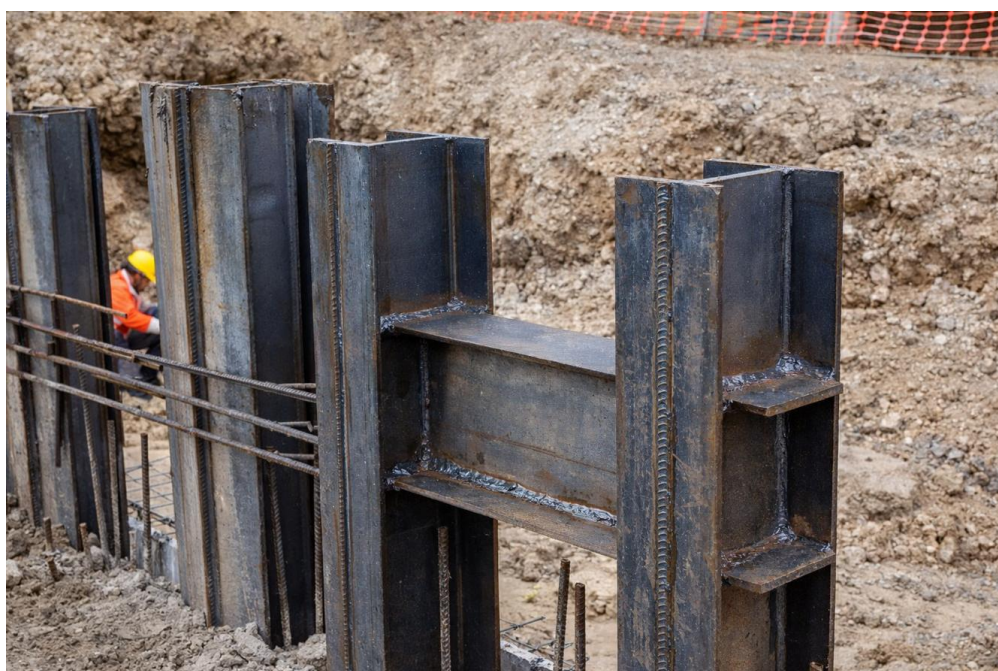
Figura 2.13 - Perfil Soldado - Coluna e vigas soldadas (CVS)
