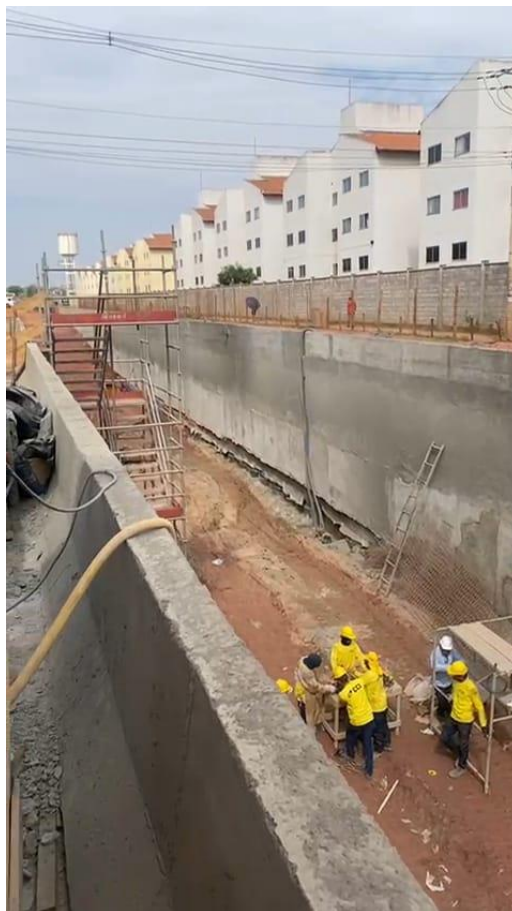
Figura 3.33 - Cortina armada após a conclusão da concretagem
