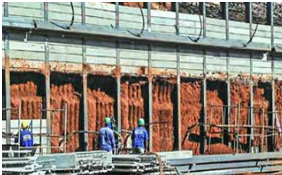
Figura 2.3 - Execução de contenção em perfil metálico - Concessionária GM/Uberlândia-MG
