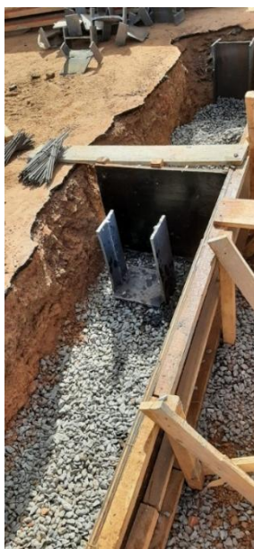
Figura 3.28 - Molde para a viga
