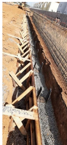
Figura 3.29 - Molde para a viga
