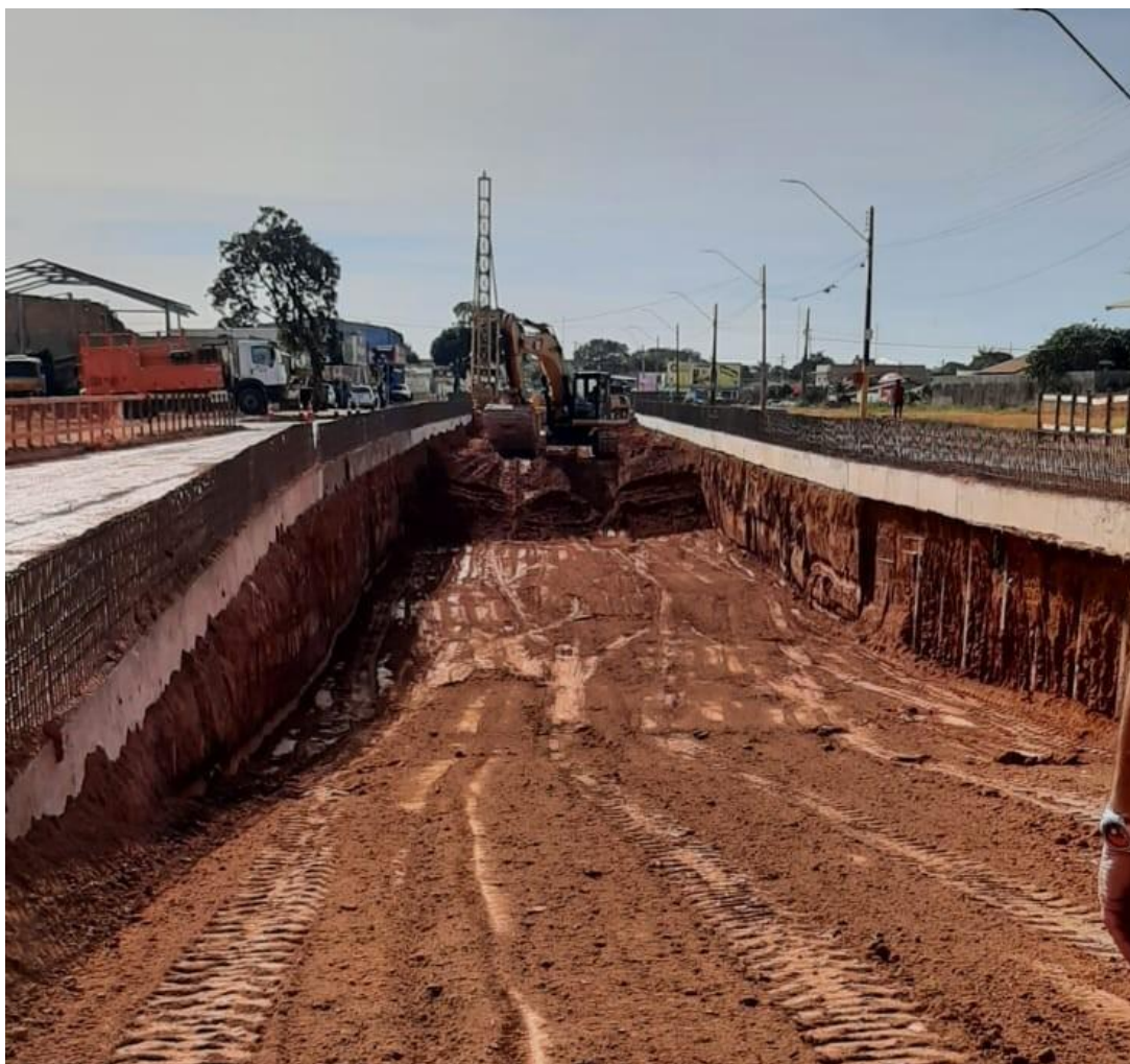
Figura 3.2 - Escavação parcial da trincheira
