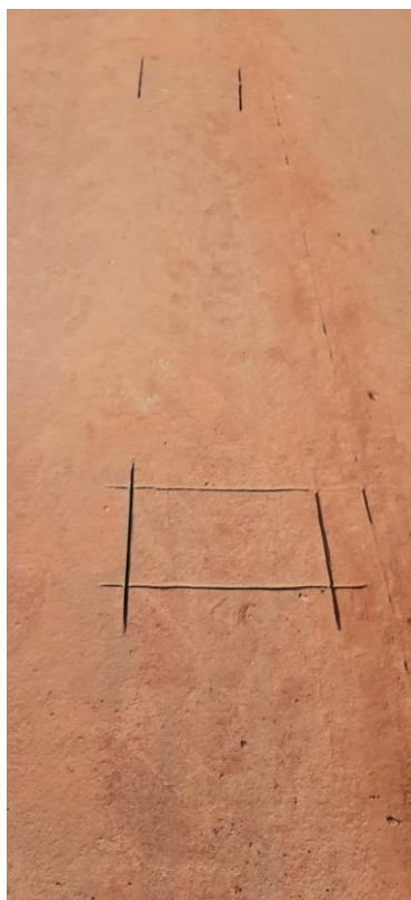
Figura 3.19 - Locação dos pontos de cravação no pavimento asfáltico
