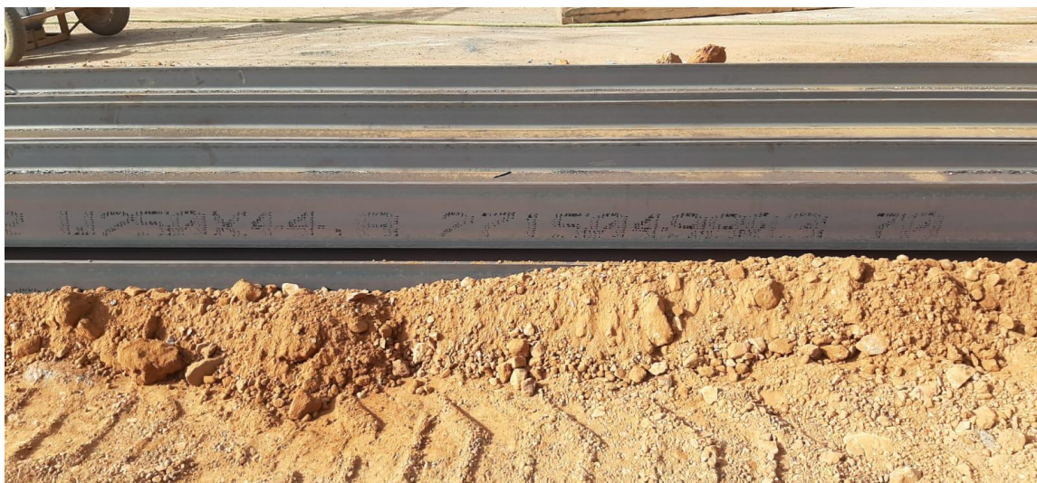
Figura 3.17 - Detalhe dos perfis metálicos da série W utilizados na contenção
