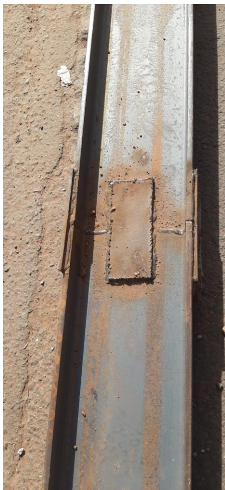
Figura 3.24 - Detalhes de emendas soldadas
