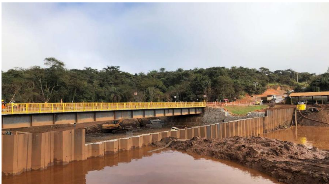
Figura 2.28 - Contenção de rejeitos em Brumadinho, MG por estacas-prancha
