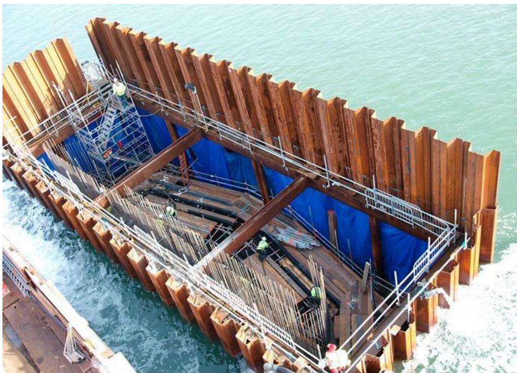
Figura 2.16 - Estacas-prancha aplicadas em meio aquoso
