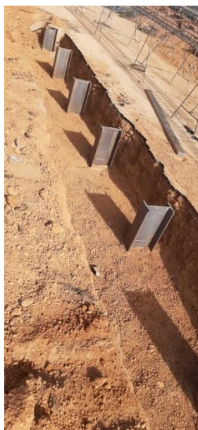
Figura 3.27 - Berço para execução da viga de coroamento
