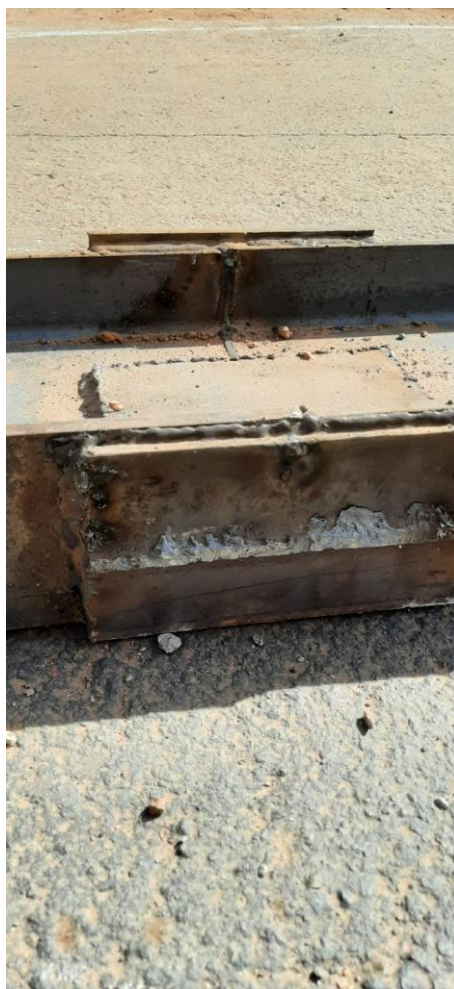
Figura 3.25 - Detalhes de emendas soldadas
