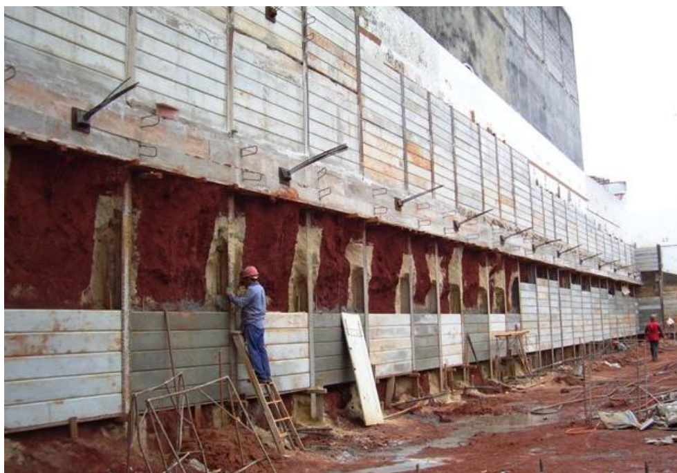
Figura 2.27 - Cortina tipo perfil pranchado multiapoiada por tirantes
