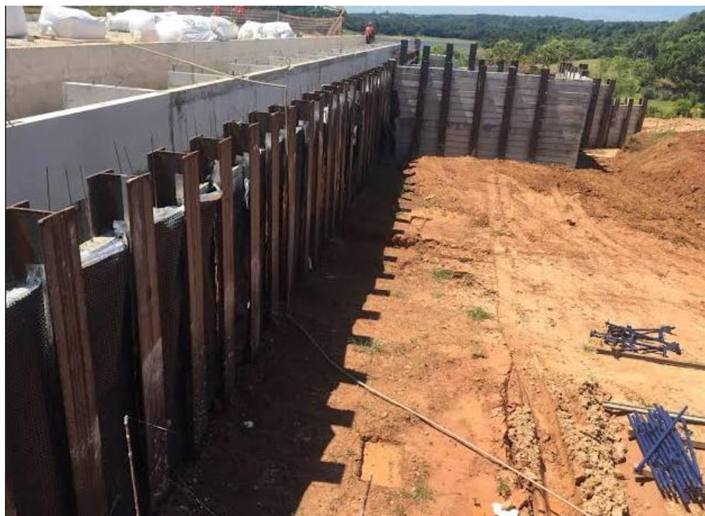
Figura 2.11 - Cortina de contenção com perfil laminado
