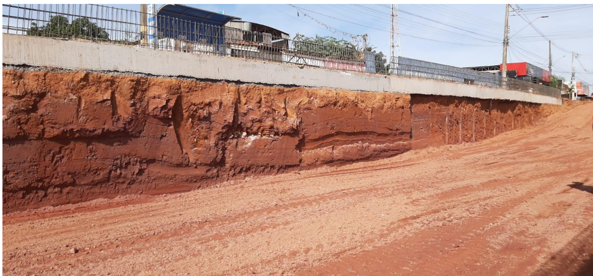
Figura 3.31 - Trecho previamente escavado
