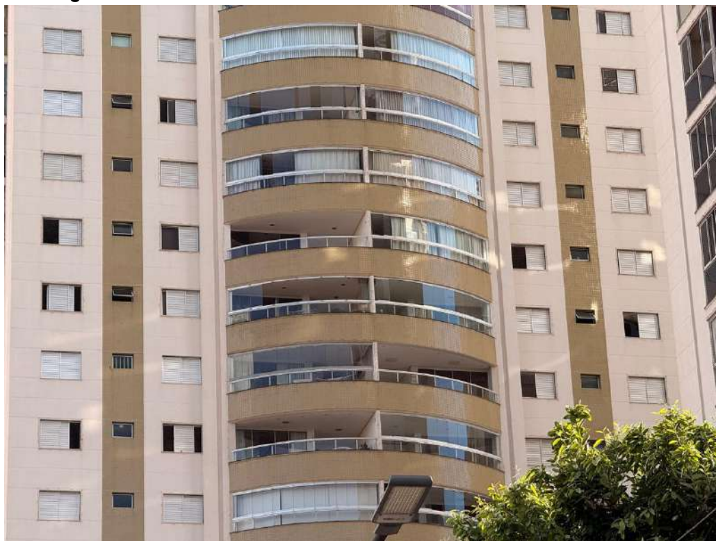
Figura C.3 – Faixa intermediária da fachada norte do edifício Diamante
