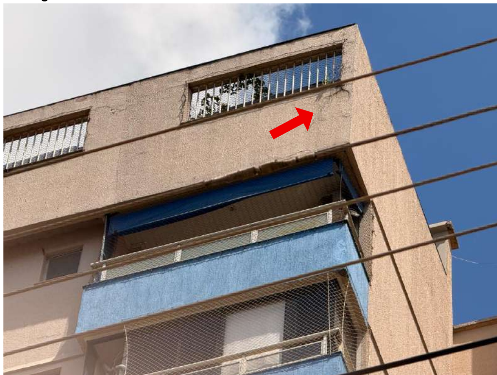
Figura F.27 – Celular: Detalhes da fachada sul do edifício Dom Fernando
