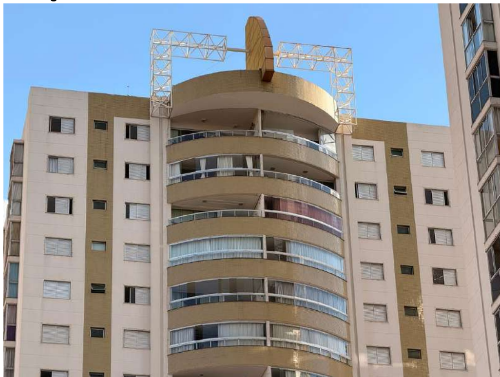
Figura C.4 – Faixa da cobertura da fachada norte do edifício Diamante
