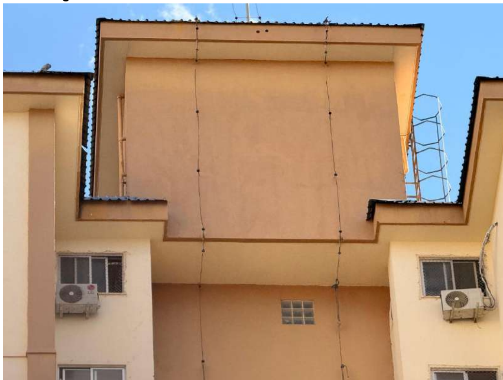
Figura K.6 – Faixa da cobertura da fachada norte do edifício Pérola
