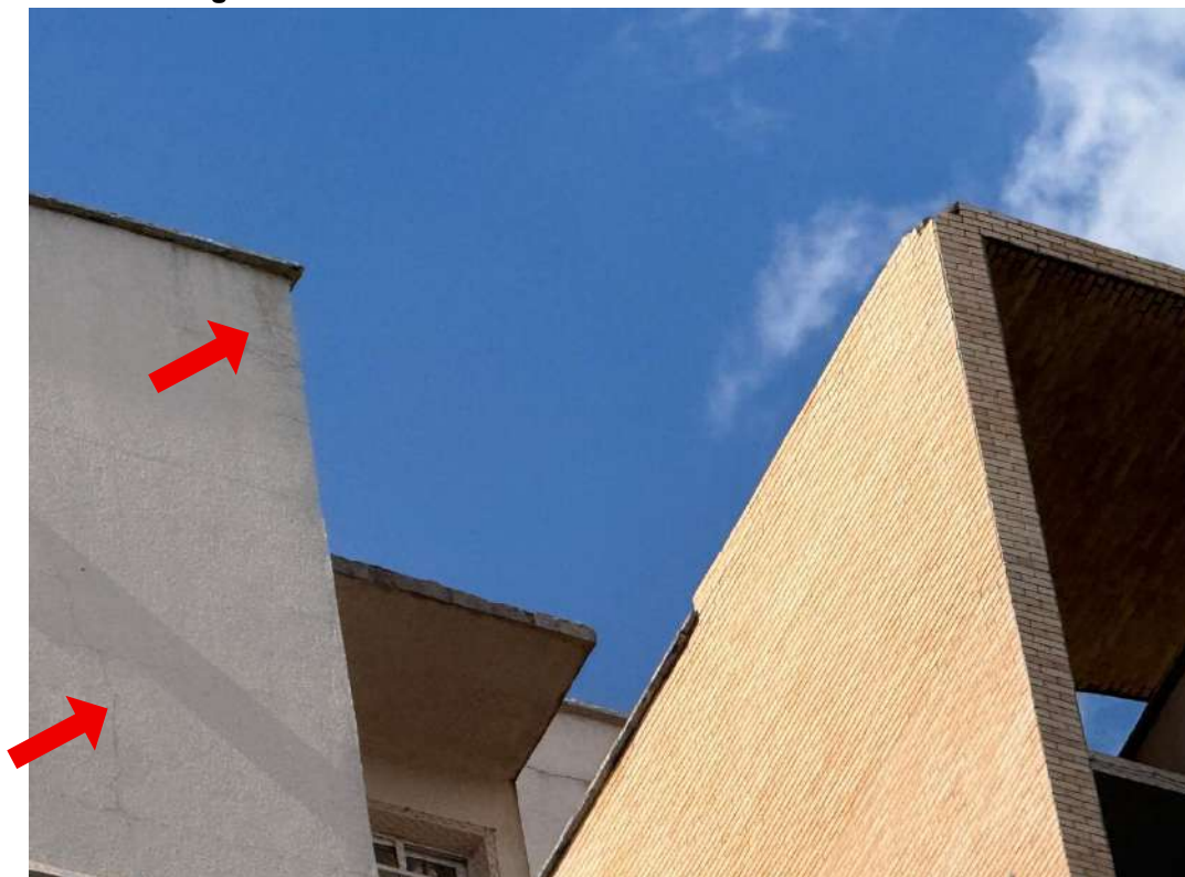
Figura J.13 – Detalhes da fachada sul do edifício Terra Mundi
