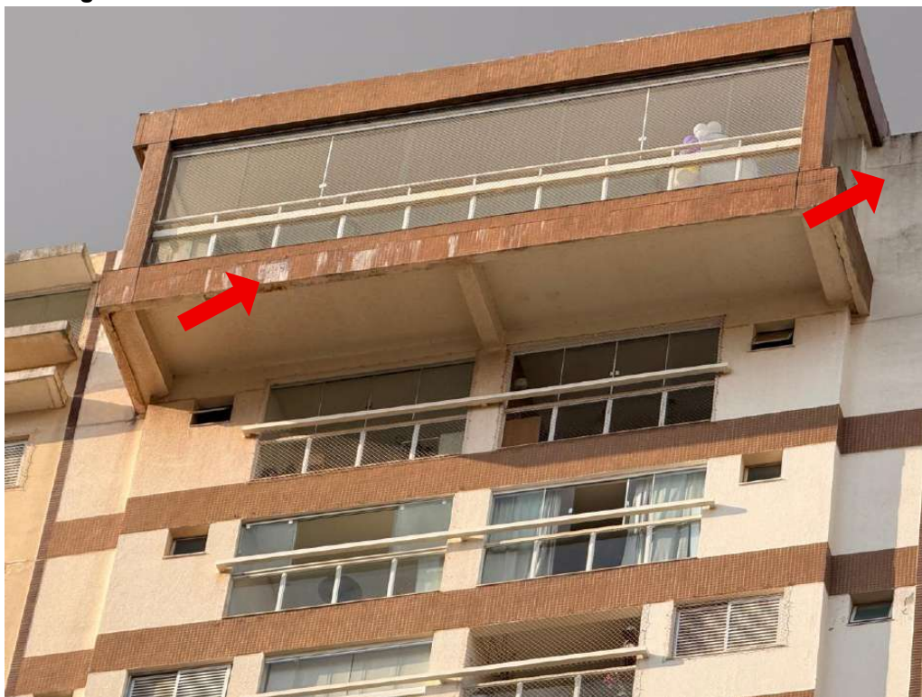
Figura D.6 – Faixa da cobertura da fachada sul do edifício Pedra do Mar
