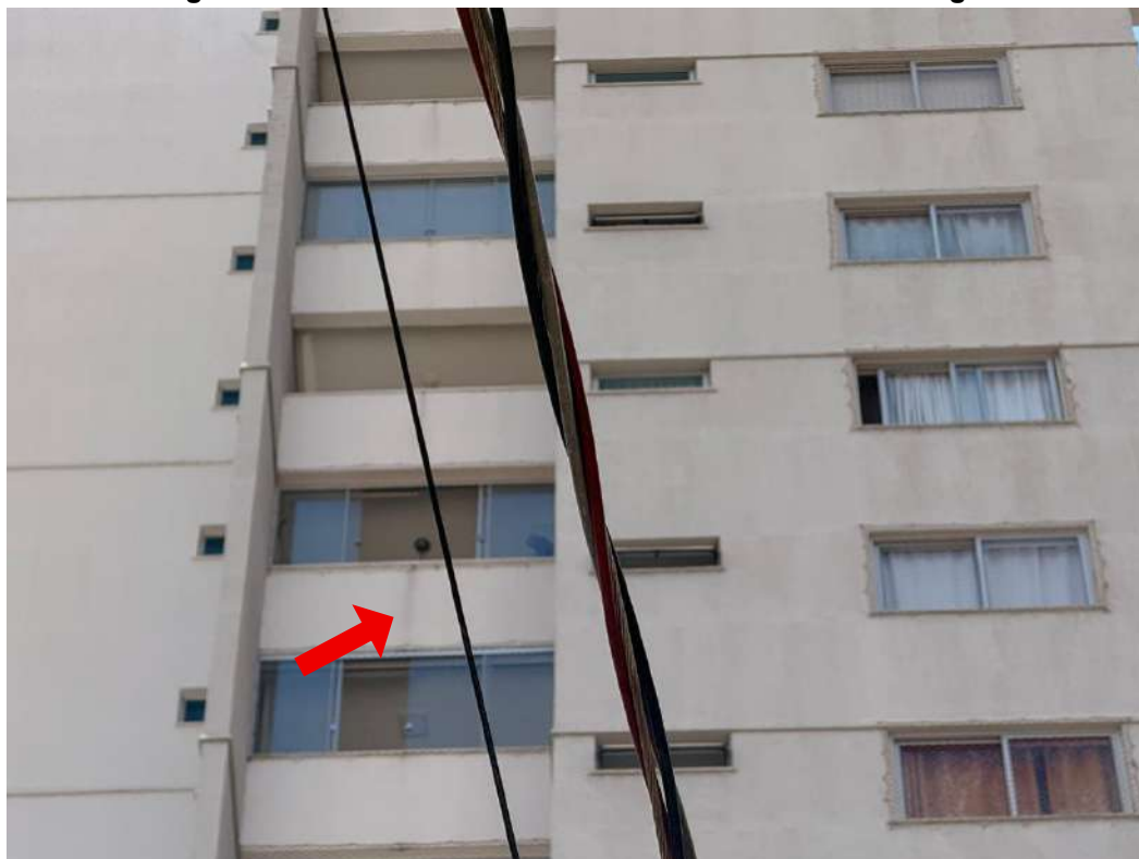
Figura H.7 – Detalhes da fachada norte do edifício Rio Negro
