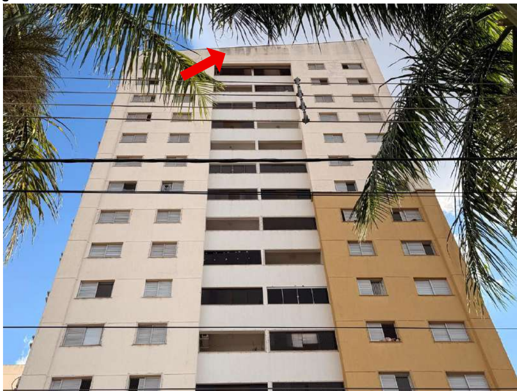
Figura E.2 – Faixa intermediária e cobertura da fachada norte do edifício Pedra do Sol
