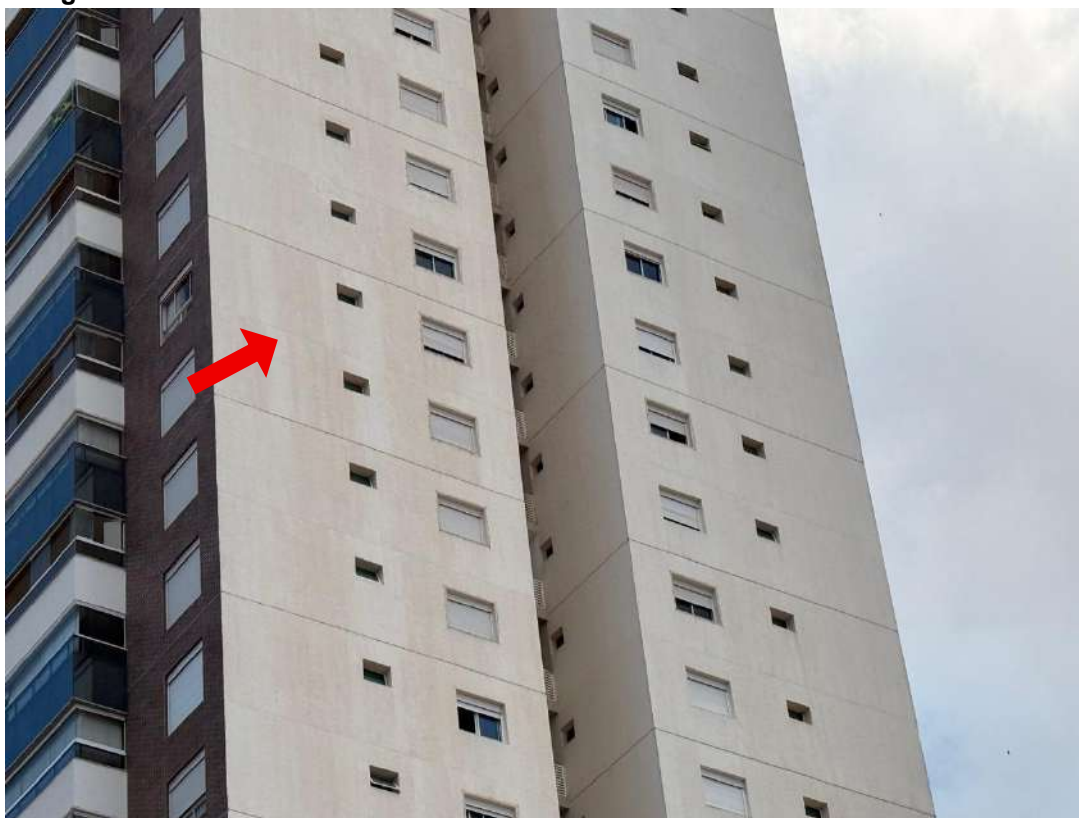
Figura M.16 – Celular: Faixa intermediária da fachada sul do edifício Gran Bueno
