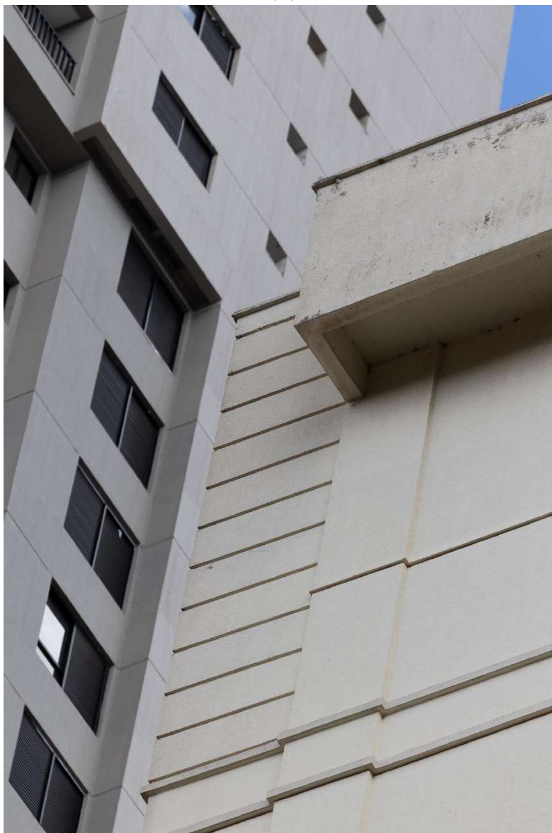
Figura I.9 – Câmera profissional: Faixa da cobertura da fachada norte do edifício Varandas do Buriti
