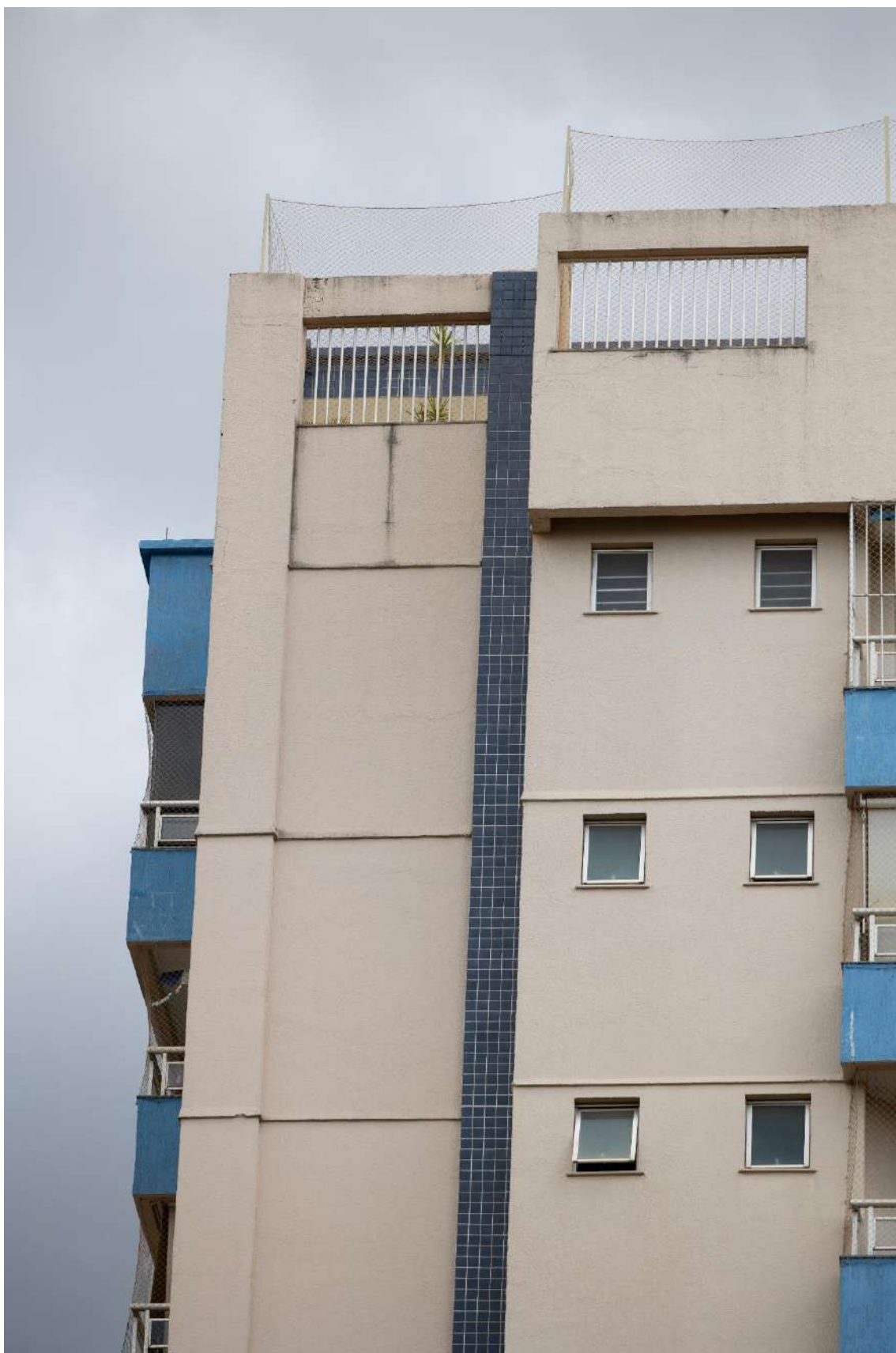
Figura F.8 – Câmera profissional: Faixa da cobertura da fachada norte do edifício Dom Fernando
