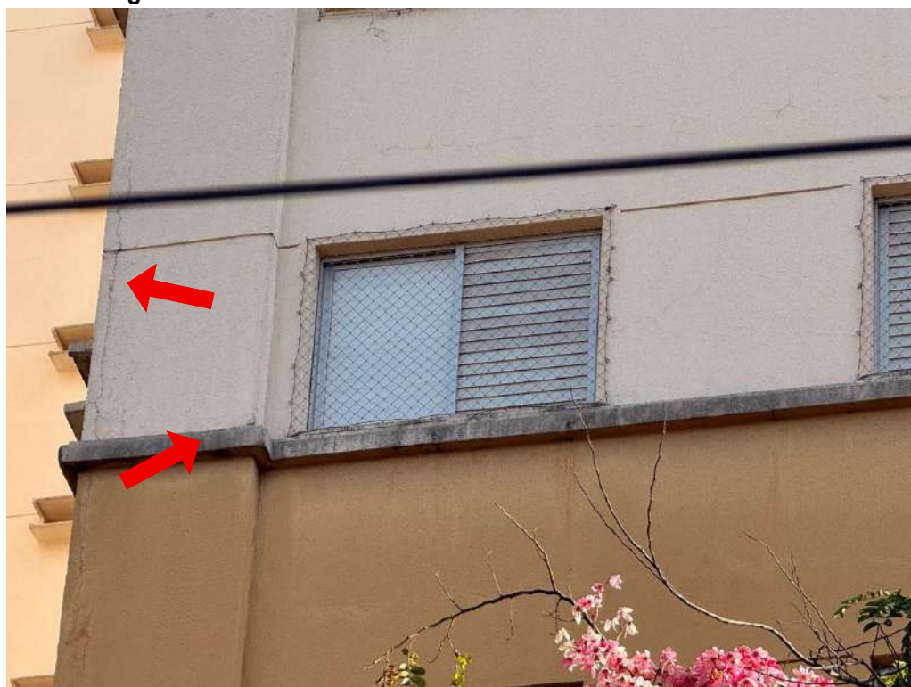
Figura E.5 – Detalhes da fachada norte do edifício Pedra do Sol
