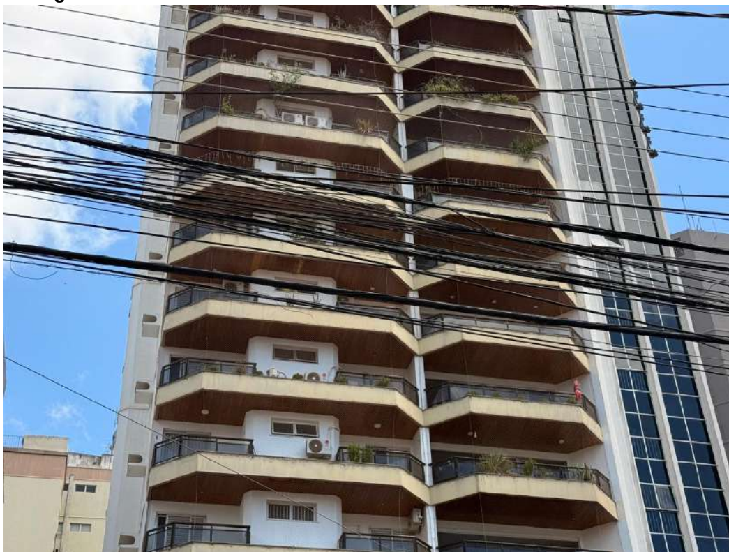
Figura G.11 – Faixa intermediária da fachada sul do edifício Golden Garden
