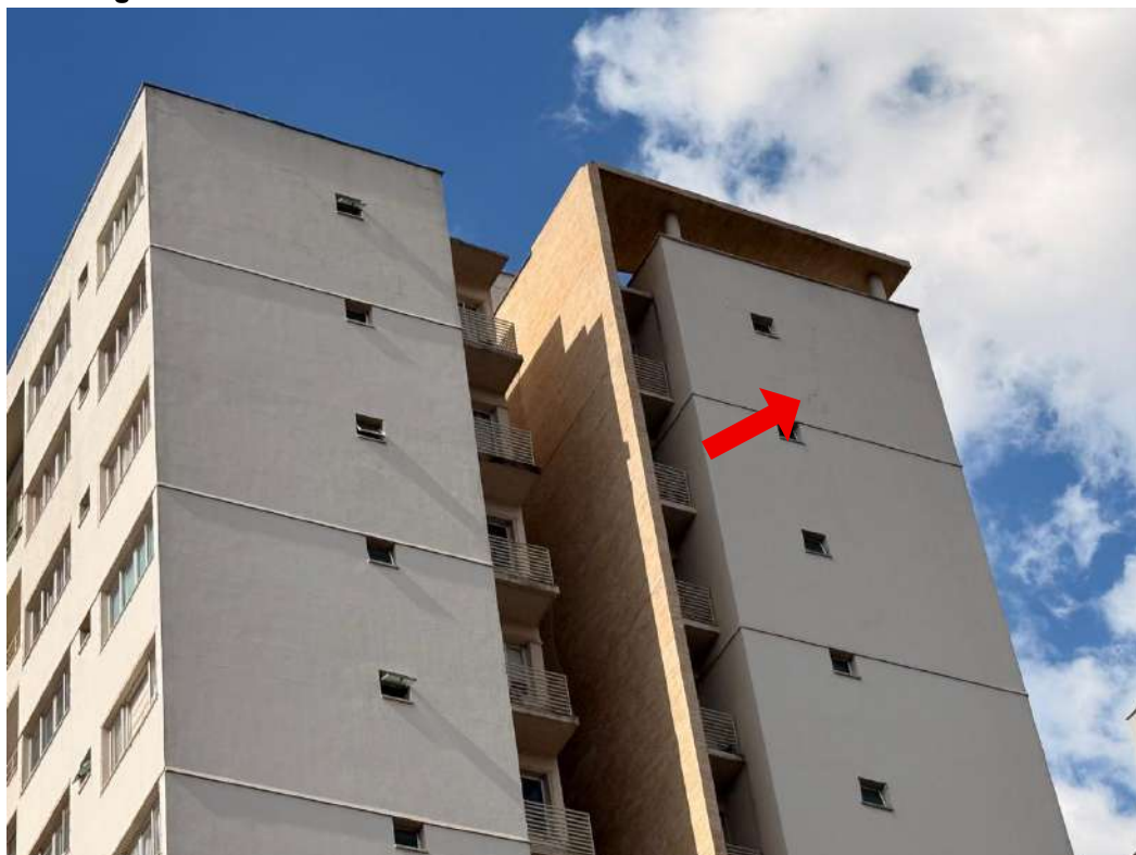
Figura J.11 – Faixa da cobertura da fachada sul do edifício Terra Mundi
