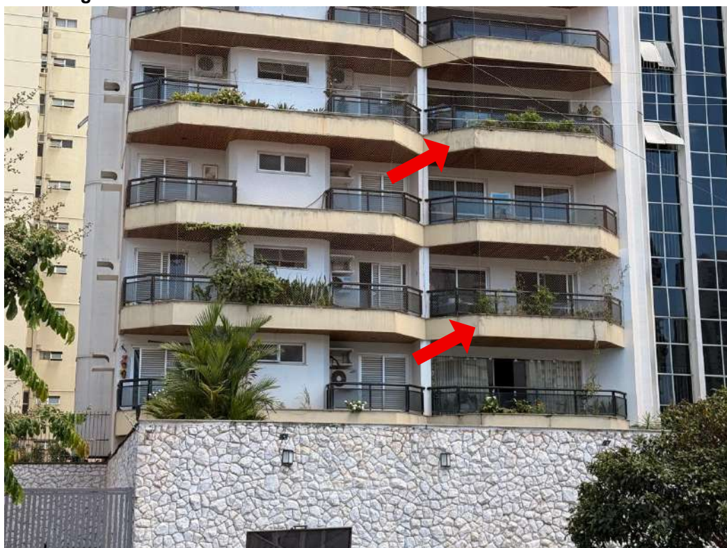
Figura G.10 – Faixa inferior da fachada sul do edifício Golden Garden
