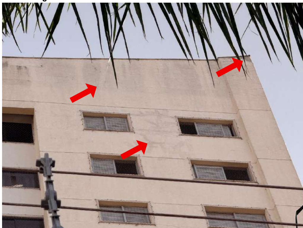
Figura E.4 – Detalhes da fachada norte do edifício Pedra do Sol
