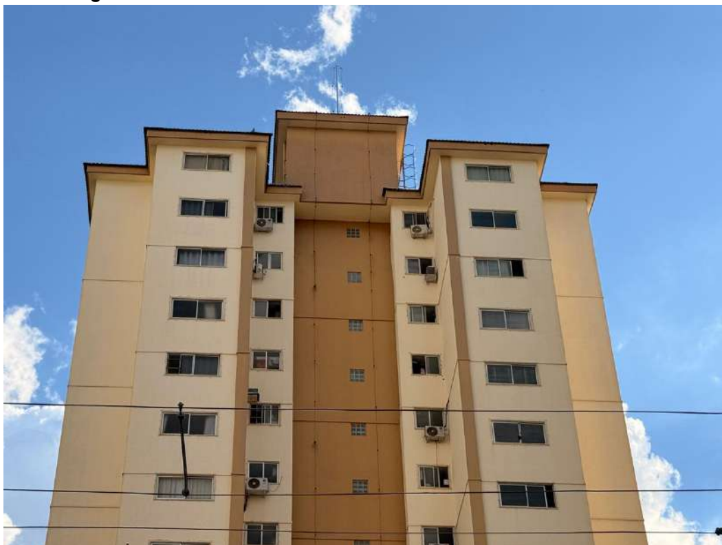
Figura K.4 – Faixa da cobertura da fachada norte do edifício Pérola
