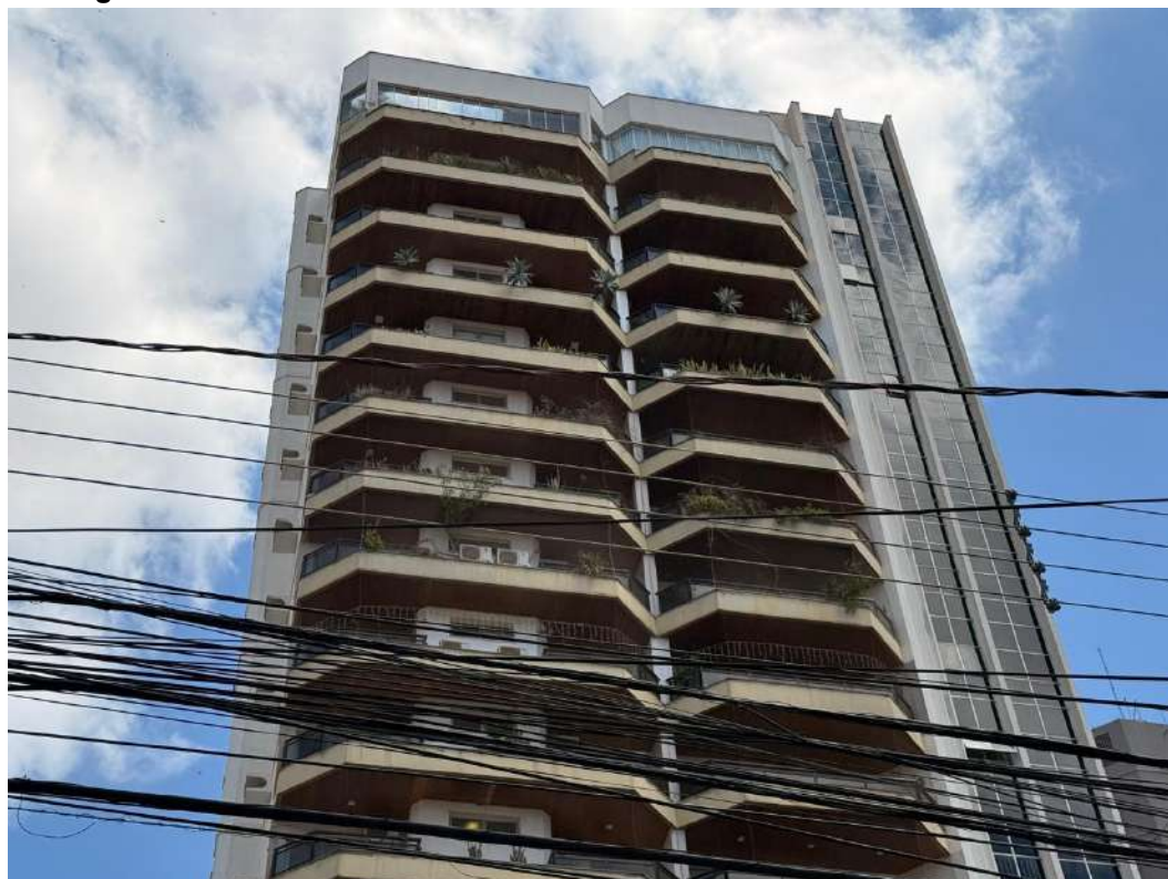
Figura G.12 – Faixa da cobertura da fachada sul do edifício Golden Garden
