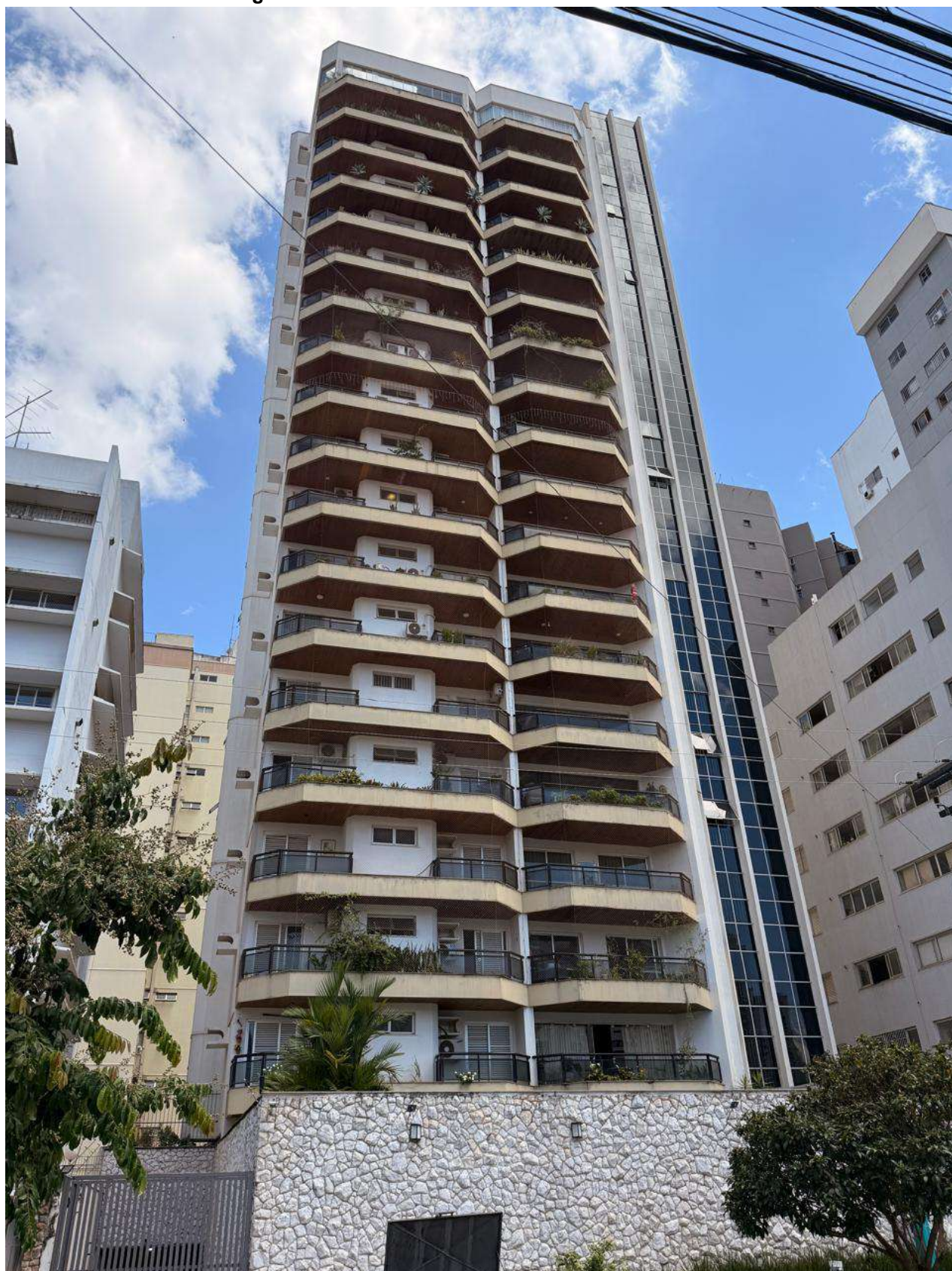
Figura G.9 – Fachada sul do edifício Golden Garden
