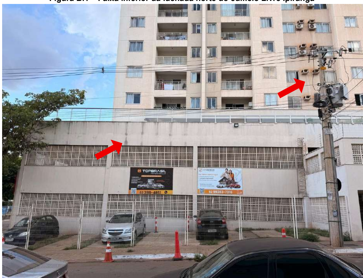
Figura B.1 – Faixa inferior da fachada norte do edifício Livre Ipiranga
