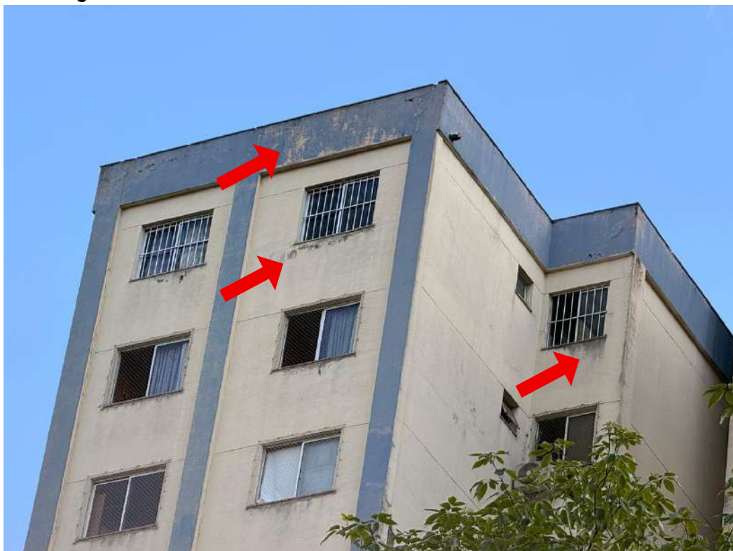
Figura L.15 – Faixa da cobertura da fachada sul do edifício Turmalinas
