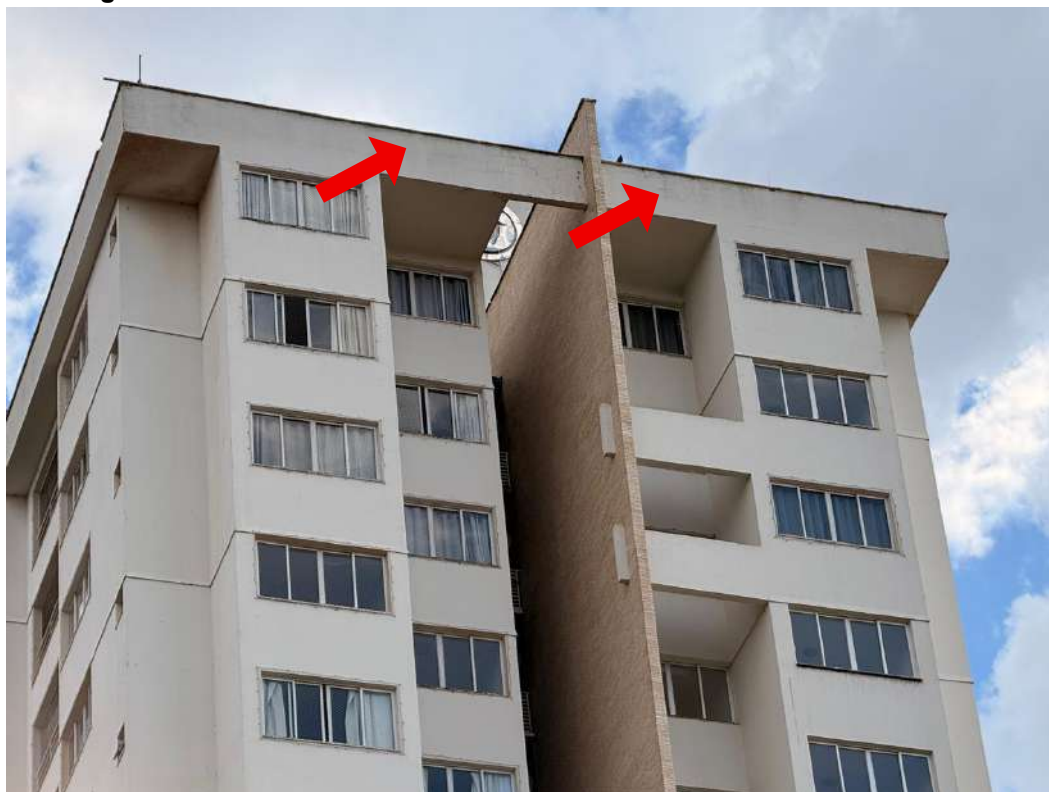
Figura J.4 – Faixa da cobertura da fachada norte do edifício Terra Mundi
