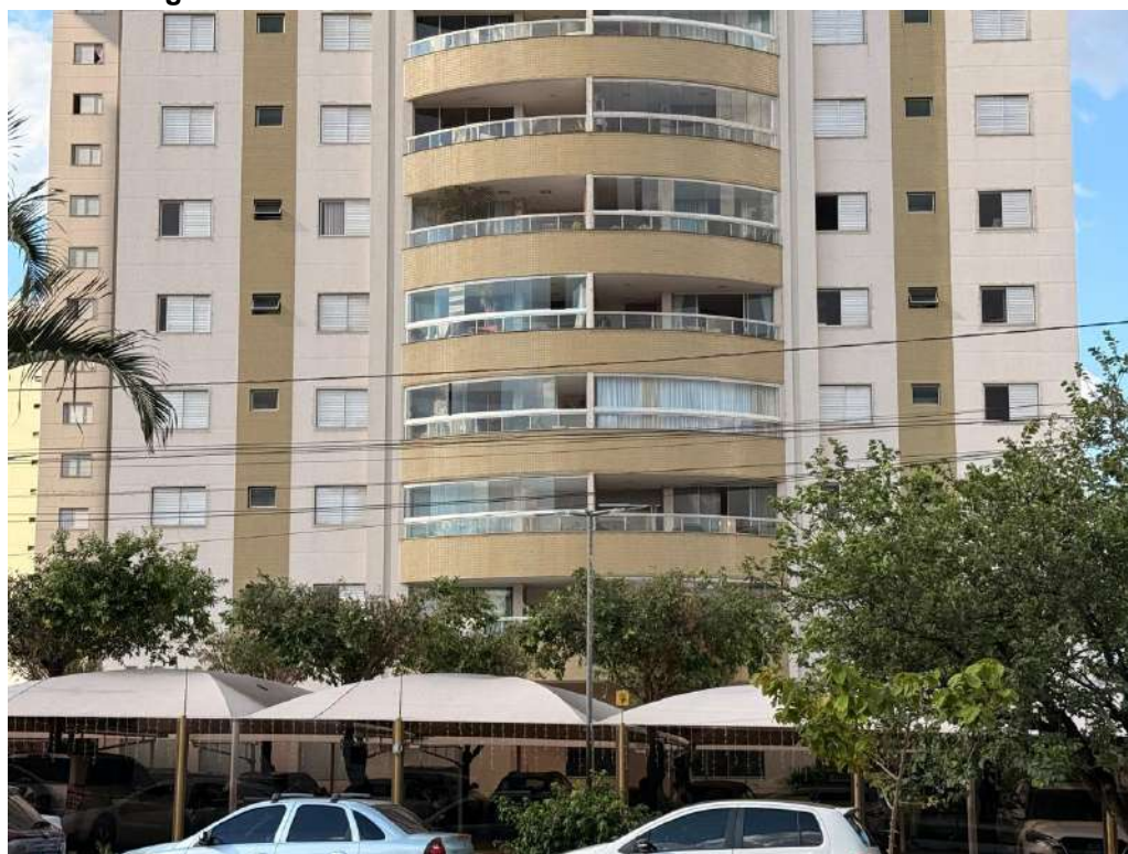
Figura C.9 – Faixa inferior da fachada sul do edifício Diamante
