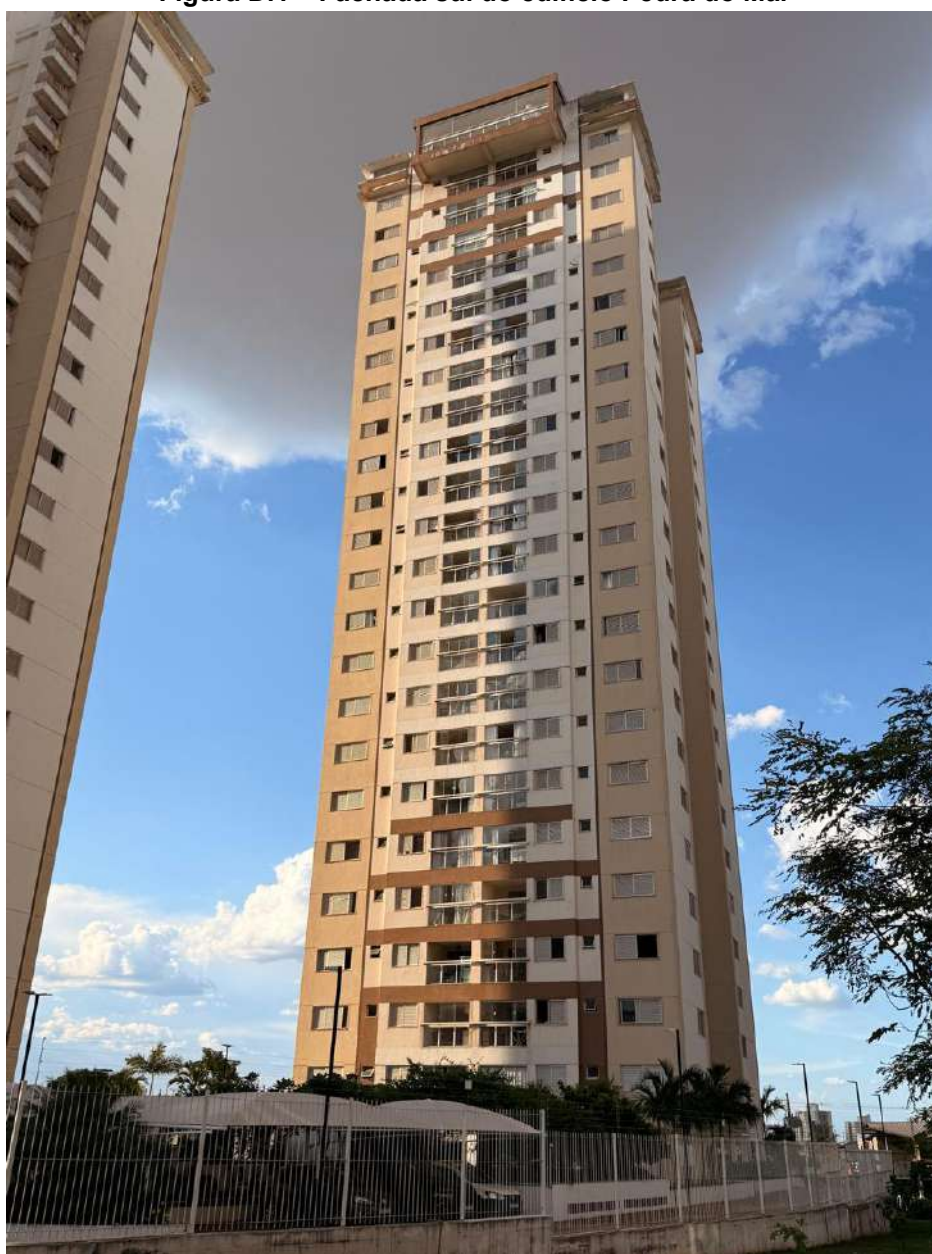
Figura D.1 – Fachada sul do edifício Pedra do Mar
