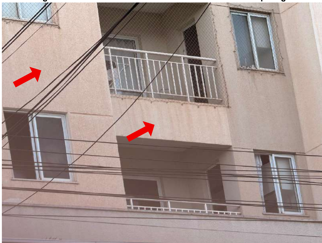
Figura B.6 – Detalhes da fachada norte do edifício Livre Ipiranga
