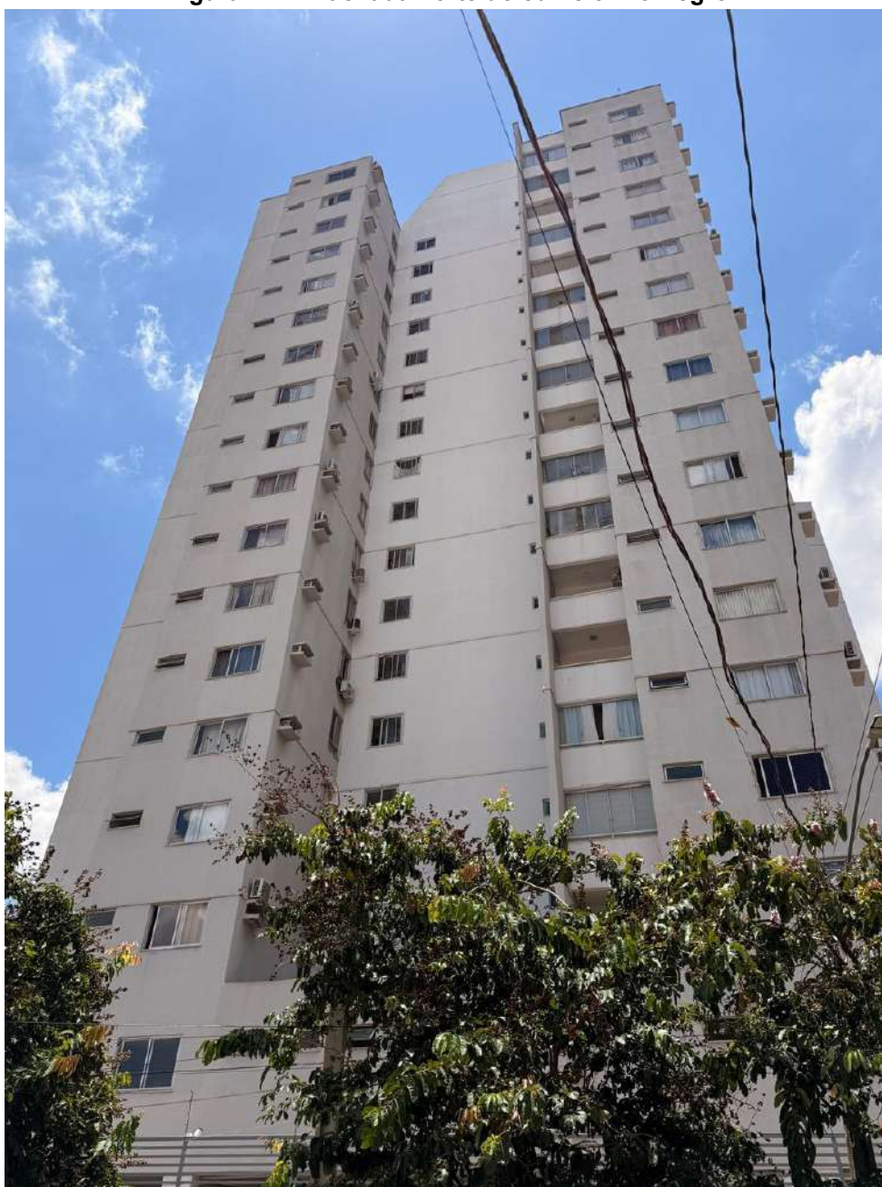
Figura H.1 – Fachada norte do edifício Rio Negro
