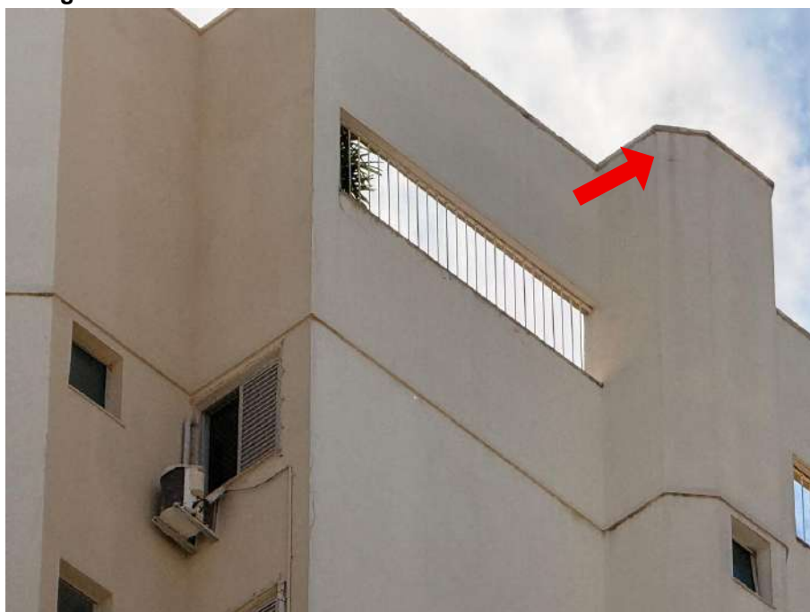
Figura G.8 – Detalhes da fachada norte do edifício Golden Garden
