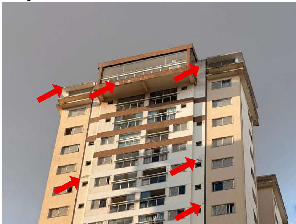
Figura D.4 – Faixa da cobertura da fachada sul do edifício Pedra do Mar
