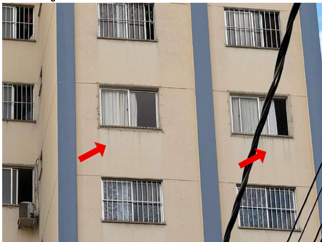
Figura L.8 – Detalhes da fachada norte do edifício Turmalinas
