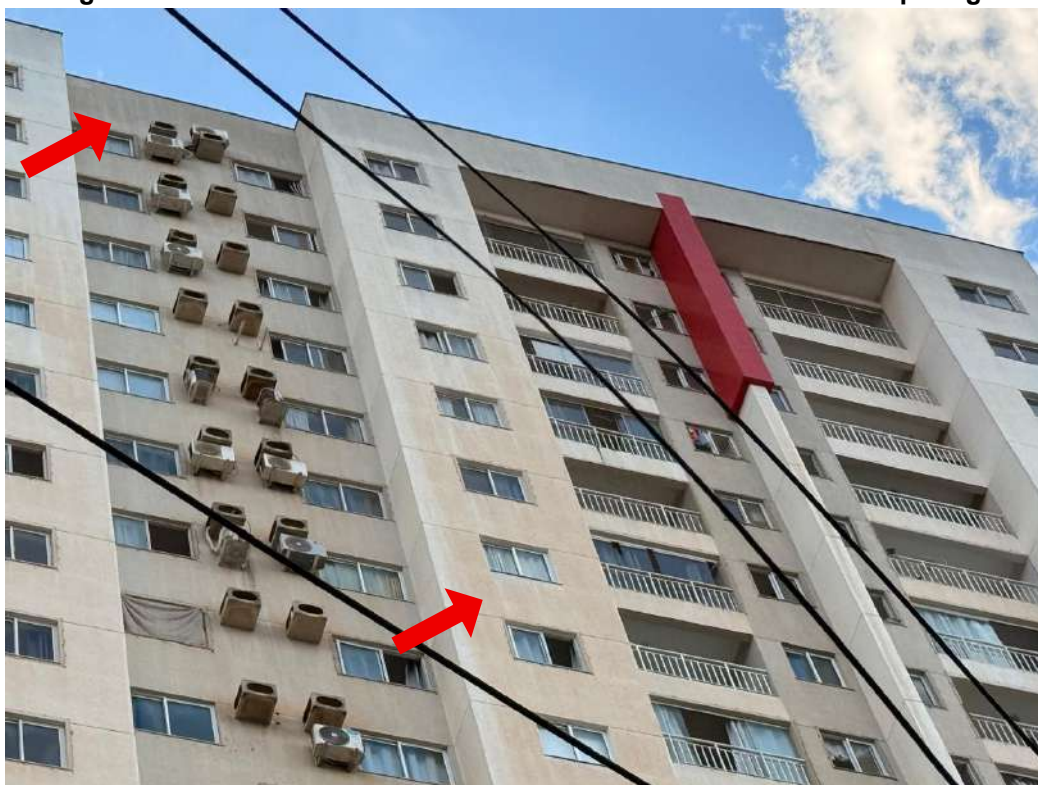
Figura B.4 – Faixa da cobertura da fachada norte do edifício Livre Ipiranga
