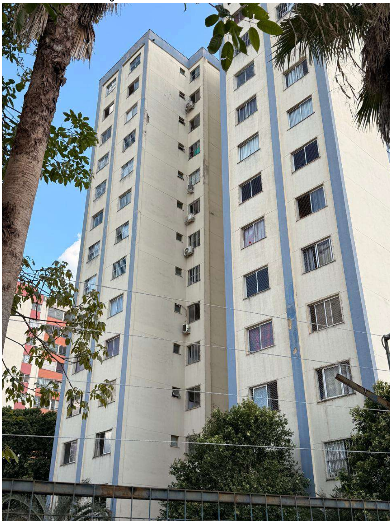
Figura L.10 – Fachada sul do edifício Turmalinas
