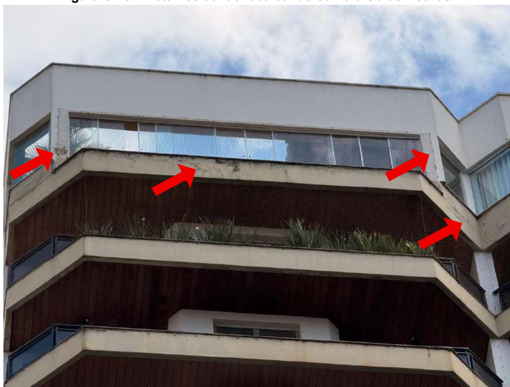
Figura G.15 – Detalhes da fachada sul do edifício Golden Garden
