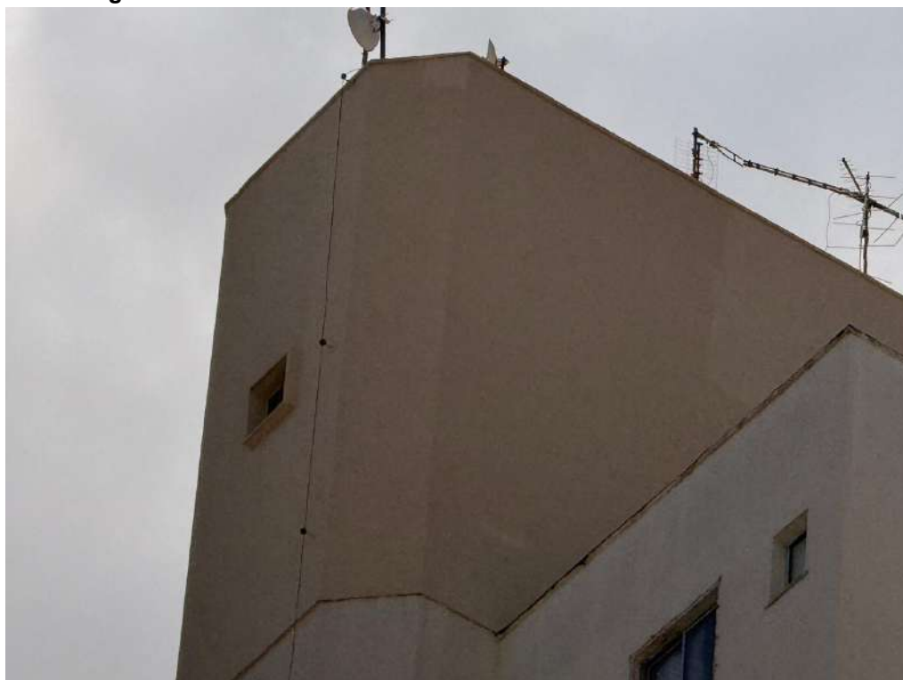
Figura G.5 – Detalhes da fachada norte do edifício Golden Garden
