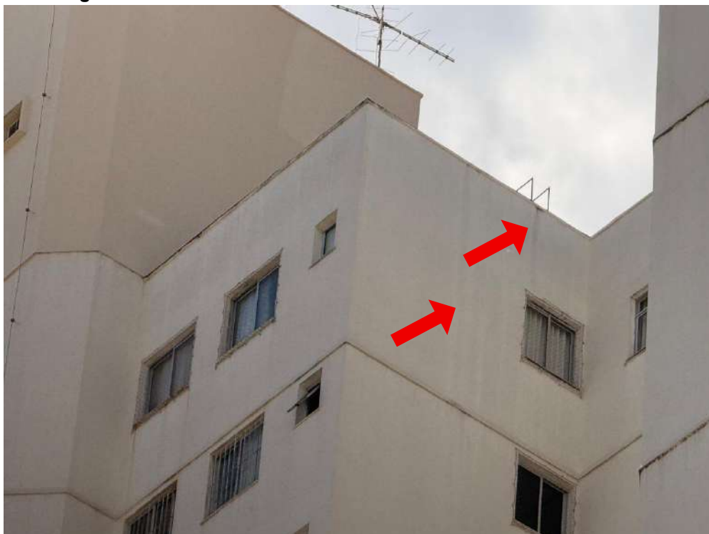
Figura G.6 – Detalhes da fachada norte do edifício Golden Garden
