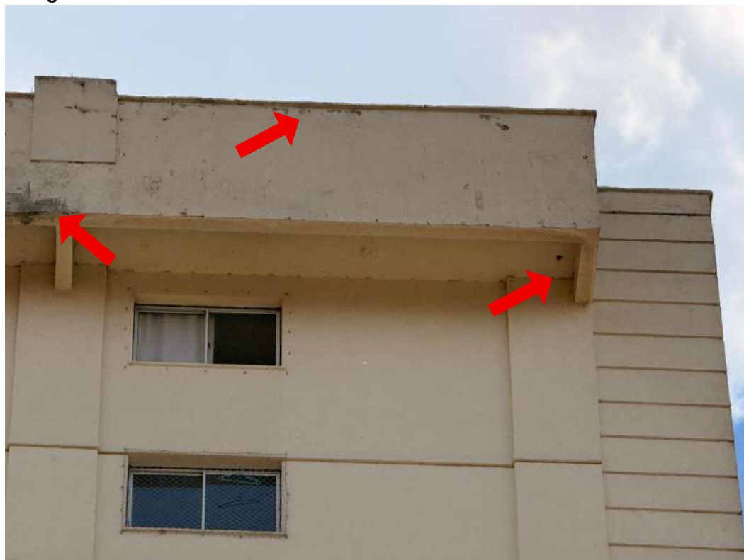
Figura I.11 – Celular: Detalhes da fachada norte do edifício Varandas do Buriti
