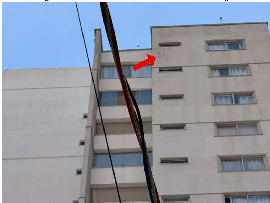
Figura H.6 – Detalhes da fachada norte do edifício Rio Negro
