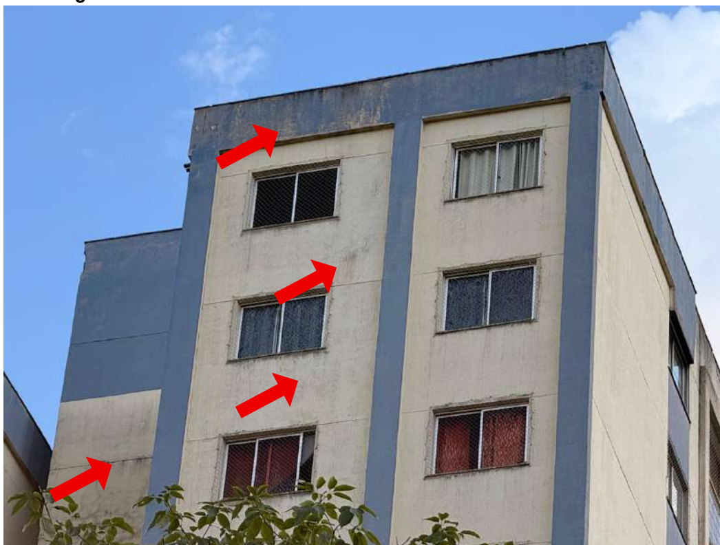
Figura L.16 – Faixa da cobertura da fachada sul do edifício Turmalinas
