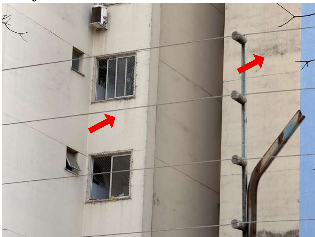
Figura L.13 – Faixa intermediária da fachada sul do edifício Turmalinas
