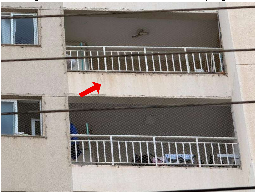
Figura B.5 – Detalhes da fachada norte do edifício Livre Ipiranga
