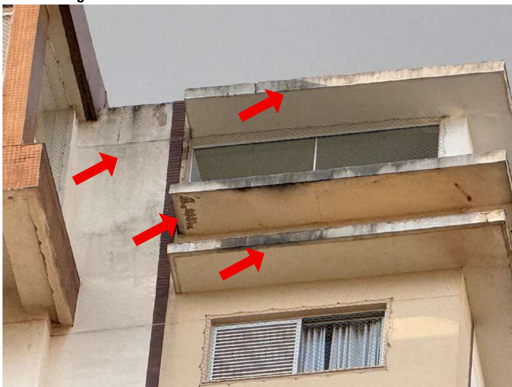
Figura D.7 – Detalhes da fachada sul do edifício Pedra do Mar
