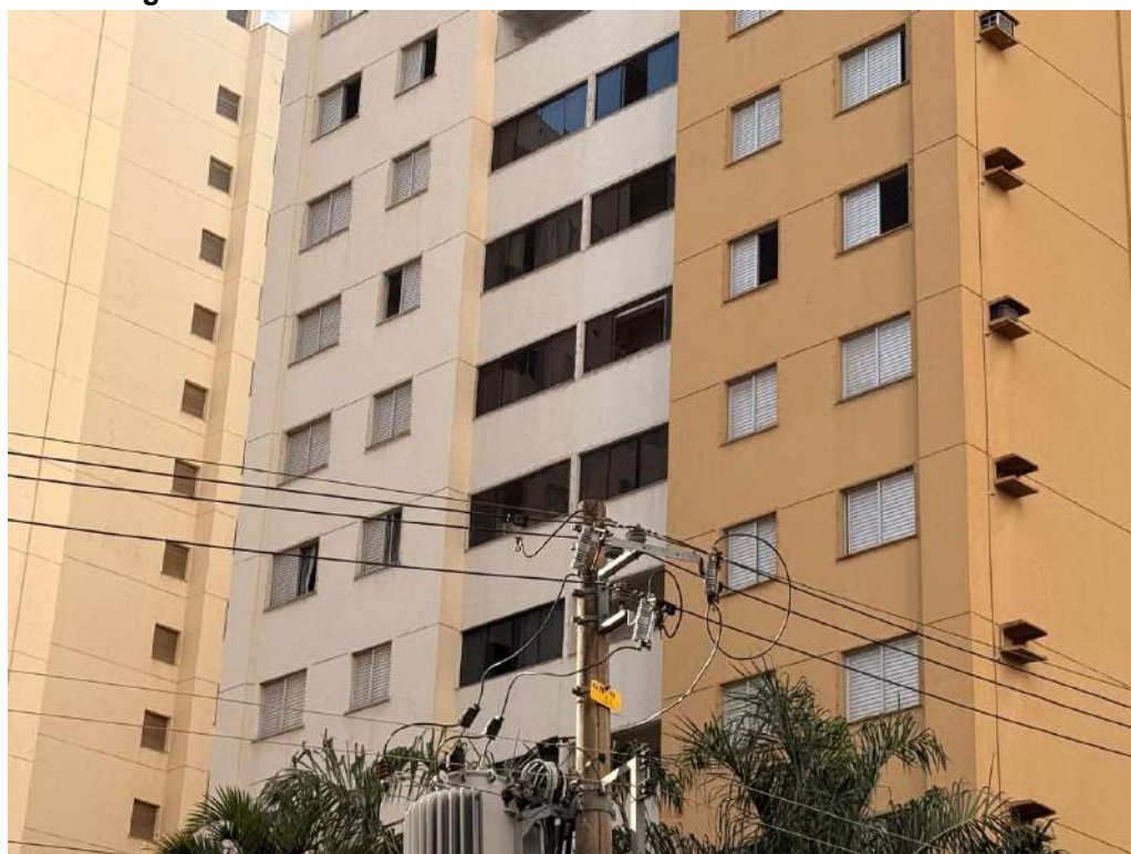
Figura E.8 – Faixa inferior da fachada sul do edifício Pedra do Sol
