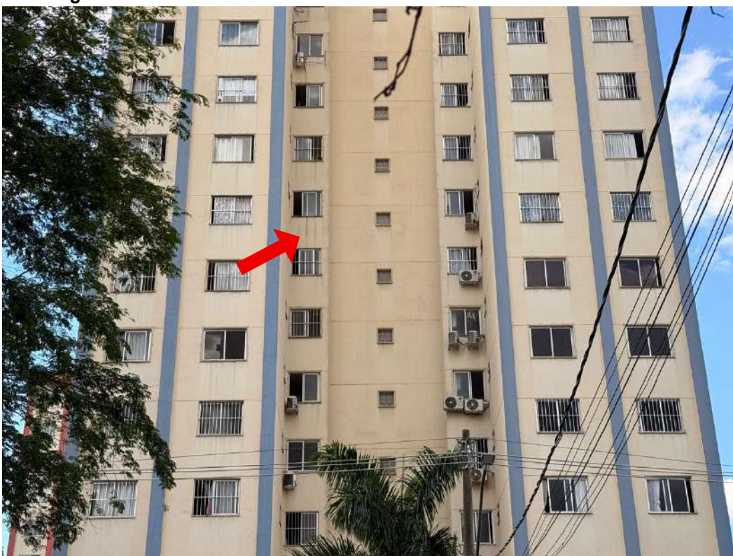
Figura L.3 – Faixa intermediária da fachada norte do edifício Turmalinas
