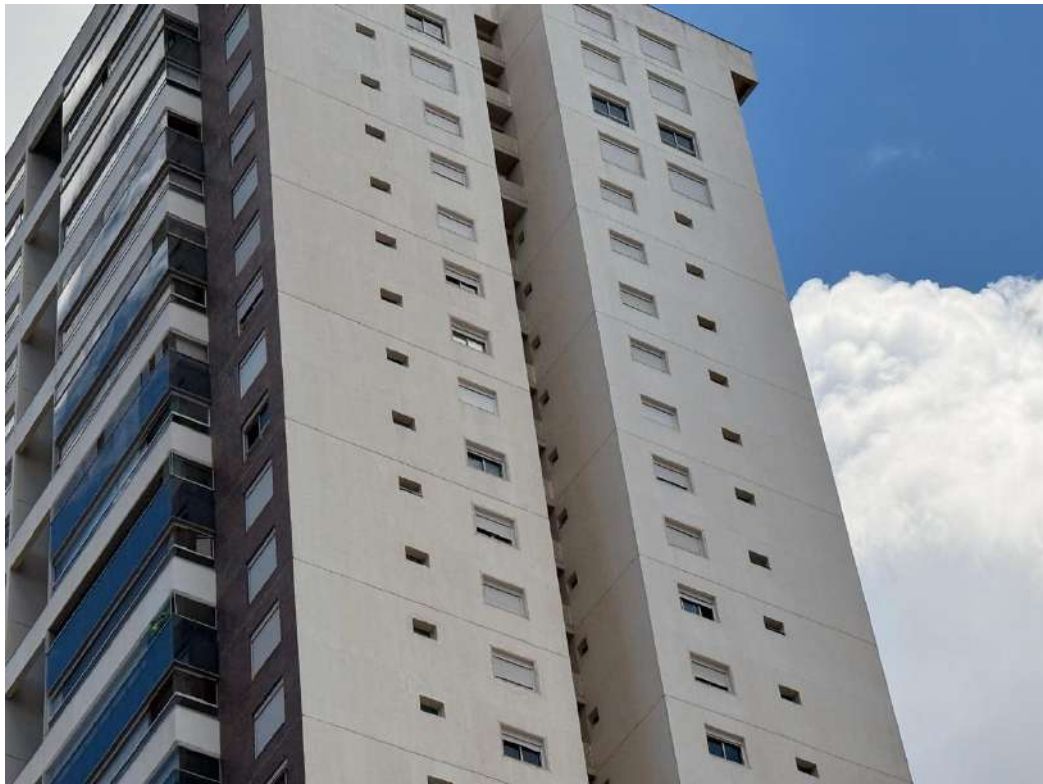
Figura M.20 – Celular: Faixa da cobertura da fachada sul do edifício Gran Bueno
