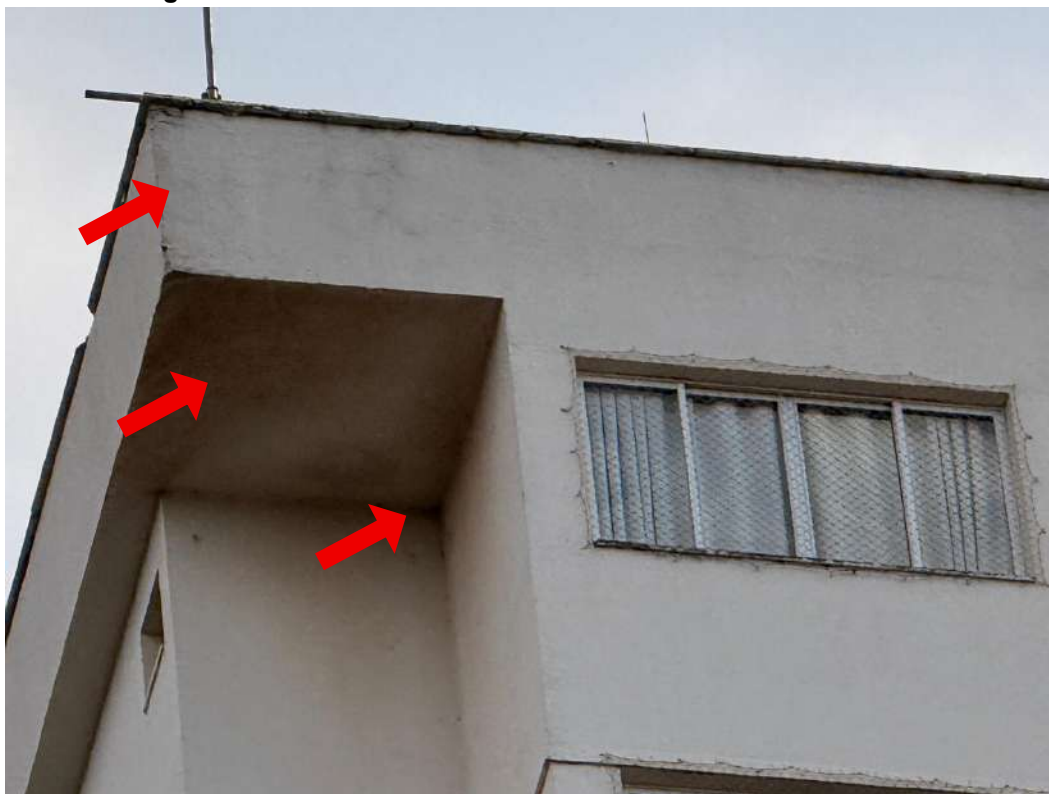
Figura J.5 – Detalhes da fachada norte do edifício Terra Mundi
