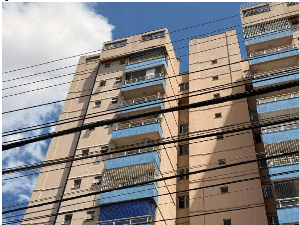
Figura F.21 – Celular: Faixa da cobertura da fachada sul do edifício Dom Fernando
