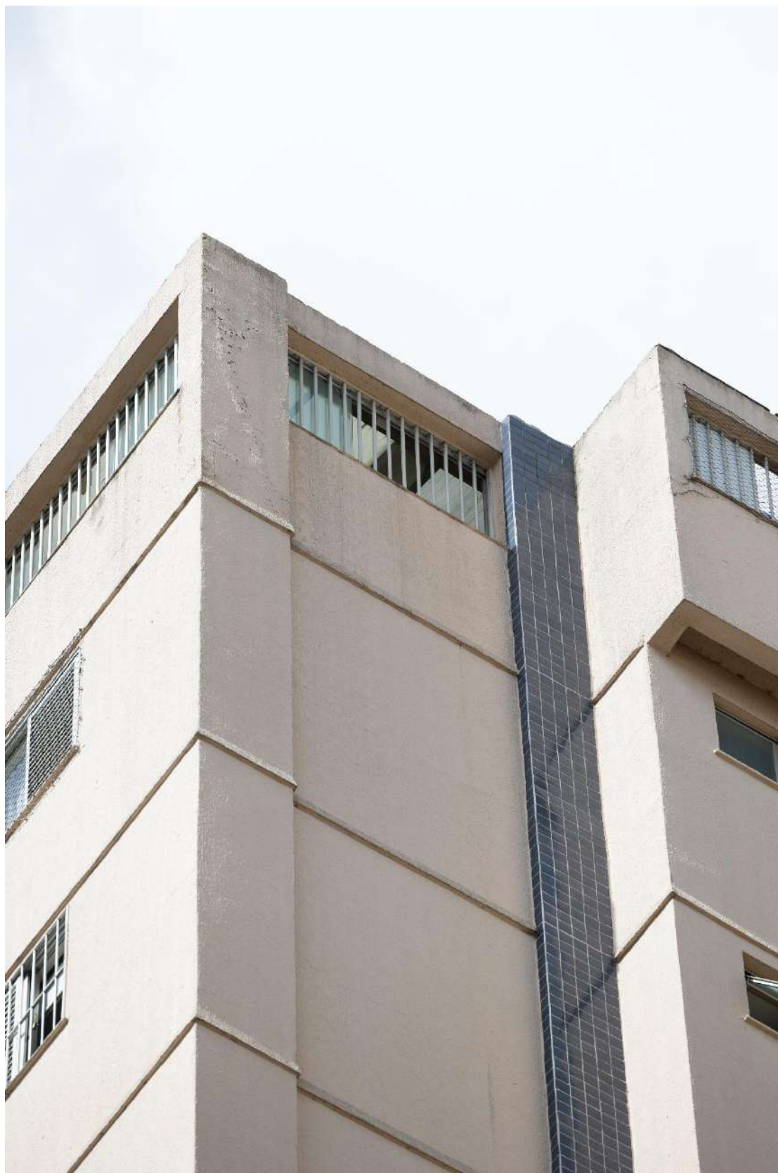
Figura F.24 – Câmera profissional: Faixa da cobertura da fachada sul do edifício Dom Fernando
