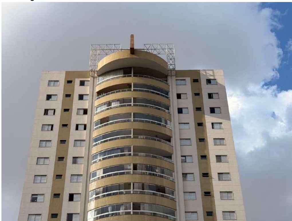
Figura C.11 – Faixa da cobertura da fachada sul do edifício Diamante
