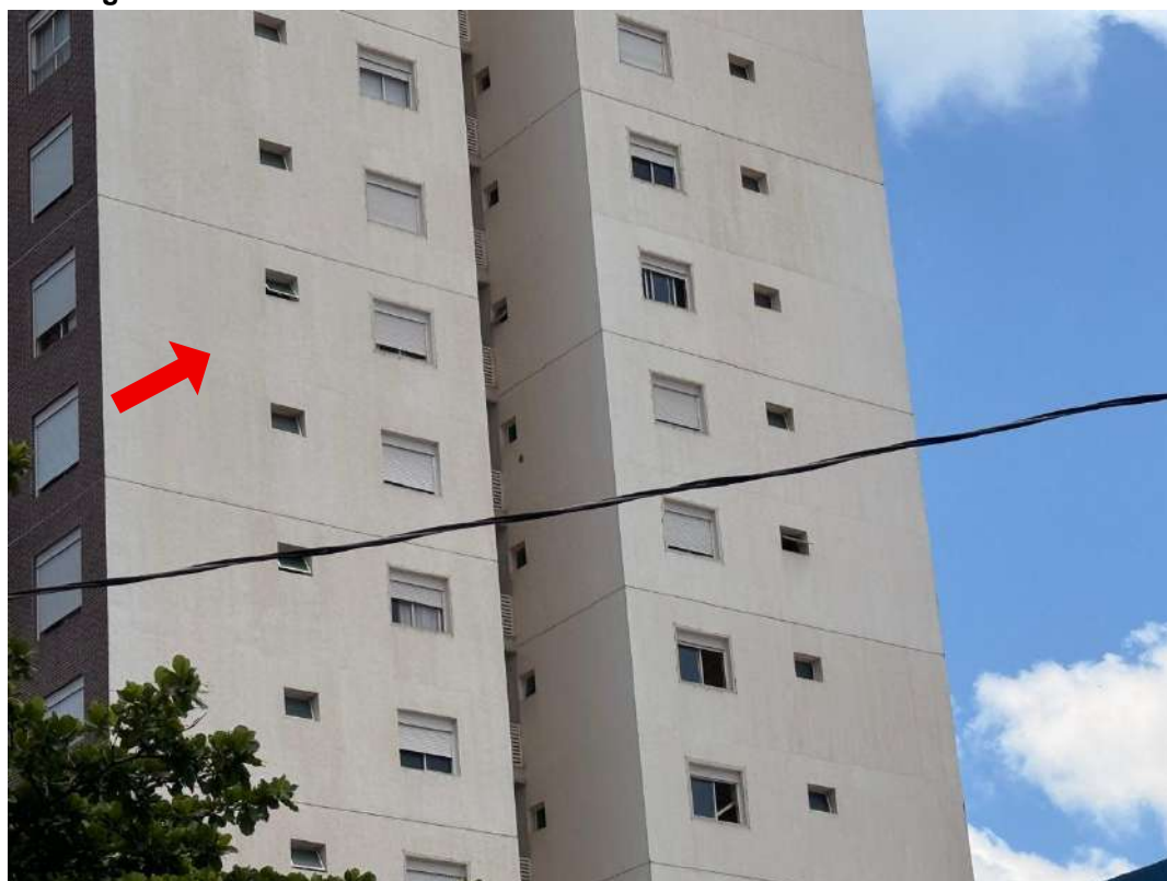
Figura M.15 – Celular: Faixa inferior da fachada sul do edifício Gran Bueno
