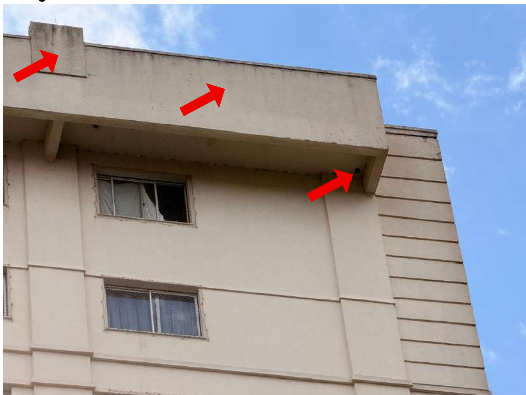
Figura I.21 – Celular: Detalhes da fachada sul do edifício Varandas do Buriti
