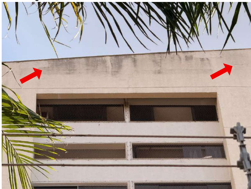
Figura E.3 – Detalhes da fachada norte do edifício Pedra do Sol
