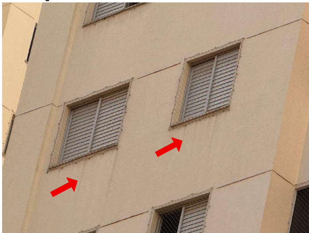
Figura E.13 – Detalhes da fachada sul do edifício Pedra do Sol
