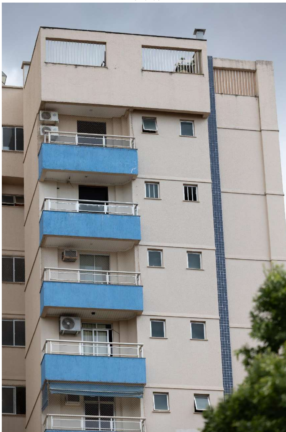
Figura F.9 – Câmera profissional: Faixa da cobertura da fachada norte do edifício Dom Fernando
