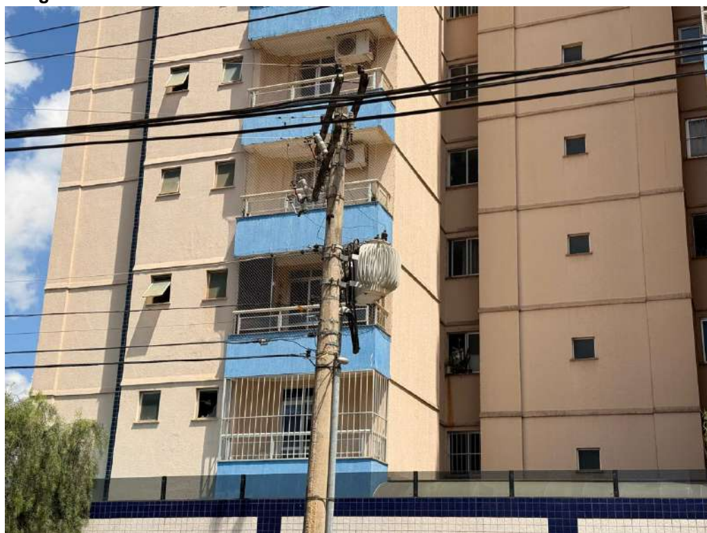
Figura F.16 – Celular: Faixa inferior da fachada sul do edifício Dom Fernando
