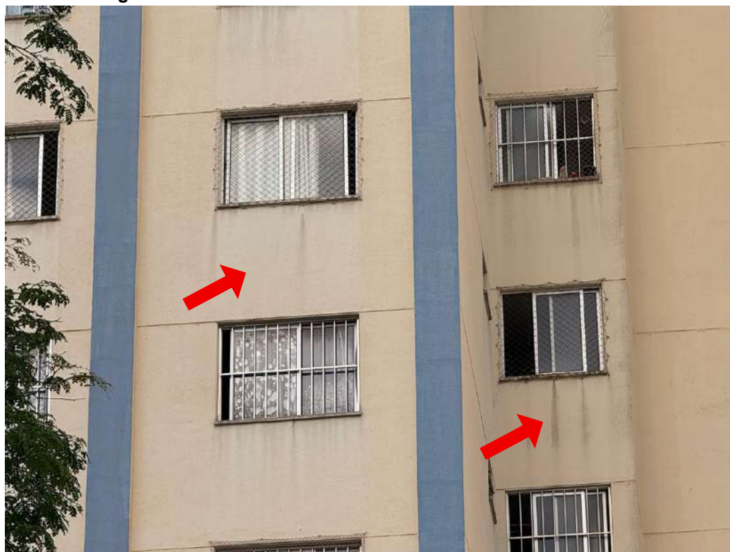
Figura L.9 – Detalhes da fachada norte do edifício Turmalinas
