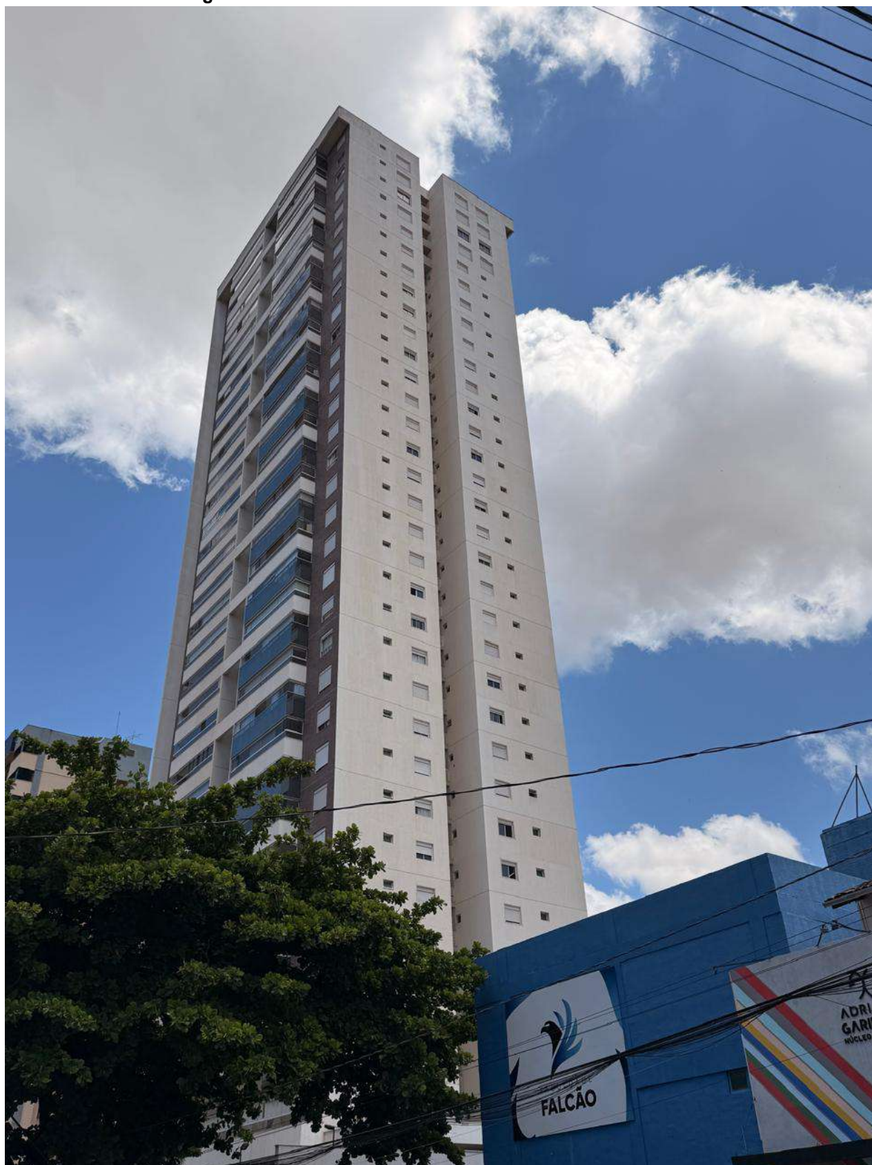
Figura M.13 – Celular: Fachada sul do edifício Gran Bueno
