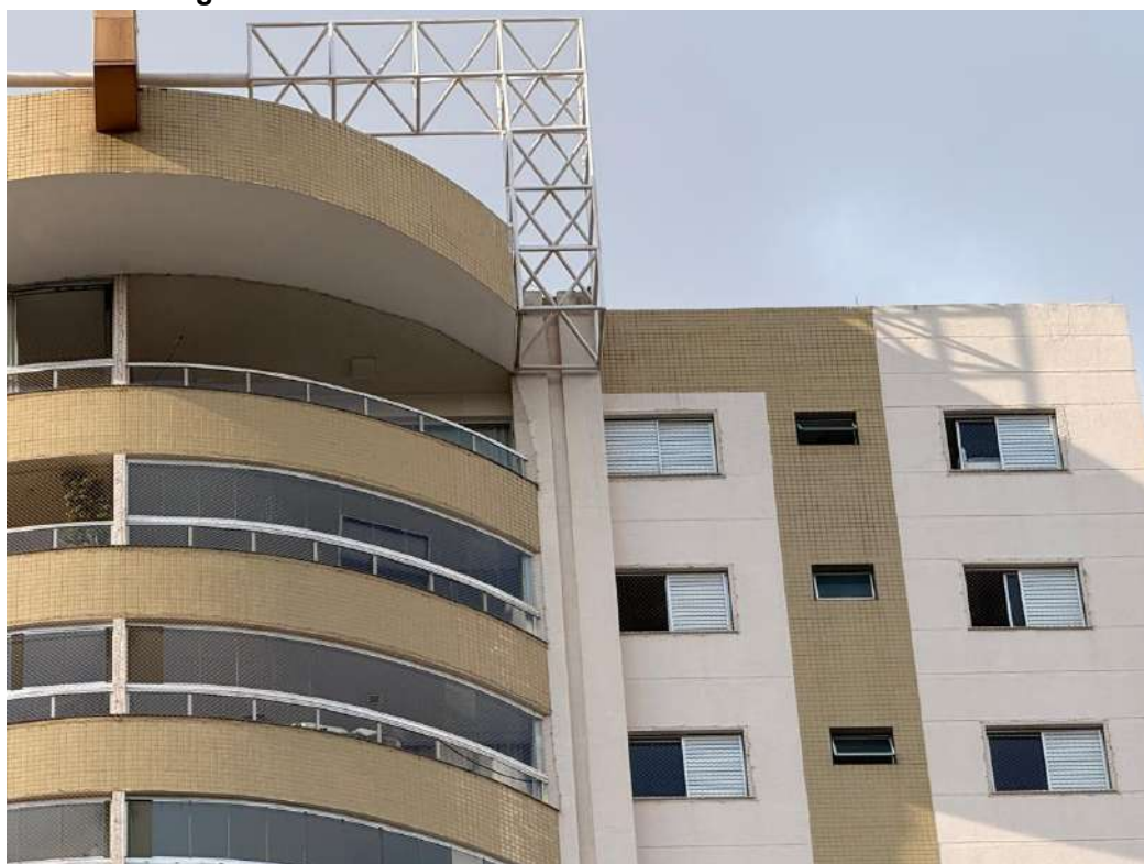
Figura C.13 – Detalhes da fachada sul do edifício Diamante
