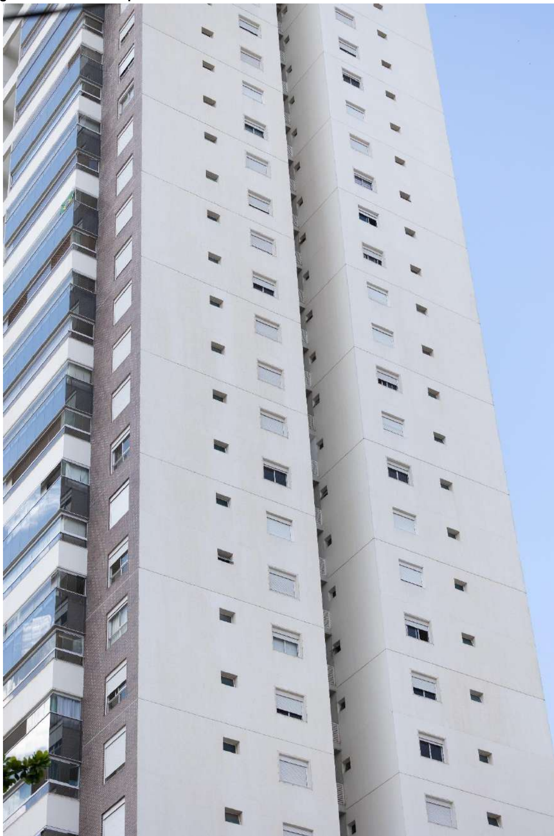
Figura M.18 – Câmera profissional: Faixa intermediária da fachada sul do edifício Gran Bueno
