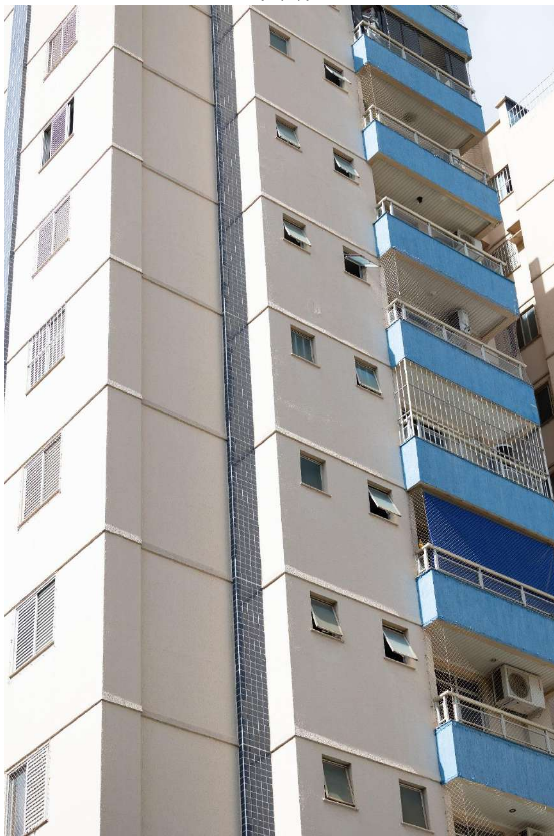
Figura F.20 – Câmera profissional: Faixa intermediária da fachada sul do edifício Dom Fernando
