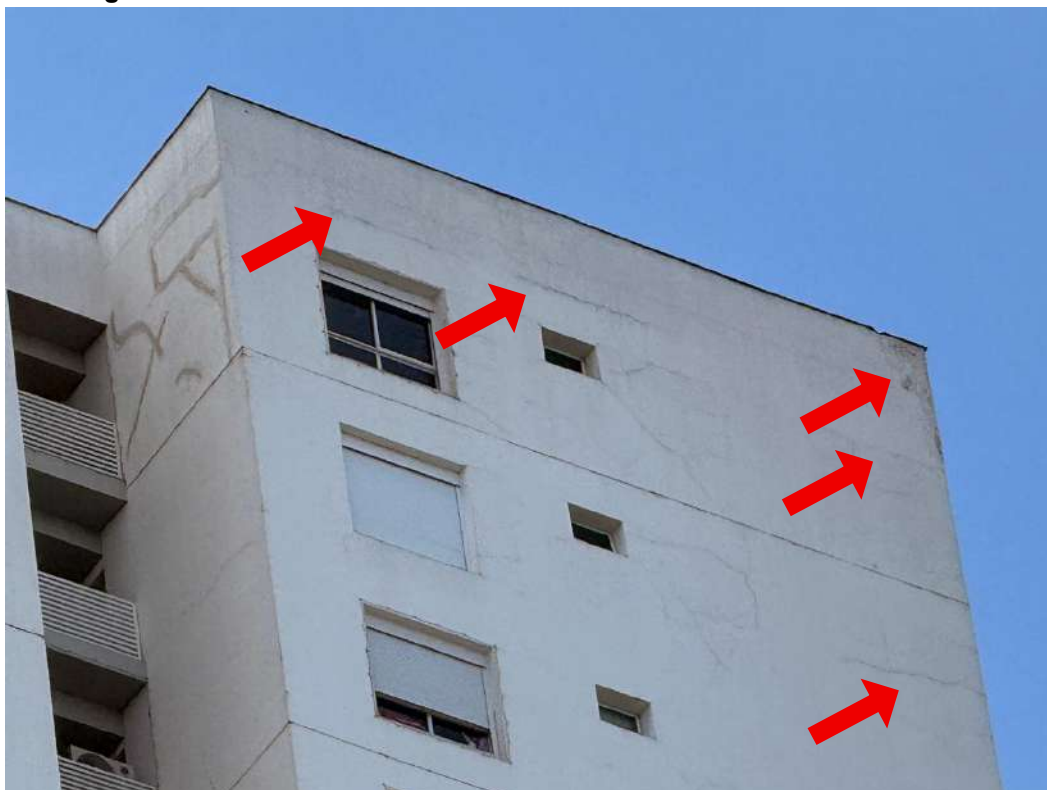
Figura M.9 – Celular: Detalhes da fachada norte do edifício Gran Bueno
