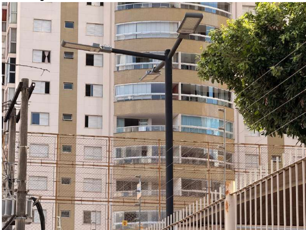
Figura C.2 – Faixa inferior da fachada norte do edifício Diamante
