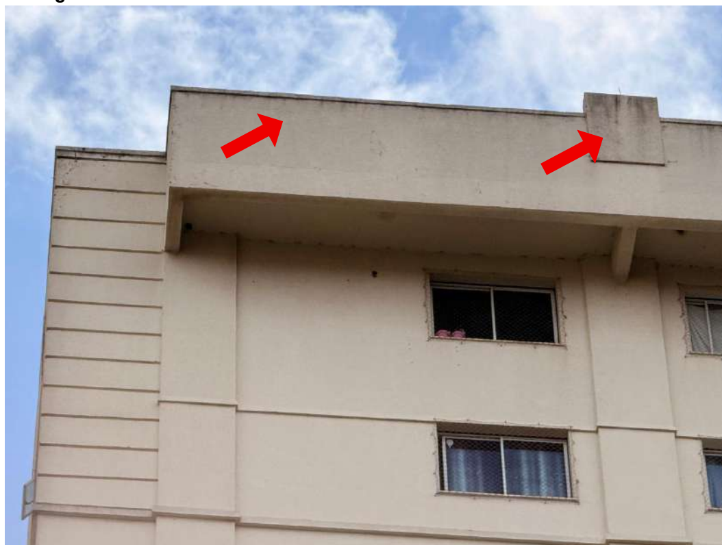
Figura I.20 – Celular: Detalhes da fachada sul do edifício Varandas do Buriti
