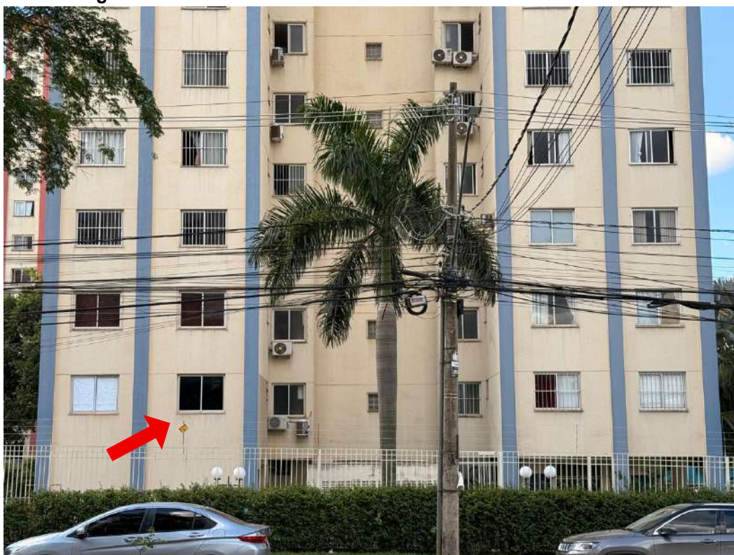
Figura L.2 – Faixa inferior da fachada norte do edifício Turmalinas
