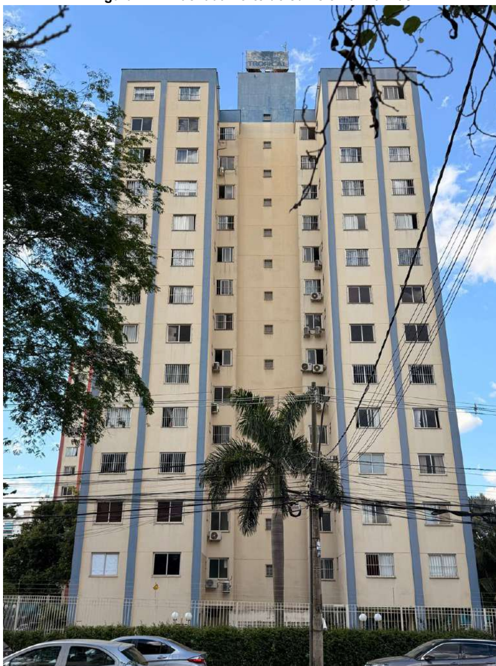
Figura L.1 – Fachada norte do edifício Turmalinas
