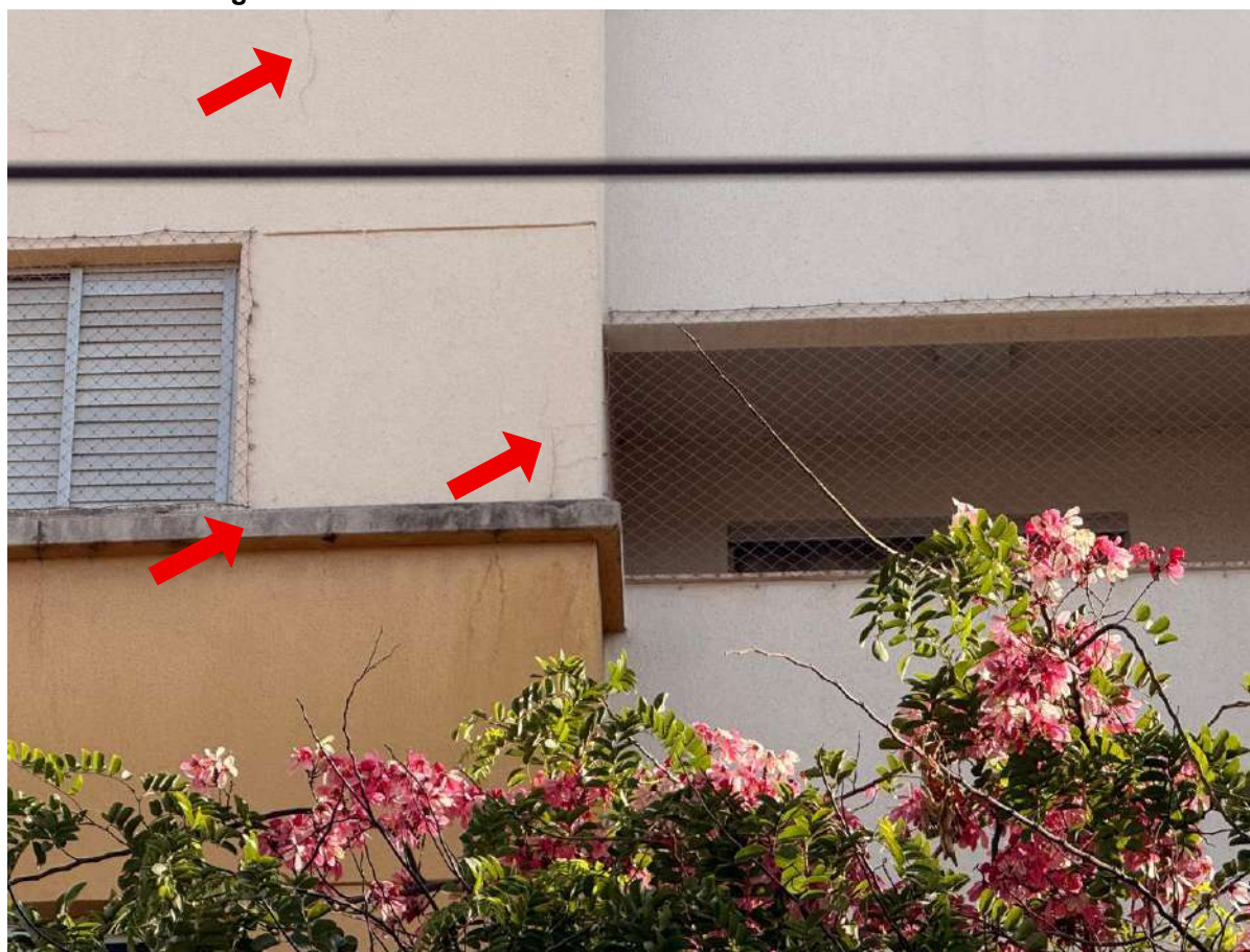
Figura E.6 – Detalhes da fachada norte do edifício Pedra do Sol
