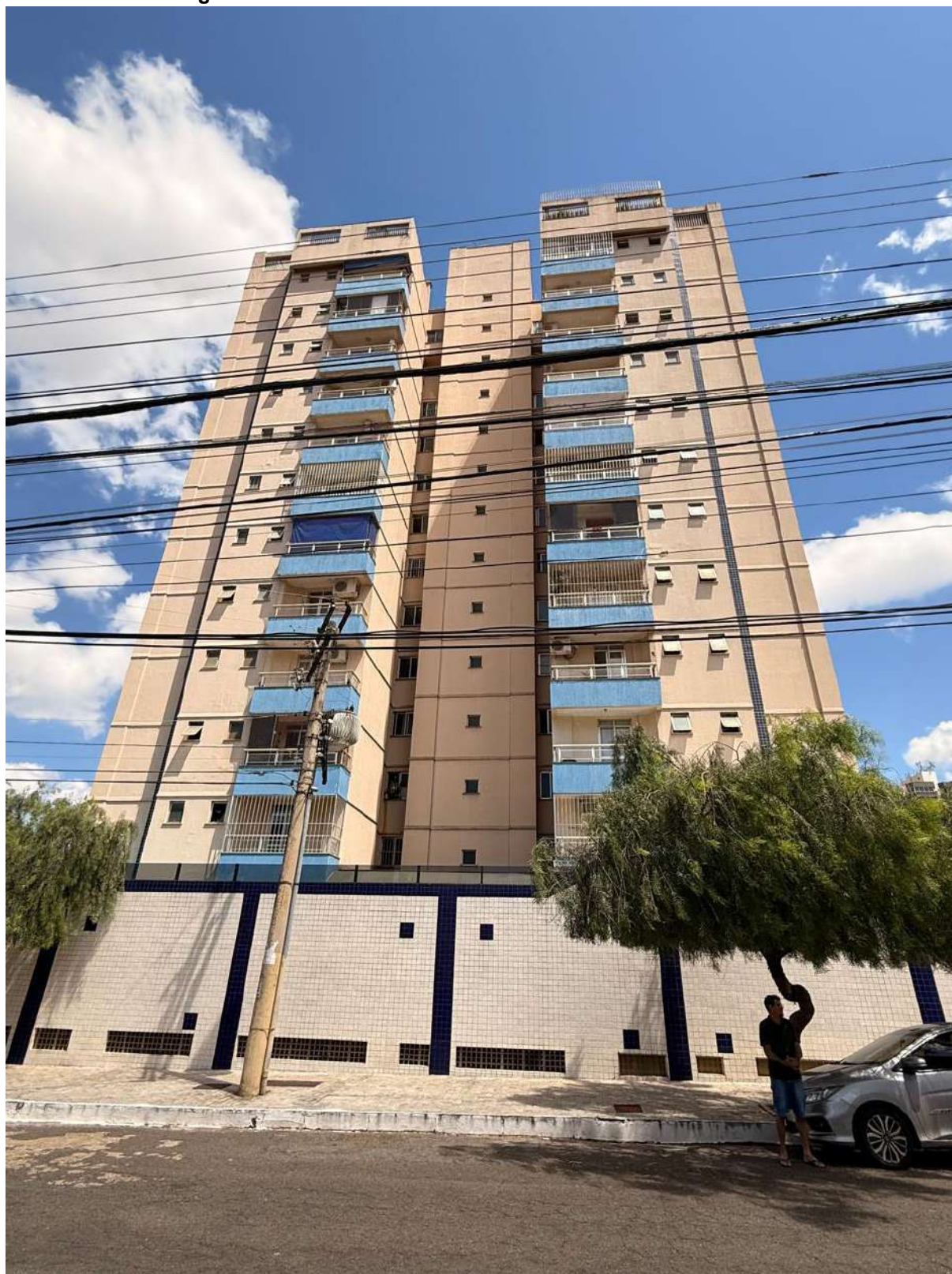
Figura F.14 – Celular: Fachada sul do edifício Dom Fernando
