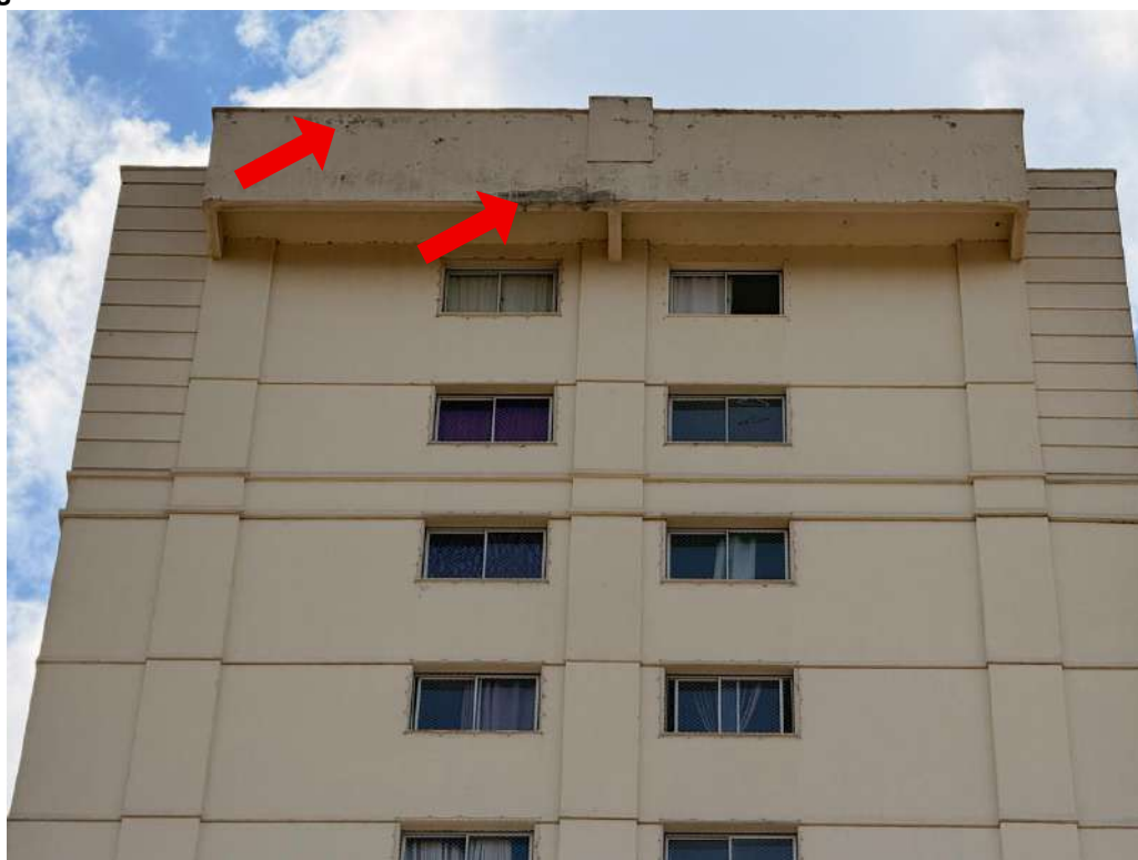
Figura I.5 – Celular: Faixa da cobertura da fachada norte do edifício Varandas do Buriti
