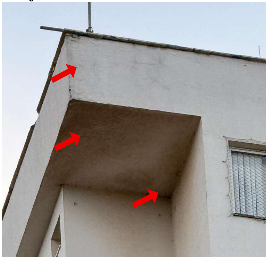
Figura J.7 – Detalhes da fachada norte do edifício Terra Mundi
