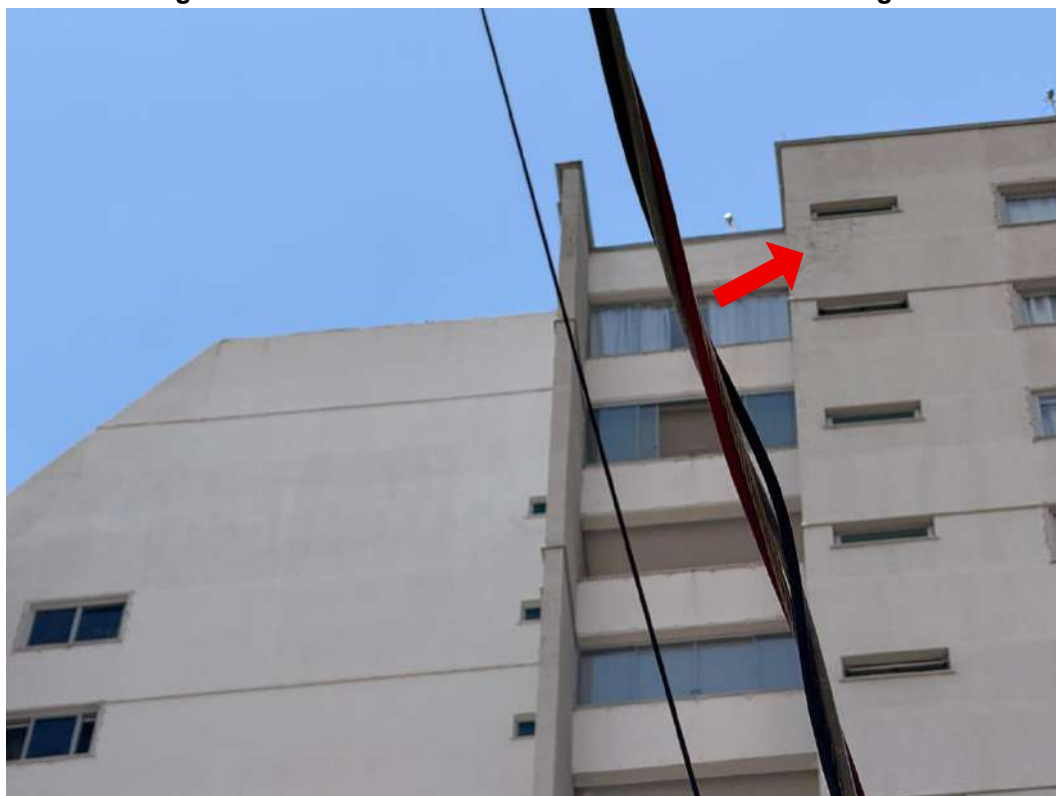
Figura H.5 – Detalhes da fachada norte do edifício Rio Negro
