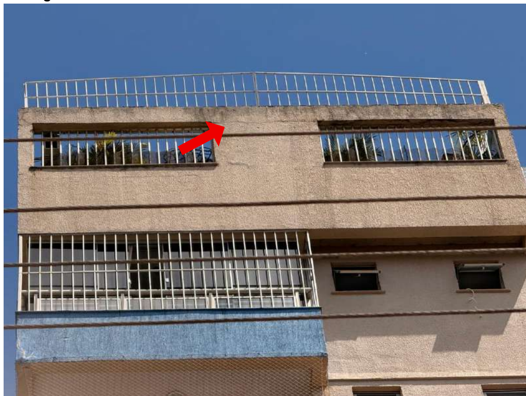
Figura F.26 – Celular: Detalhes da fachada sul do edifício Dom Fernando
