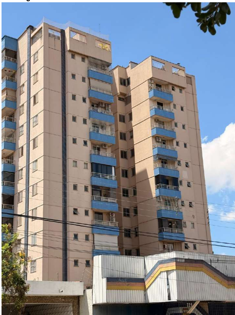
Figura F.1 – Celular: Fachada norte do edifício Dom Fernando
