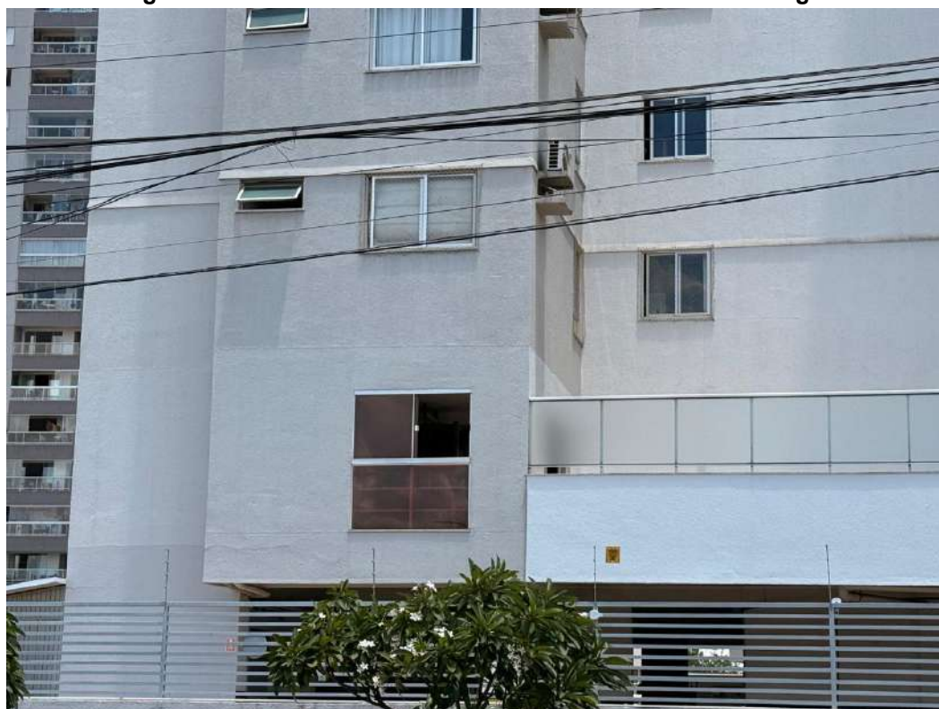
Figura H.9 – Faixa inferior da fachada sul do edifício Rio Negro
