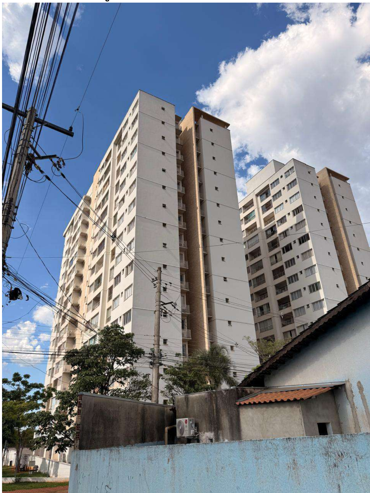
Figura J.8 – Fachada sul do edifício Terra Mundi
