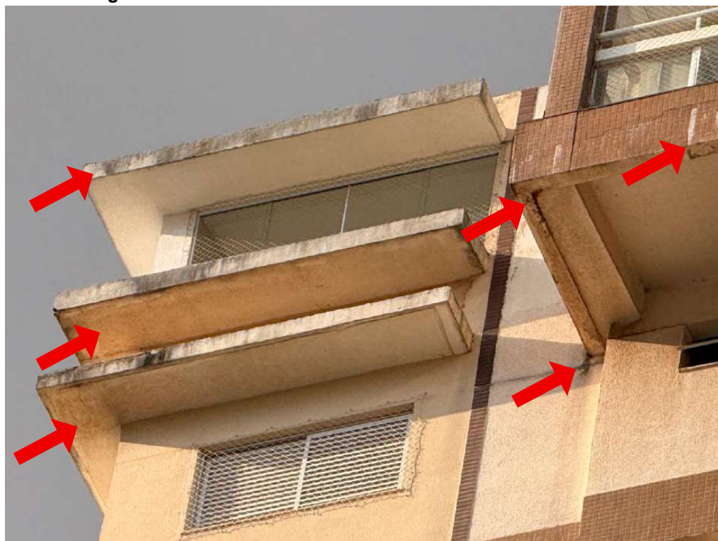
Figura D.5 – Detalhes da fachada sul do edifício Pedra do Mar
