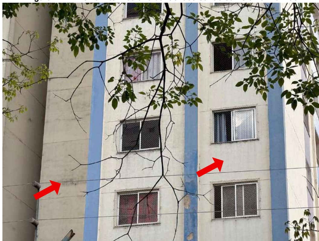
Figura L.14 – Faixa intermediária da fachada sul do edifício Turmalinas
