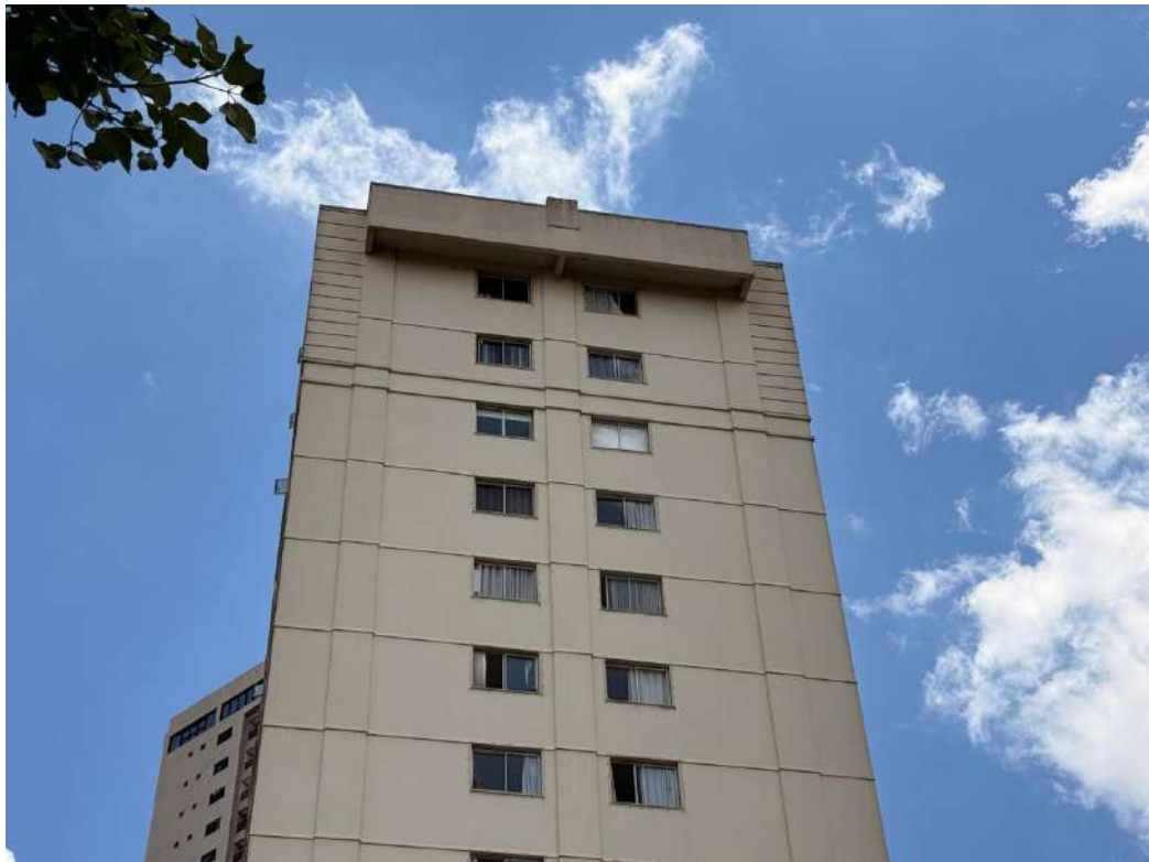
Figura I.19 – Celular: Faixa da cobertura da fachada sul do edifício Varandas do Buriti
