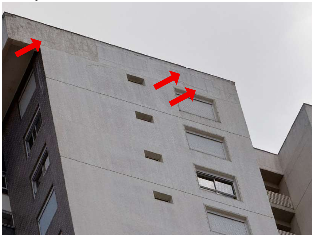
Figura M.21 – Celular: Detalhes da fachada sul do edifício Gran Bueno
