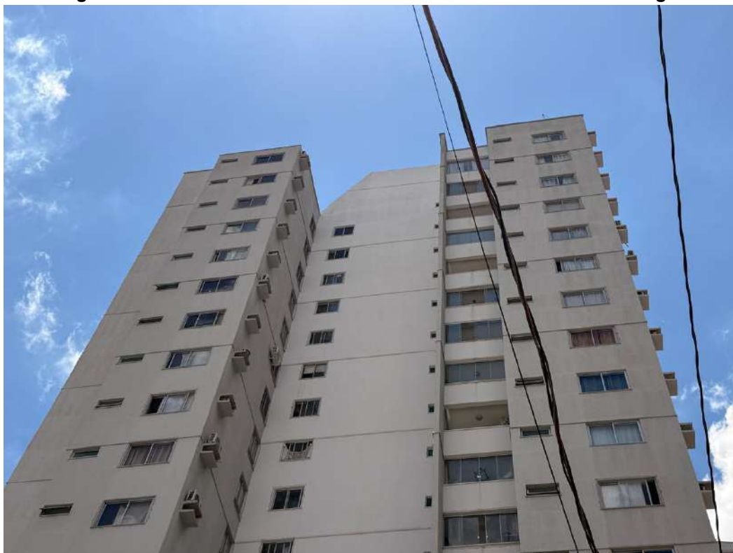
Figura H.4 – Faixa da cobertura da fachada norte do edifício Rio Negro
