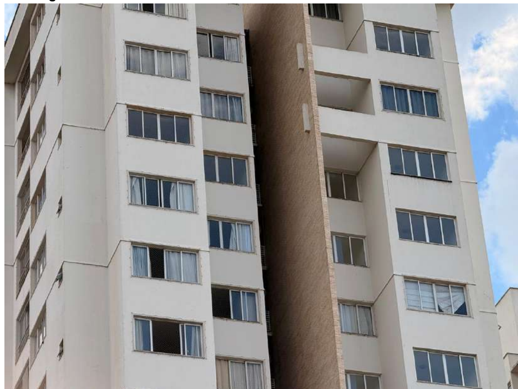
Figura J.3 – Faixa intermediária da fachada norte do edifício Terra Mundi
