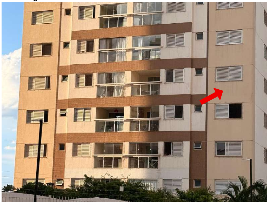
Figura D.2 – Faixa inferior da fachada sul do edifício Pedra do Mar
