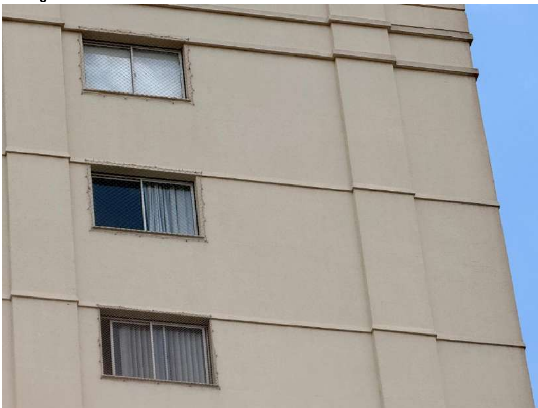
Figura I.22 – Celular: Detalhes da fachada sul do edifício Varandas do Buriti
