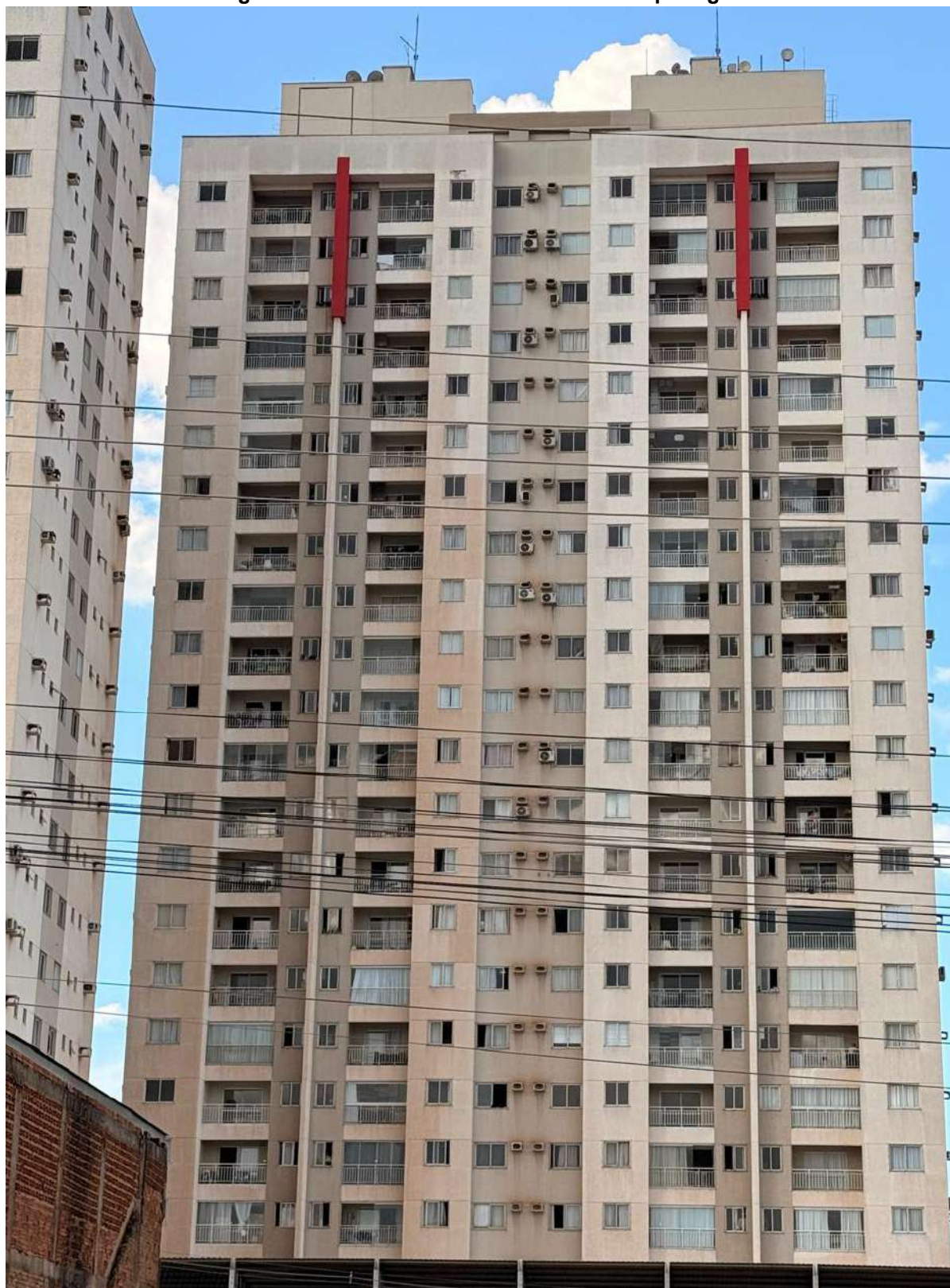
Figura B.8 – Fachada sul do edifício Livre Ipiranga
