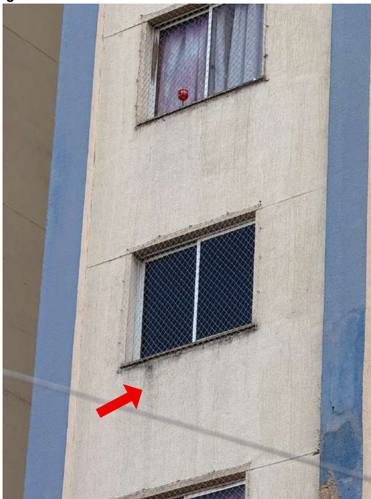
Figura L.18 – Detalhes da fachada sul do edifício Turmalinas
