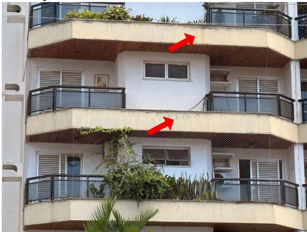
Figura G.13 – Detalhes da fachada sul do edifício Golden Garden
