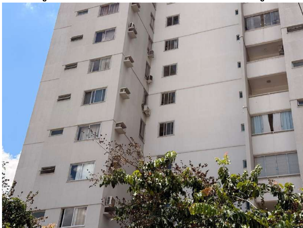
Figura H.2 – Faixa inferior da fachada norte do edifício Rio Negro
