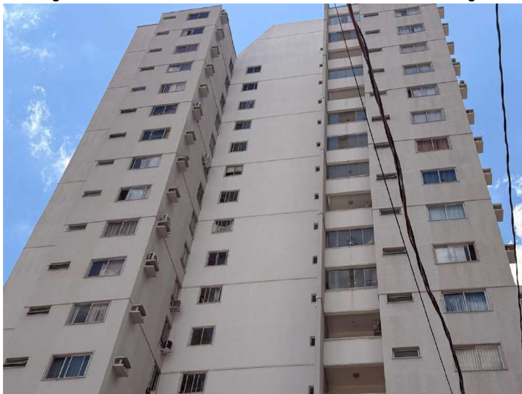
Figura H.3 – Faixa intermediária da fachada norte do edifício Rio Negro
