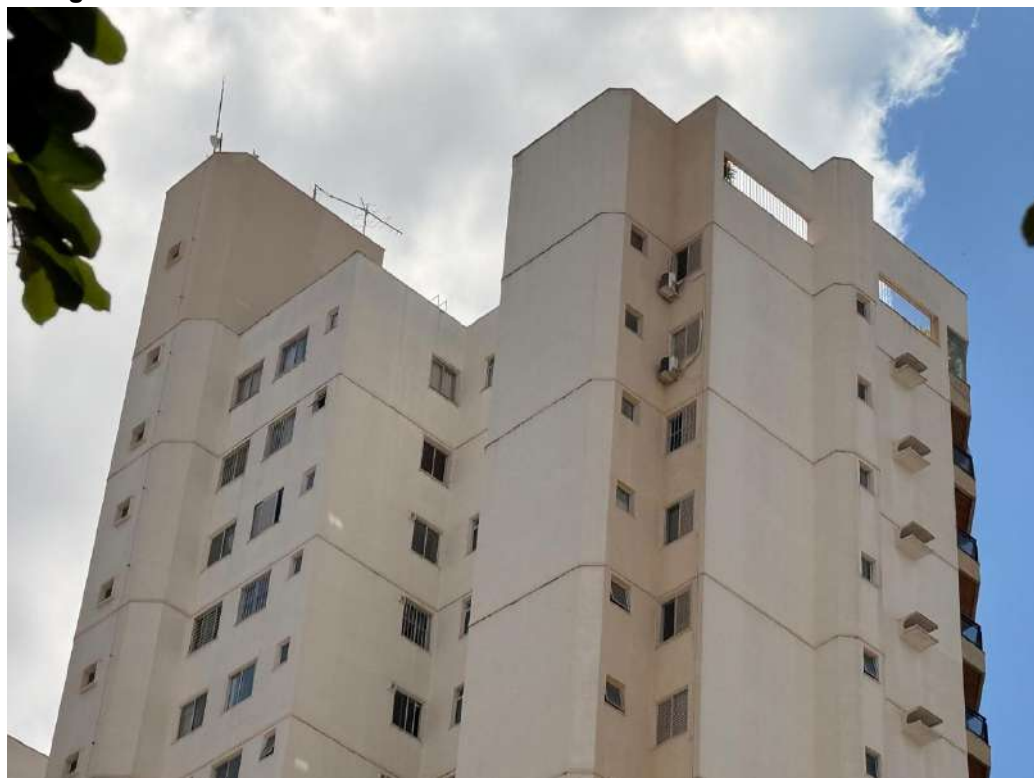
Figura G.4 – Faixa da cobertura da fachada norte do edifício Golden Garden
