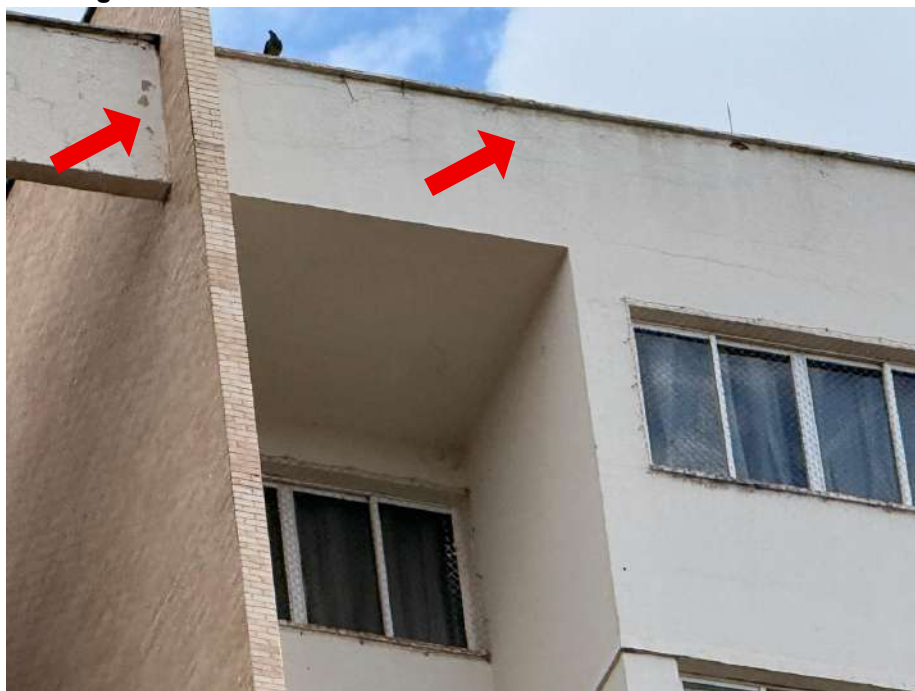
Figura J.6 – Detalhes da fachada norte do edifício Terra Mundi
