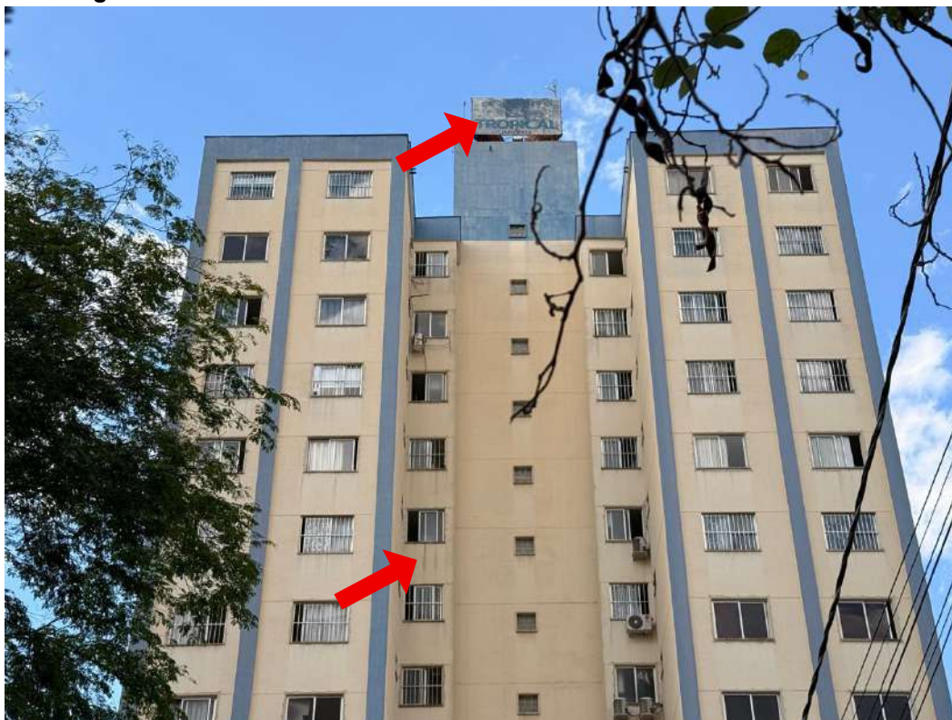
Figura L.4 – Faixa da cobertura da fachada norte do edifício Turmalinas
