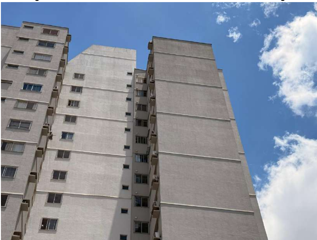
Figura H.14 – Faixa da cobertura da fachada sul do edifício Rio Negro
