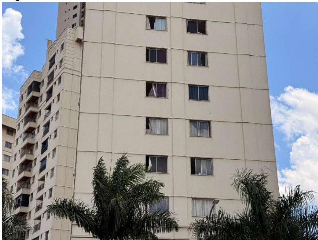
Figura I.14 – Celular: Faixa inferior da fachada sul do edifício Varandas do Buriti
