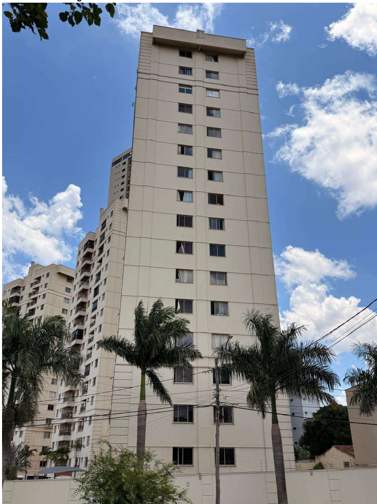
Figura I.12 – Celular: Fachada sul do edifício Varandas do Buriti
