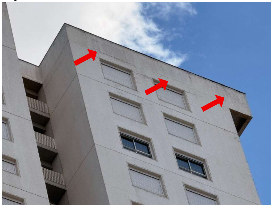
Figura M.22 – Celular: Faixa da cobertura da fachada sul do edifício Gran Bueno
