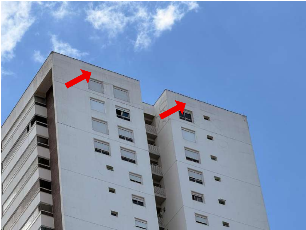
Figura M.7 – Celular: Faixa da cobertura da fachada norte do edifício Gran Bueno
