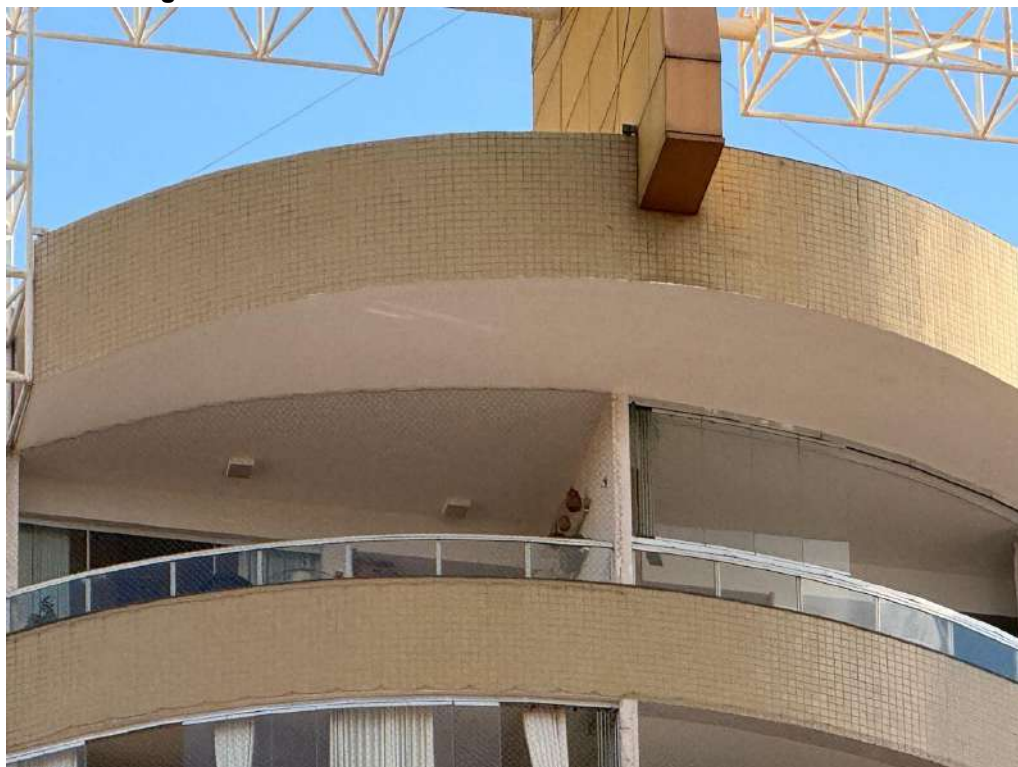
Figura C.6 – Detalhes da fachada norte do edifício Diamante
