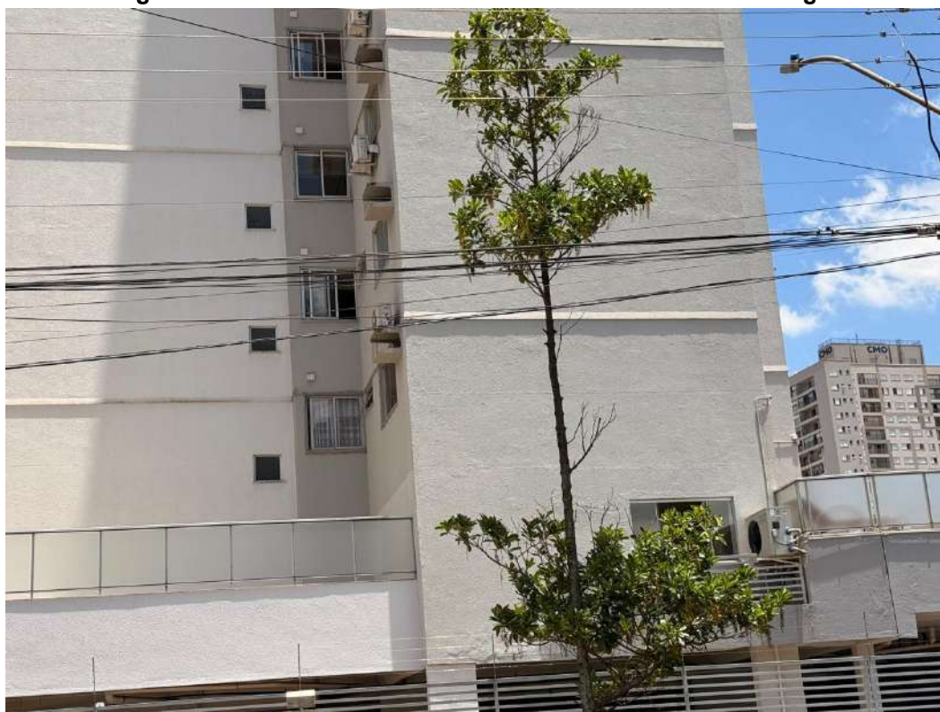
Figura H.10 – Faixa inferior da fachada sul do edifício Rio Negro
