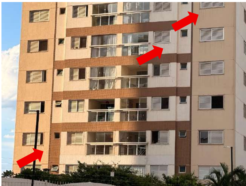
Figura 11 – Faixa inferior do edifício Pedra do Mar
