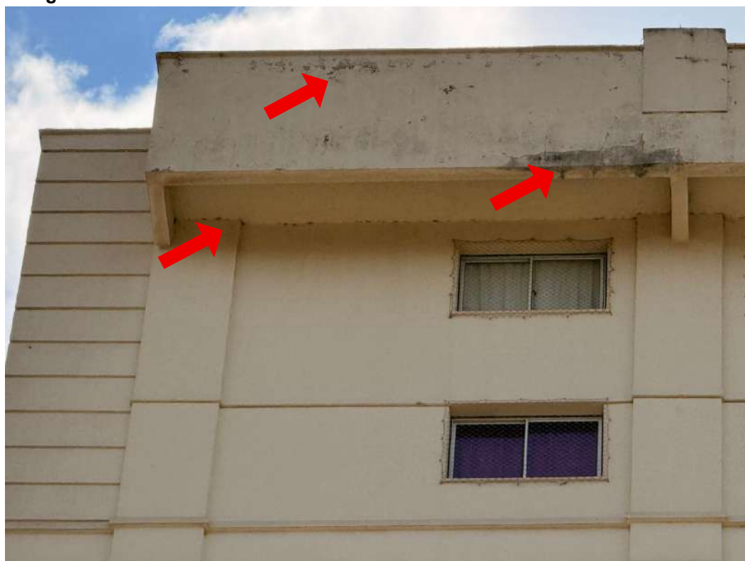
Figura I.10 – Celular: Detalhes da fachada norte do edifício Varandas do Buriti
