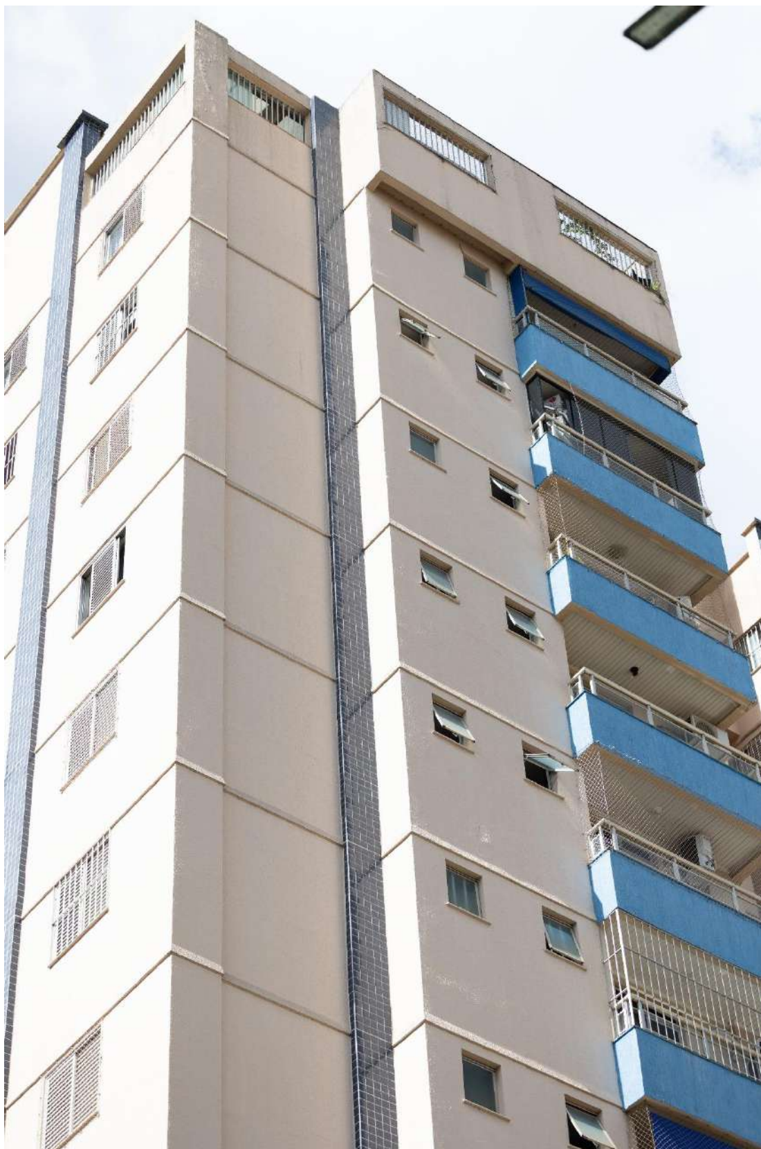
Figura F.23 – Câmera profissional: Faixa da cobertura da fachada sul do edifício Dom Fernando
