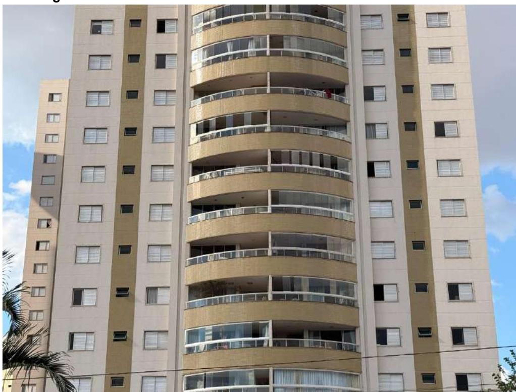
Figura C.10 – Faixa intermediária da fachada sul do edifício Diamante
