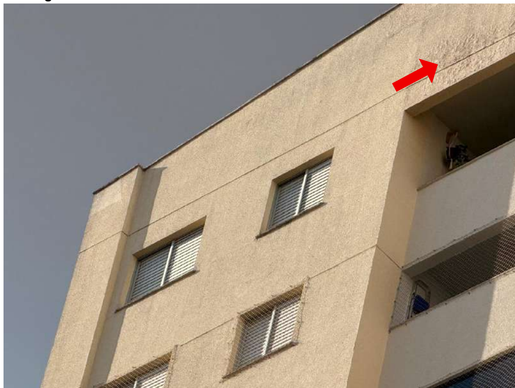
Figura E.12 – Faixa da cobertura da fachada sul do edifício Pedra do Sol
