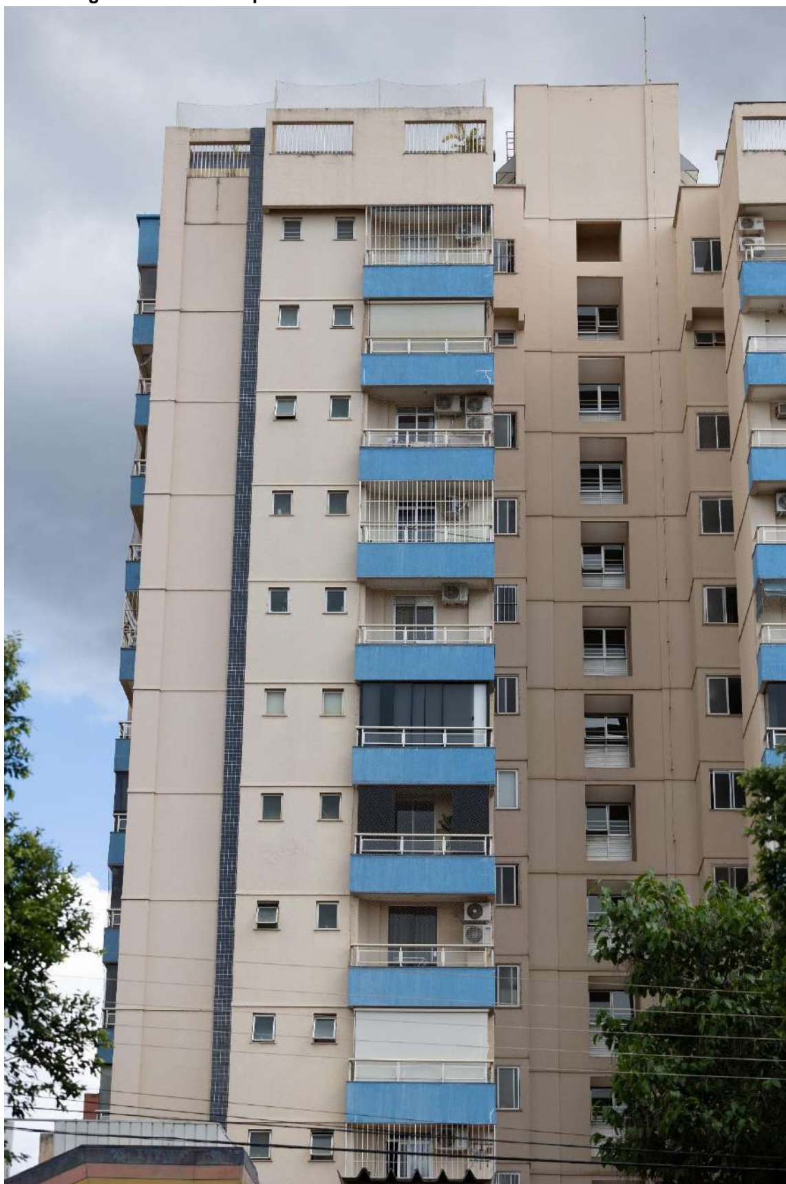
Figura F.2 – Câmera profissional: Fachada norte do edifício Dom Fernando
