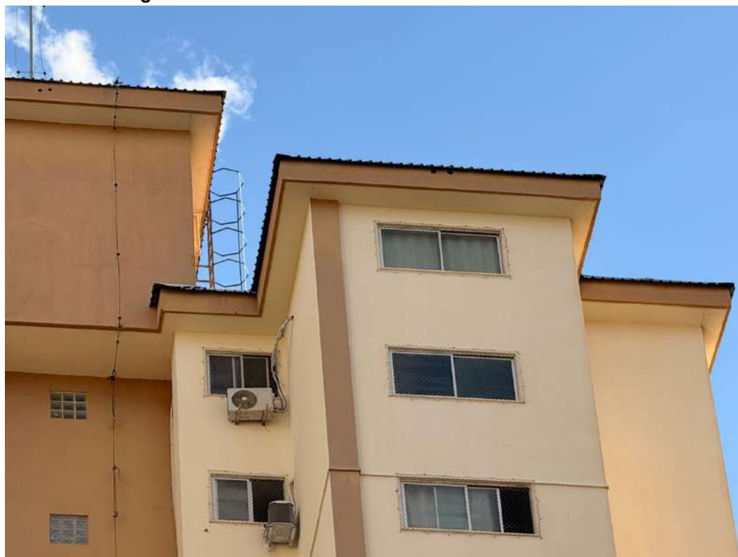
Figura K.7 – Detalhes da fachada norte do edifício Pérola
