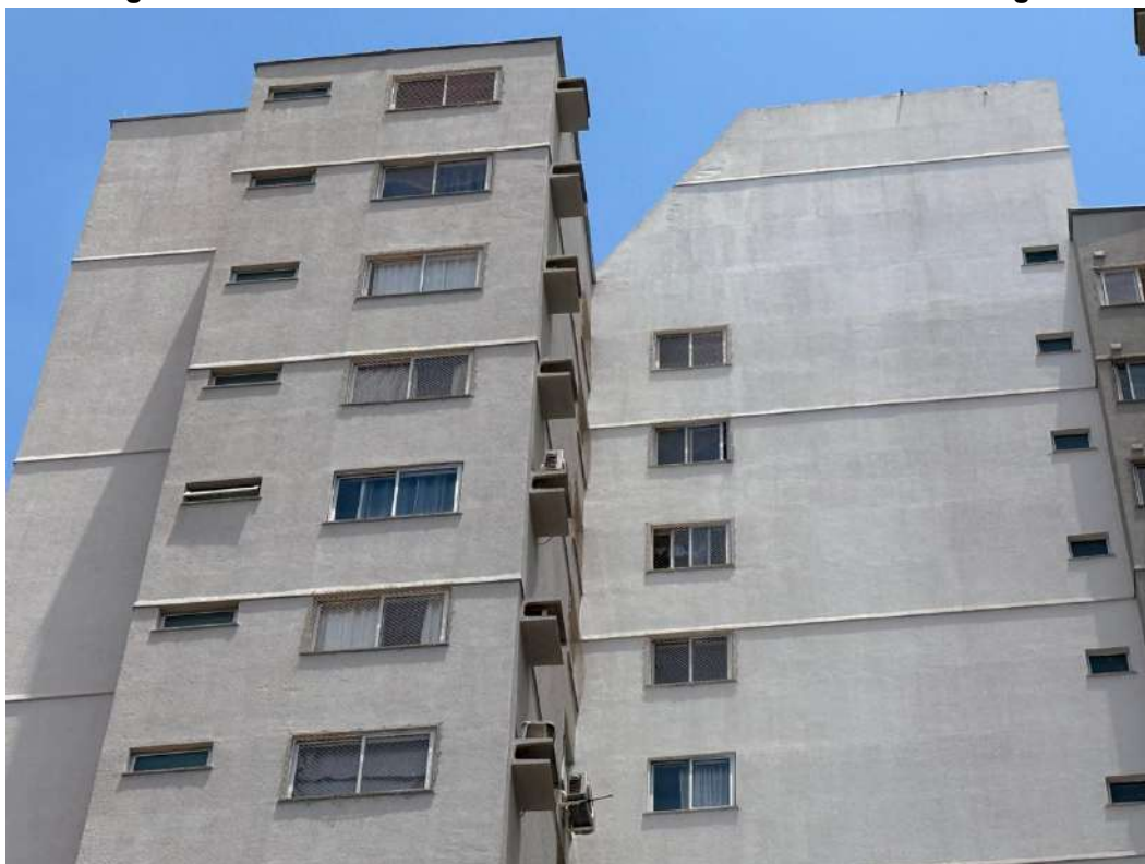
Figura H.13 – Faixa da cobertura da fachada sul do edifício Rio Negro
