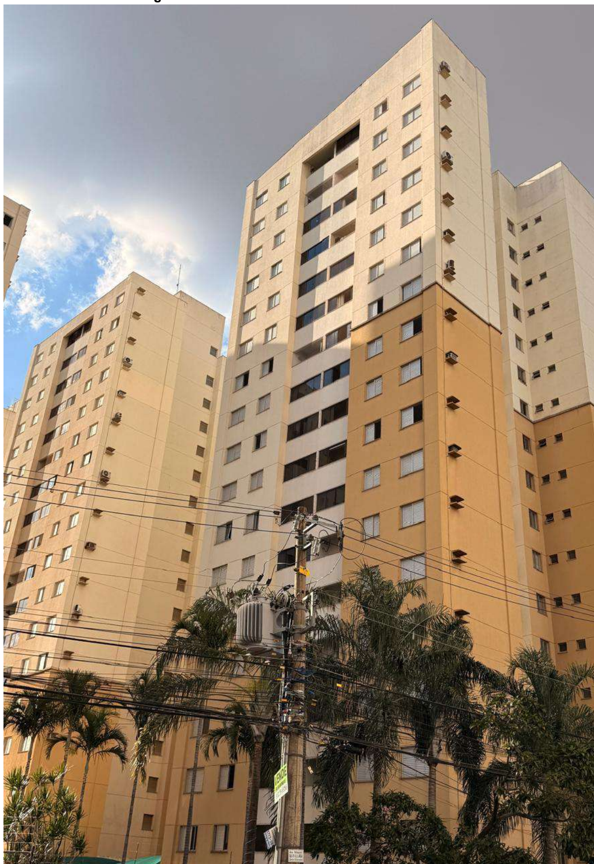
Figura E.7 – Fachada sul do edifício Pedra do Sol
