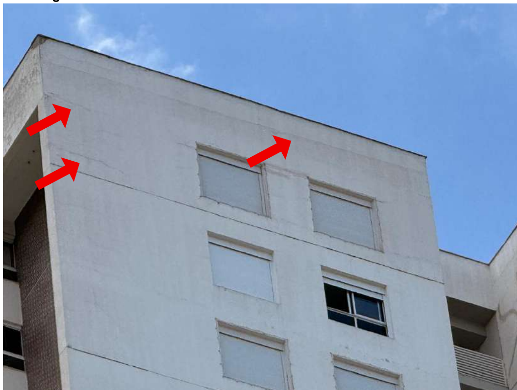
Figura M.8 – Celular: Detalhes da fachada norte do edifício Gran Bueno
