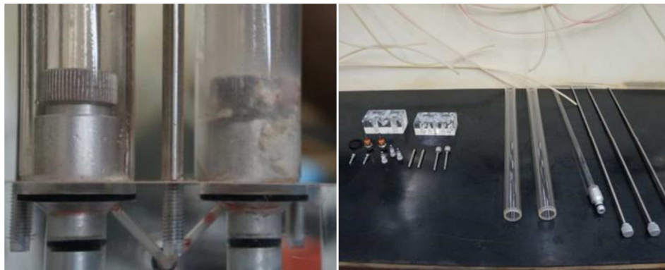
Figura 3.11 – Manutenção dos variômetros: detalhe das condições dos componentes anteriormente à manutenção; peças limpas aguardando montagem.
