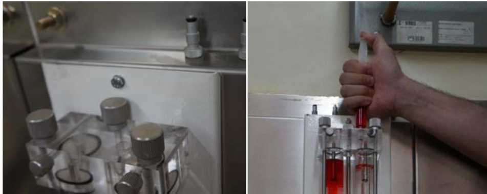
Figura 3.12 – Manutenção dos variômetros: Vista superior do variômetro e do orifício usado para preenchimento com vaselina; preenchimento da bureta aferidora dos variômetros.
