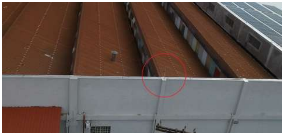
Figura 25 - Vista Superior do Galpão.
