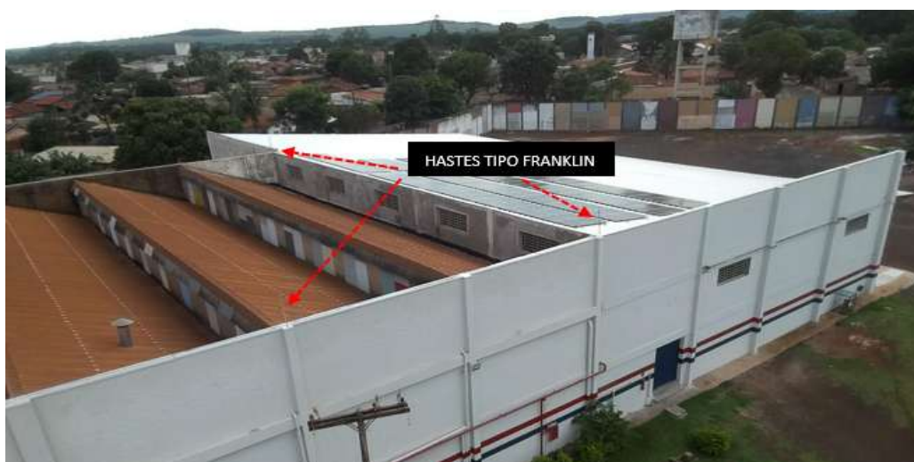
Figura 31 - SPDA na vista superior do galpão industrial.
