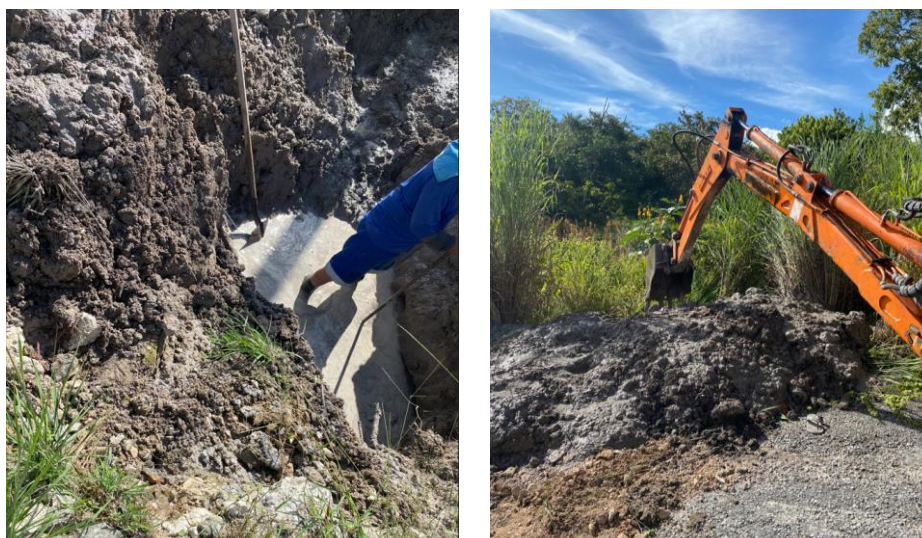
Figuras 31 e 32: Obra da Saneago na área da nascente.
