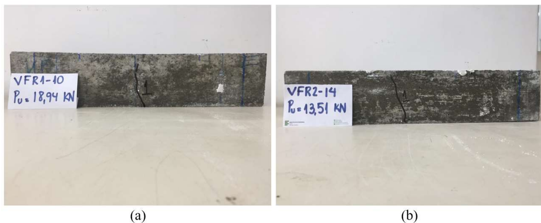
Figura 4.9 – Fissuração das vigas: (a) VFR1-10; (b) VFR2-14
