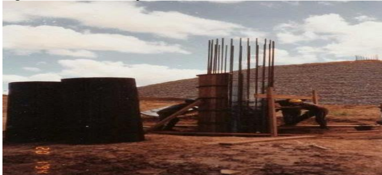
Figura 2.2 - Colocação da fôrma e armadura
