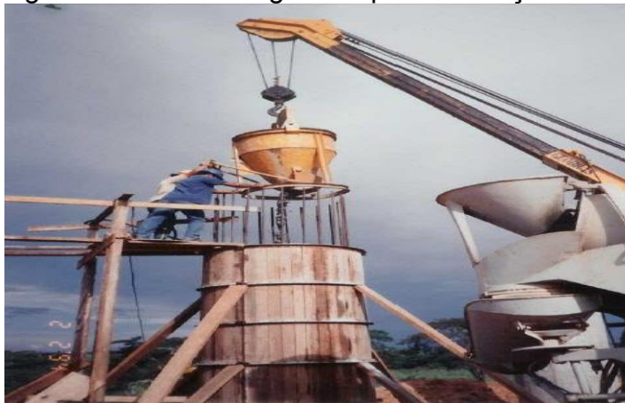
Figura 2.3 - Concretagem da primeira seção da camisa de concreto
