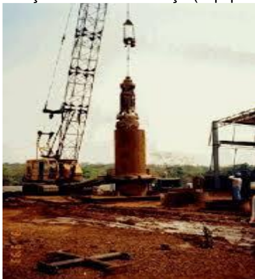
Figura 1.1 - Cravação da camisa de aço (Equipamento Benotto)
