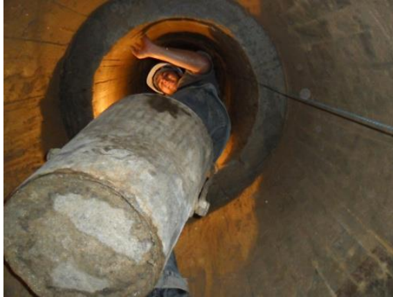
Figura 3.1 - Descida do operário até a base do tubulão
