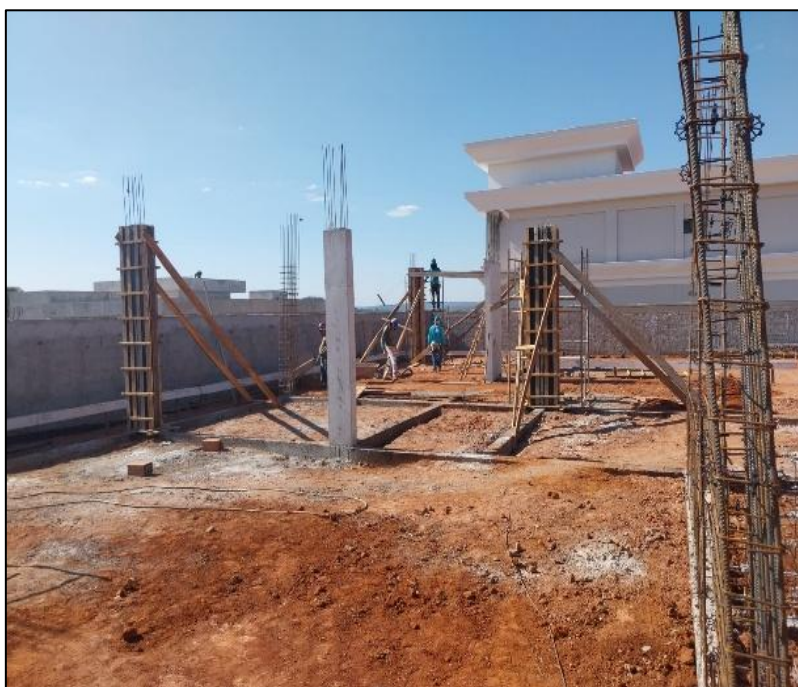
Figura 19 - Etapa de serviço: estrutura
