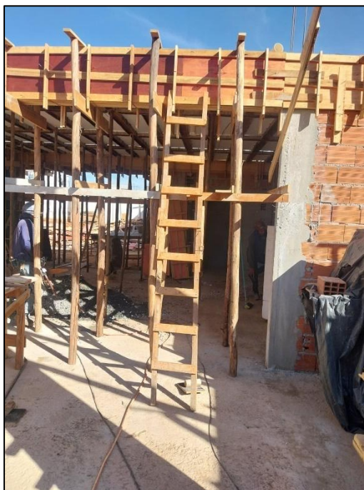
Figura 14 - Segunda escada obra 1
