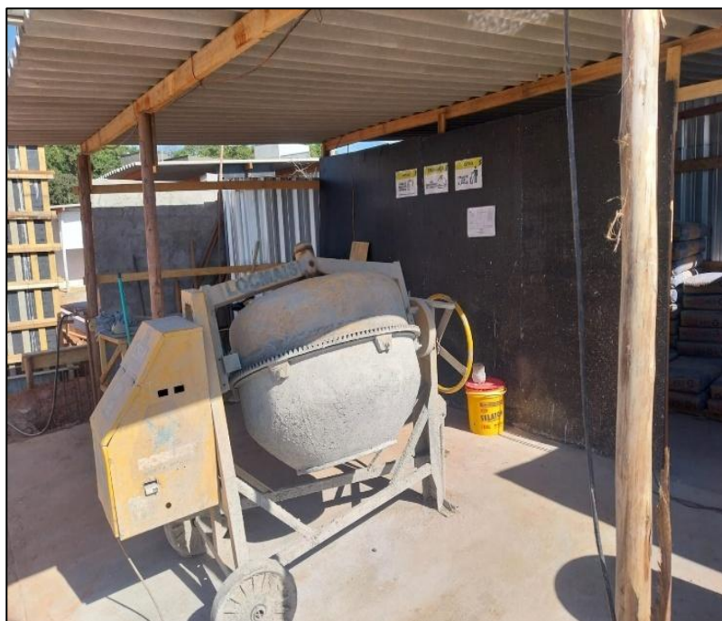
Figura 24 - Sinalização e segurança
