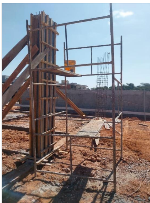
Figura 23 - Andaime tubular obra 2
