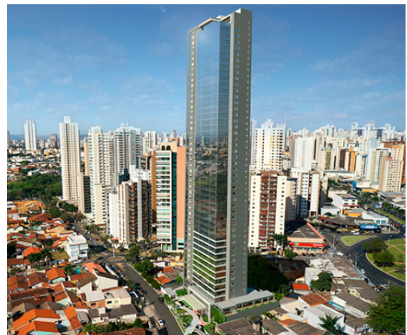
Figura 1.2 – Edifício Kingdom Park Residence
