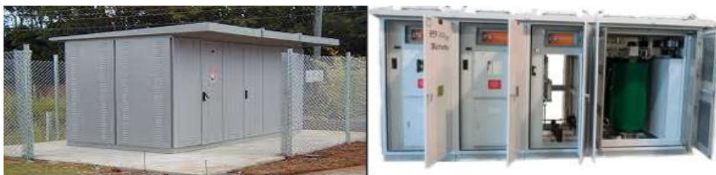
Figura 7: Subestação Blindada – Cabine ou Cubículo (GUIMARÃES, 2023).
