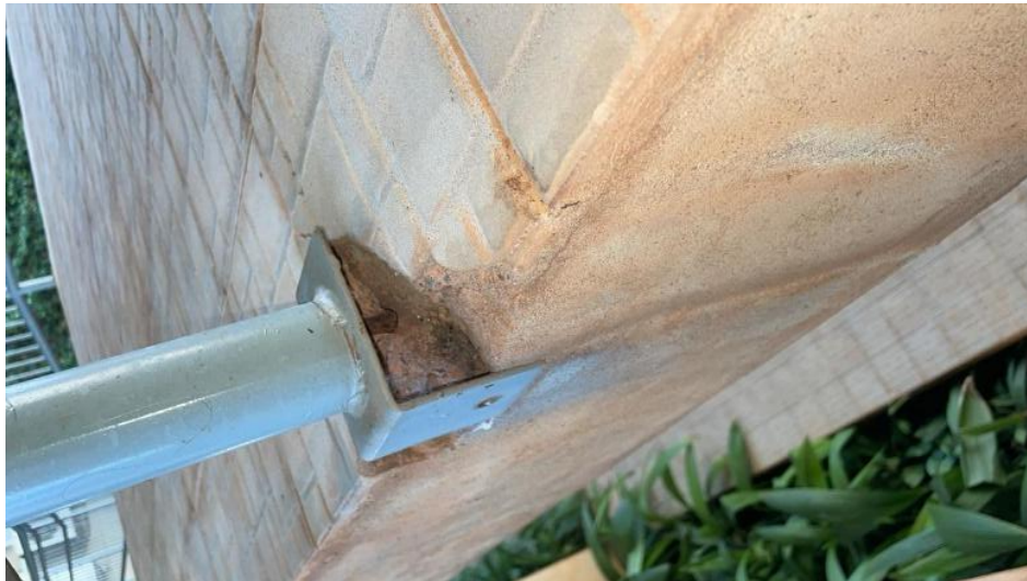
Figura 15 – Fixação de corrimão exposto entre os Blocos 400 e 500
