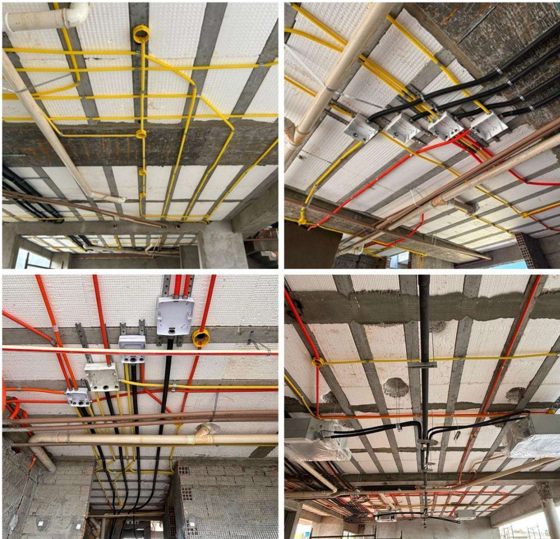
Figura 4. 16 – Infraestrutura elétrica térreo e superior
