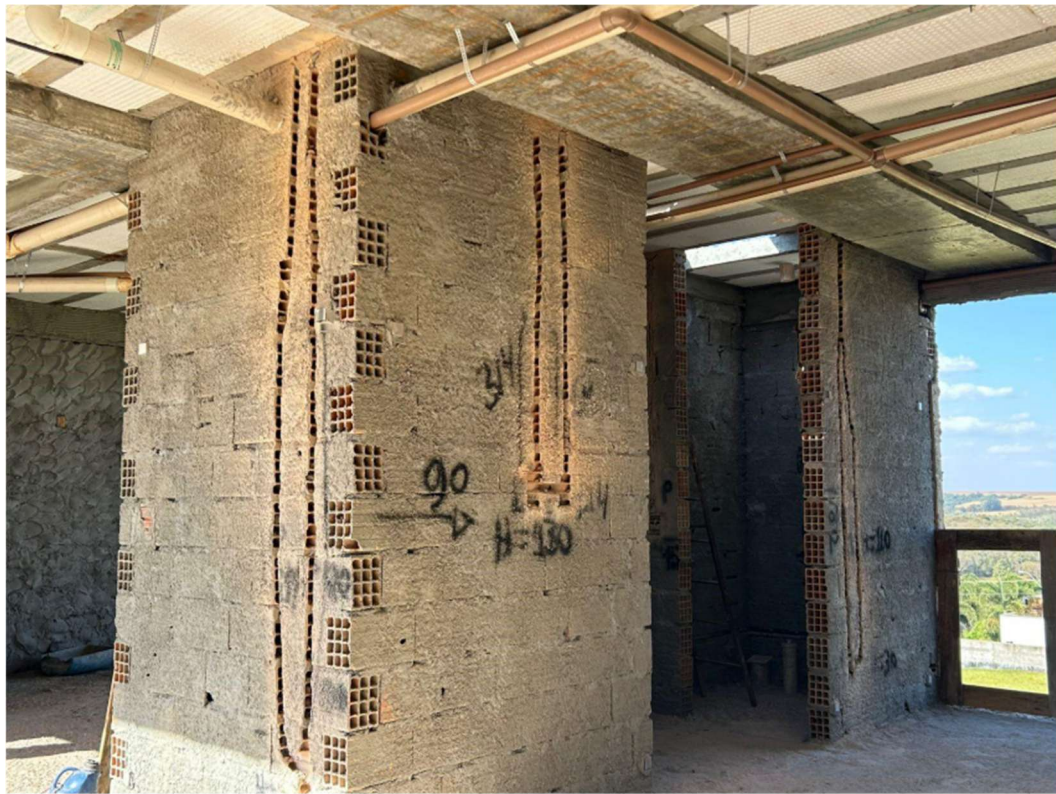
Figura 4. 17 – Demarcação dos pontos elétricos
