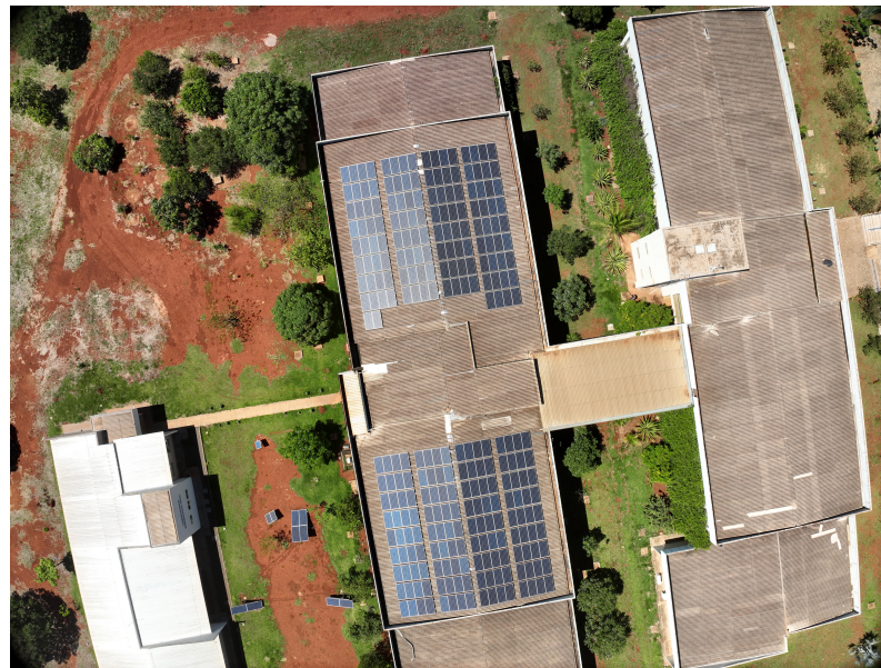
Figura 12 – Inspeção aérea do arranjo fotovoltaico
