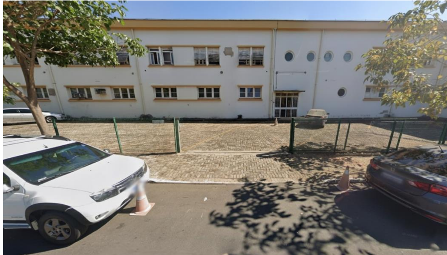
Figura 5.9: Saída Lateral Secundaria localizada próxima aos Blocos 200
