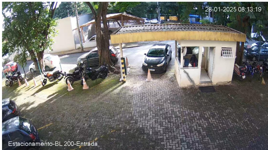
Figura 5.10: Portaria destinada para entrada de veículos localizada na Rua 62
