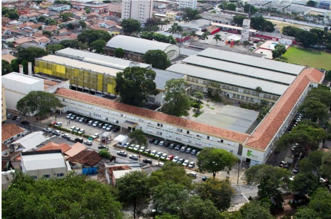
Figura 4.2: Vista aérea do Campus Goiânia do IFG
