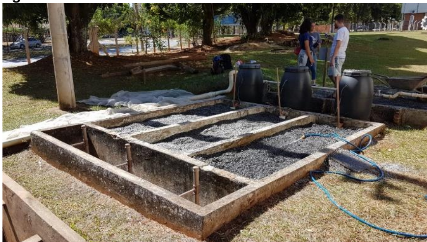
Figura 26 Preenchimento dos leitos com brita # 0
