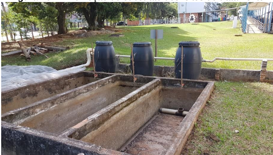
Figura 23 Remoção do substrato dos leitos de tratamento
