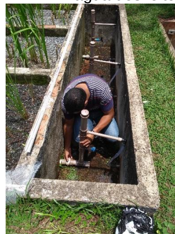
Figura 32 Descarga de água dos leitos
