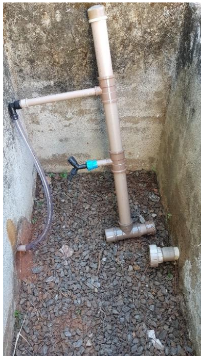
Figura 24 Substituição dos reguladores de nível
