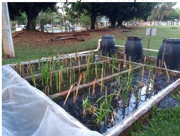
Figura 31 Saturação dos leitos durante o pegamento das plantas
