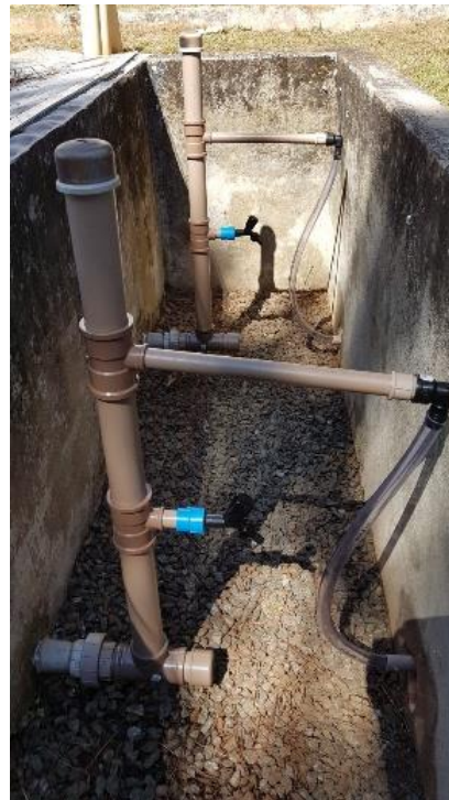
Figura 25 Instalação dos reguladores de nível
