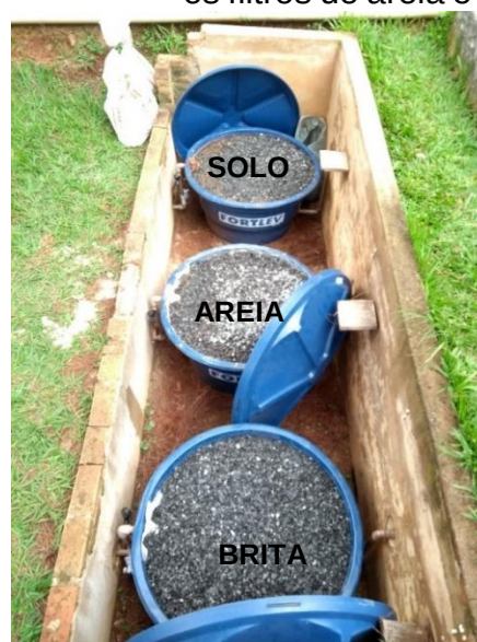
Figura 34 Acréscimo de uma camada de brita sobre os filtros de areia e solo
