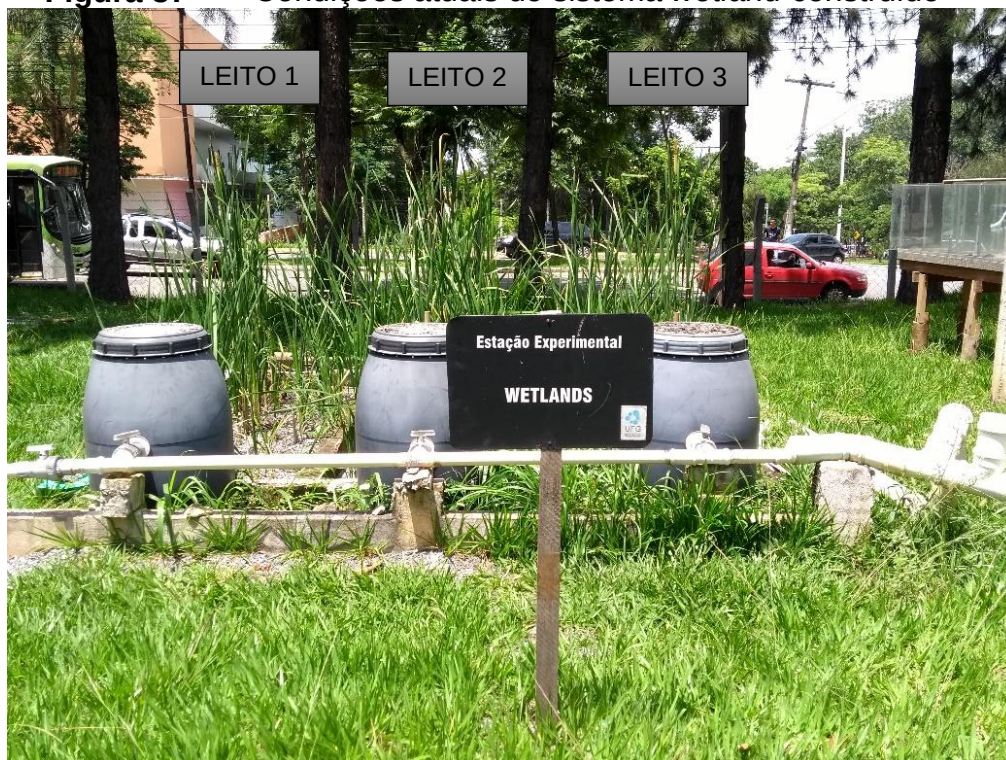
Figura 37 Condições atuais do sistema wetland construído
