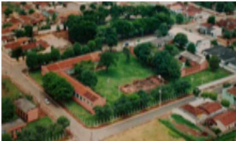
Figura 14 – Prédio da UEG – Câmpus Inhumas.
