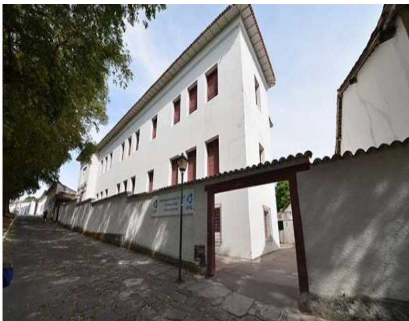
Figura 6 – Fachada do prédio da UFG – Câmpus Goiás.
