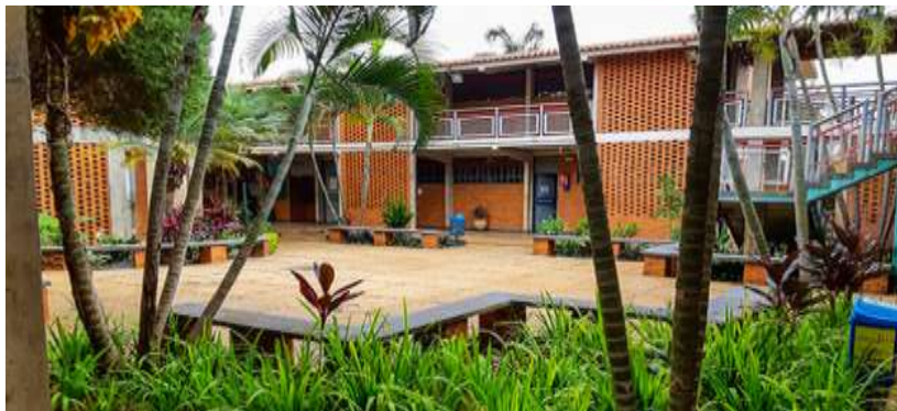
Figura 16 – Fachada do prédio da UEG – Câmpus Jaraguá.
