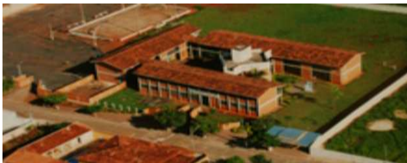
Figura 20 – Prédio da UEG – Câmpus Pires do Rio.
