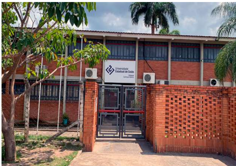
Figura 10 – Fachada do prédio da UEG – Câmpus Campos Belos.
