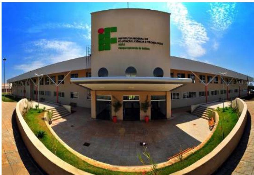
Figura 3 – Fachada do prédio do IFG – Câmpus Aparecida de Goiânia.
