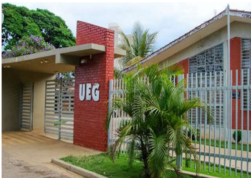
Figura 12 – Fachada do prédio da UEG – Câmpus Formosa.
