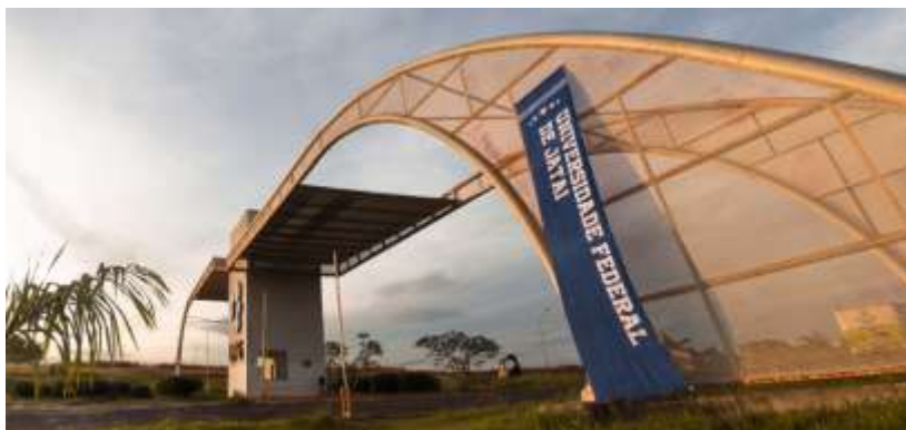
Figura 8 – Fachada da portaria da UFJ – Câmpus Jataí.
