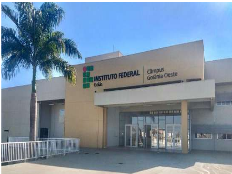
Figura 2 – Fachada do prédio do IFG – Câmpus Goiânia Oeste.
