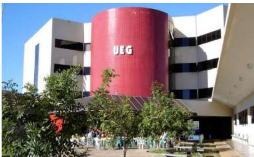
Figura 9 – Fachada do prédio UEG – Câmpus Anápolis.
