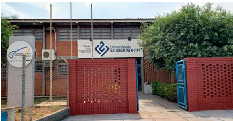
Figura 19 – Fachada do prédio da UEG – Câmpus Minaçu.
