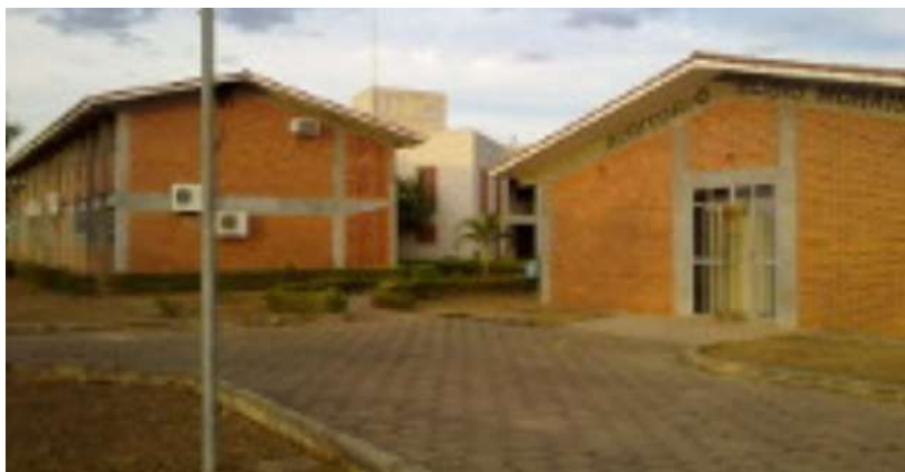
Figura 18 – Fachada do prédio da UEG – Câmpus Luziânia.
