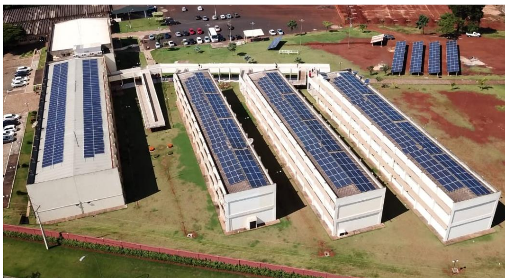
Figura 19 - Sistema dos blocos 200, 300, 400 e 500
