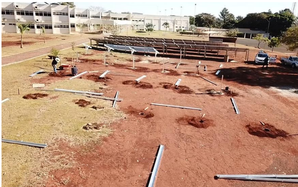
Figura 15 - Construção do sistema fotovoltaico da Licitação 2 em 2021 no IFG – Itumbiara
