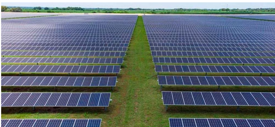
Figura 1 - Painéis solares fotovoltaicos
