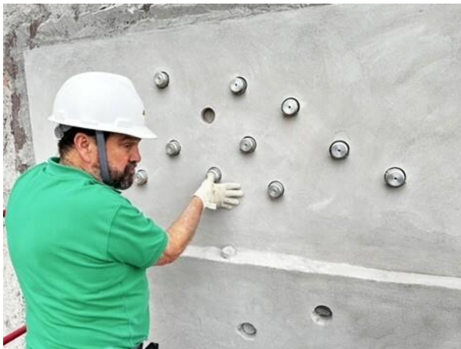
Figura 6 – Realização do ensaio de arrancamento
