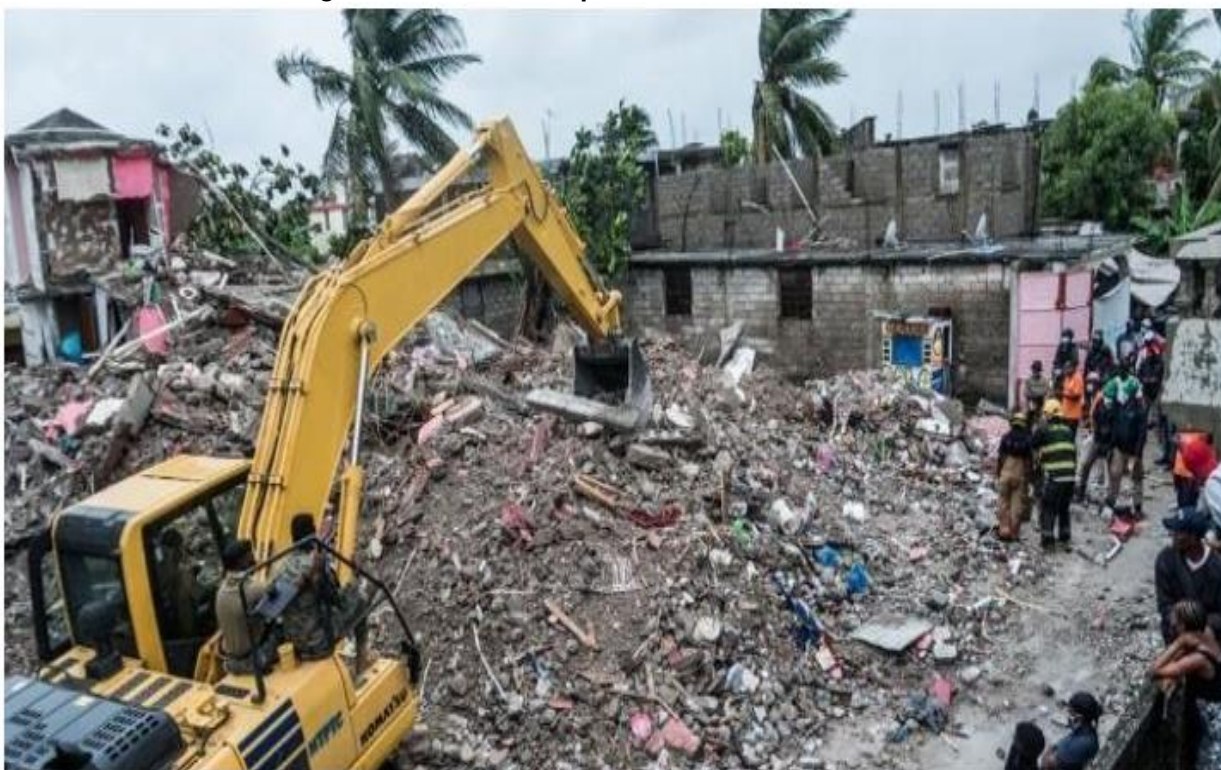
Figura 7 - Escavadora para retirar os escombros.
