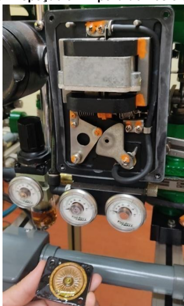
Figura 73: Inspeção e Limpeza do Posicionador
