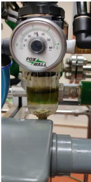
Figura 71: Recipiente Filtro Regulador
