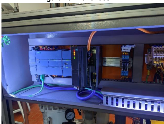
Figura 79: Conexões CLP
