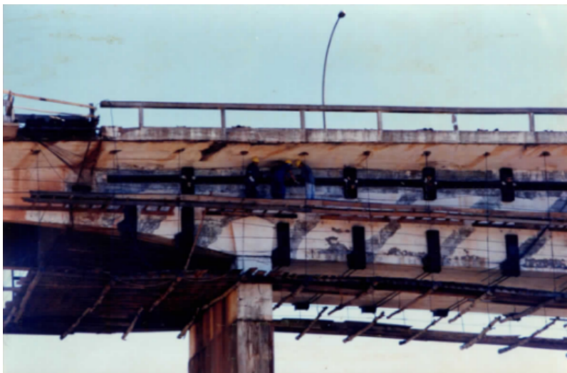
Figura 4.6 - Execução de reforço estrutural na parte externa da superestrutura da ponte.
