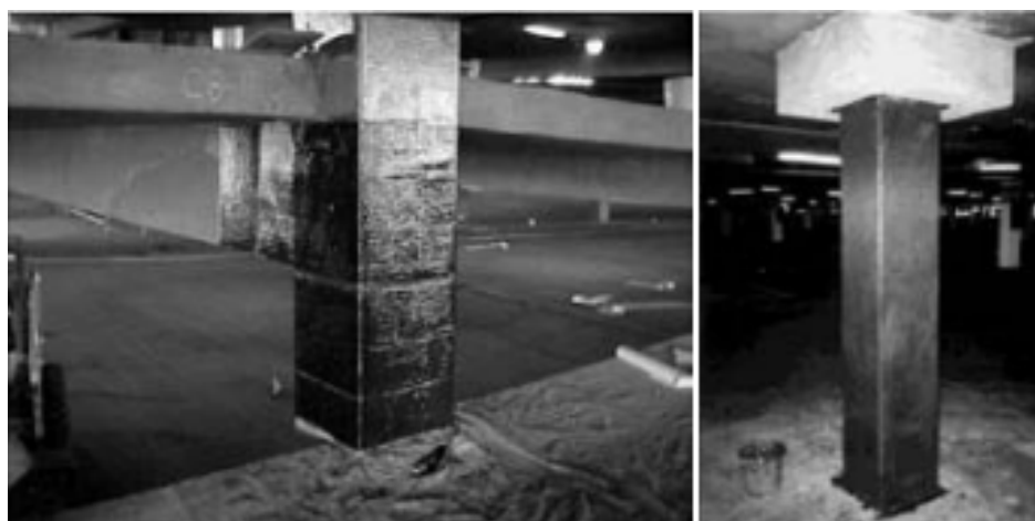
Figura 2.14- Exemplo real de reforço de pilar de concreto armado com combate a esforços de compressão por meio do confinamento.
