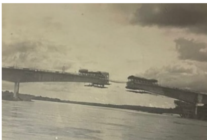
Figura 4.11 - Execução de escoramento para concretagem por etapas de aduelas da Ponte Juscelino Kubitschek por meio de balanços sucessivos.
