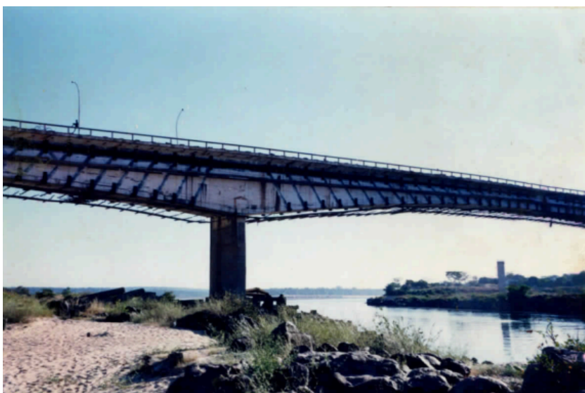
Figura 4.12- Posicionamento dos cabos de protensão.
