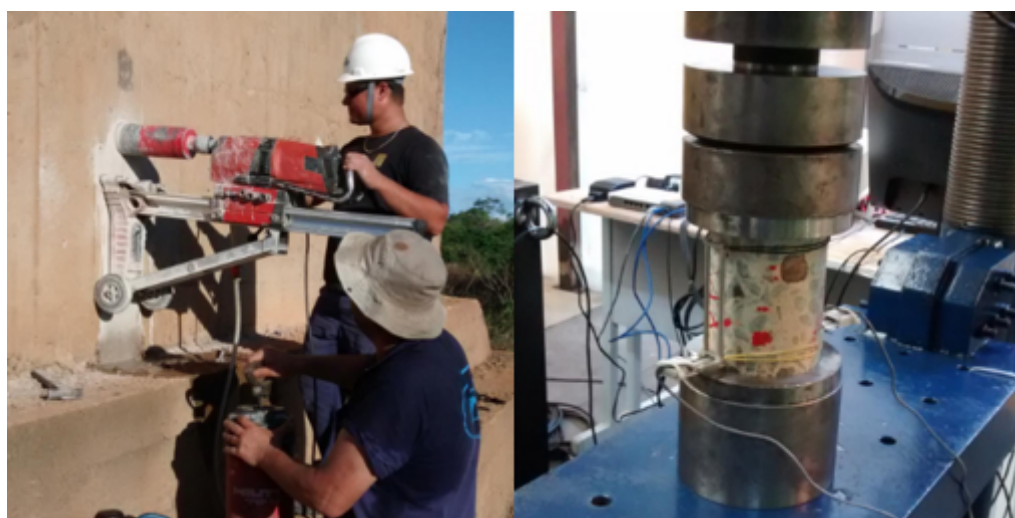
Figura 8.1 - À esquerda a extração de testemunhos do concreto da ponte e à direita o rompimento dos testemunhos por compressão simples para determinação do módulo de elasticidade e resistência do concreto da ponte.
