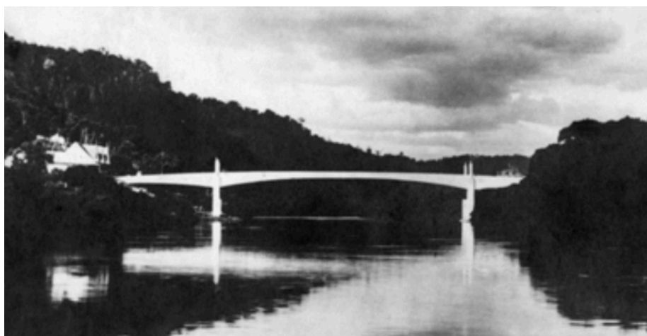
Figura 4.9 - Ponte sobre o Rio do Peixe – Santa Catarina (Herval do Oeste) feita pelo Eng. Emílio Baumgart.
