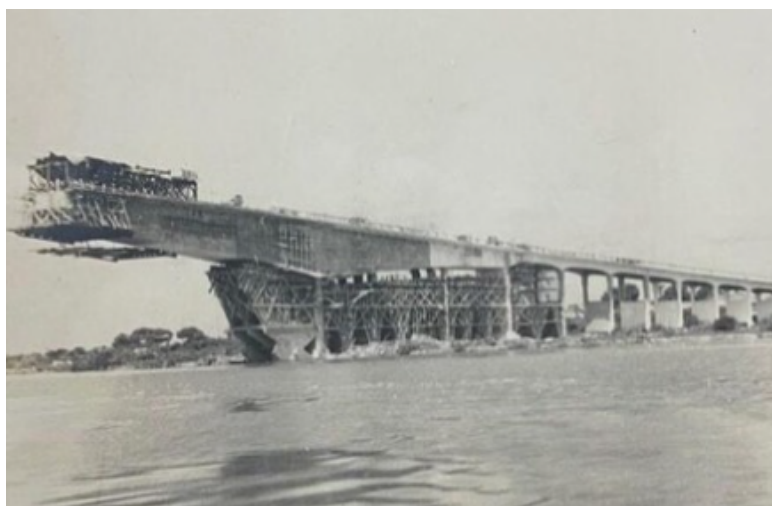
Figura 4.10 - Execução de escoramento para concretagem por etapas de aduelas da Ponte Juscelino Kubitschek por meio de balanços sucessivos.
