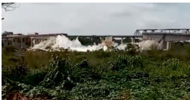
Figura 7.1 - Foto retirada de um vídeo que mostrava a ponte, quando de repente ocorre o colapso da estrutura.
