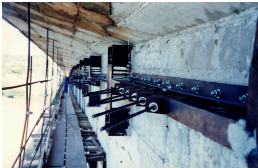
Figura 4.14 - Lançamento de cabos de protensão, ancoradas em peças metálicas.
