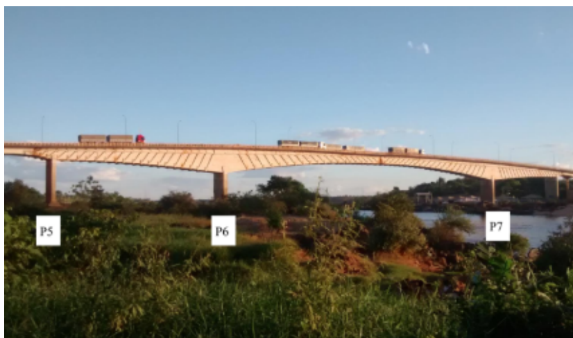
Figura 5.1 - Detalhe do vão central da ponte dos pilares P6 a P7.
