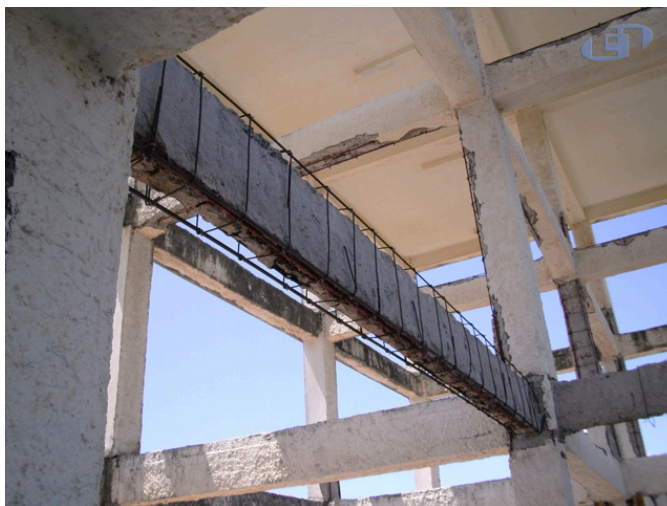
Figura 2.18- Reforço de viga por aumento de seção e novas armaduras longitudinais e transversais.
