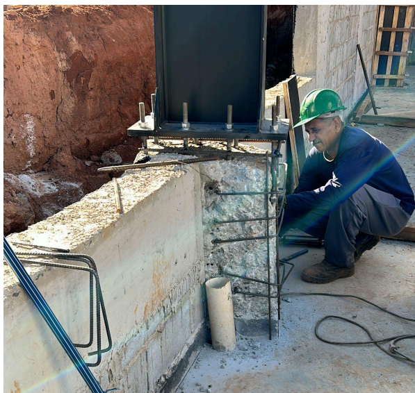
Figura 2.21 - Imagem durante execução da inserção de armaduras e fixação das barras longitudinais e transversais por adesivo epóxi estrutural conforme projeto do reforço.
