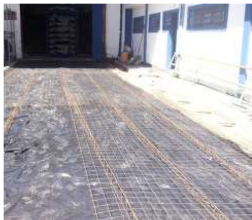
Figura 23: Posicionamento das Armaduras
