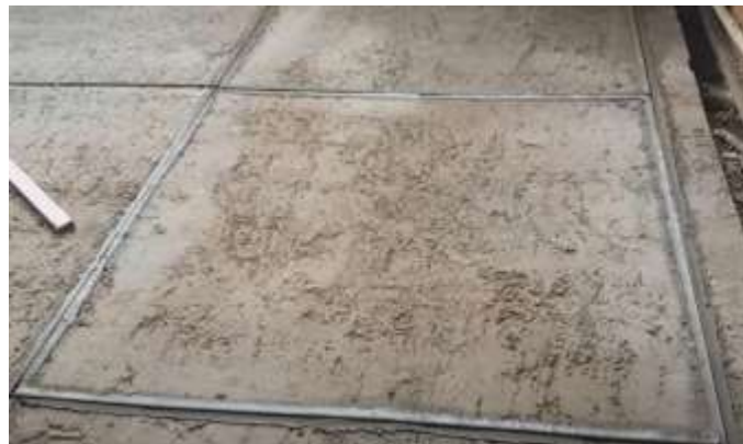
Figura 9: Instalação das juntas
