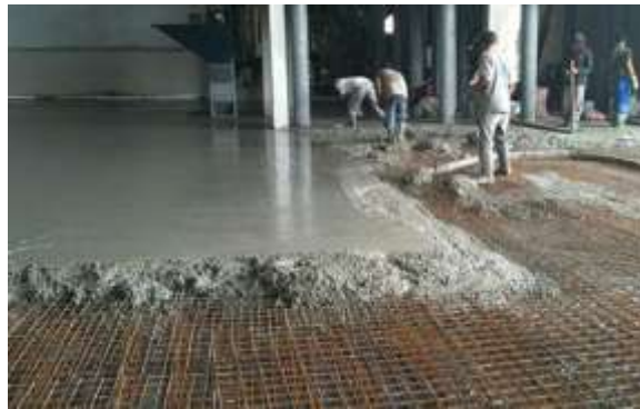
Figura 24: Concretização
