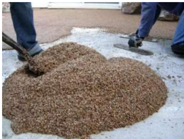
Figura 14: Adição do agregado de granilite
