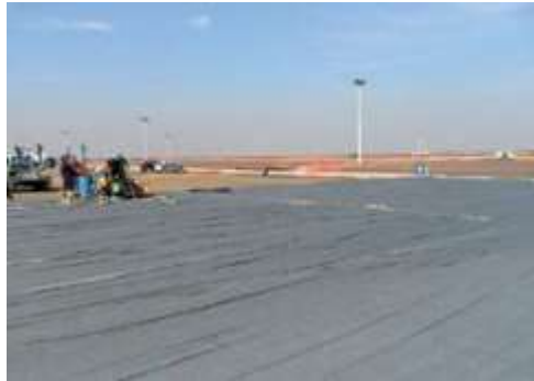
Figura 22: Instalação de Barreiras de Vapor
