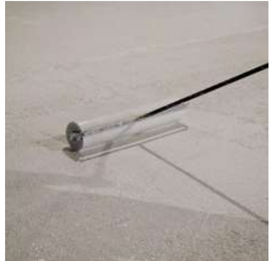
Figura 13: Compactação da superfície
