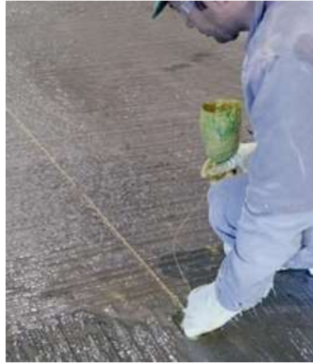
Figura 8: Marcação das juntas
