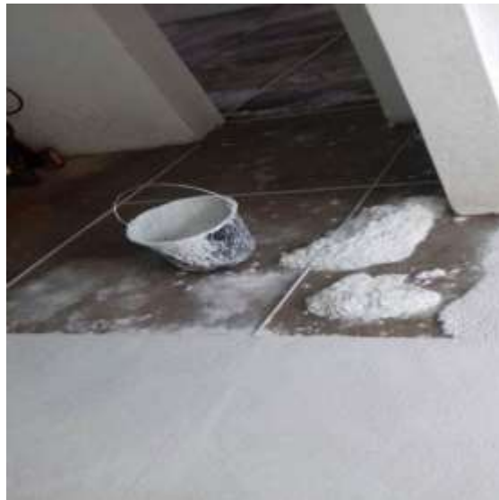
Figura 10: Aplicação da argamassa
