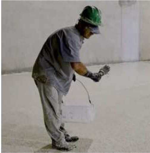
Figura 12: Umedecimento da superfície
