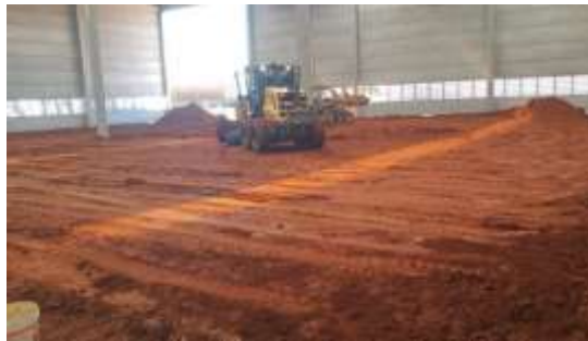
Figura 20: Terraplenagem e Compactação
