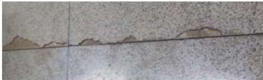
Figura 6: Deslocamento de granilite
