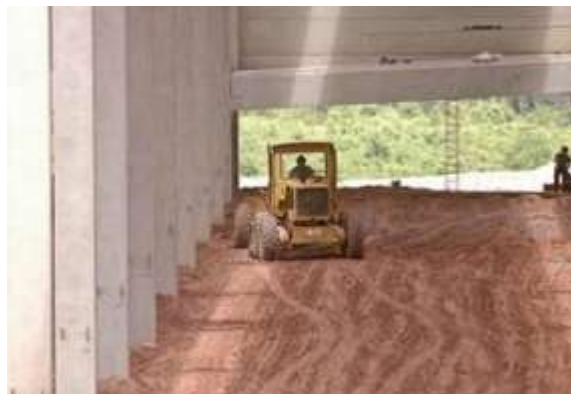
Figura 21: Preparação da Sub-base
