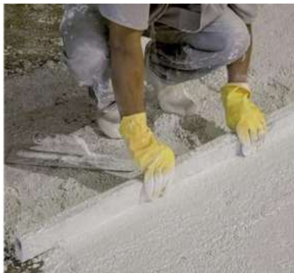
Figura 11: Sarrafeamento da argamassa
