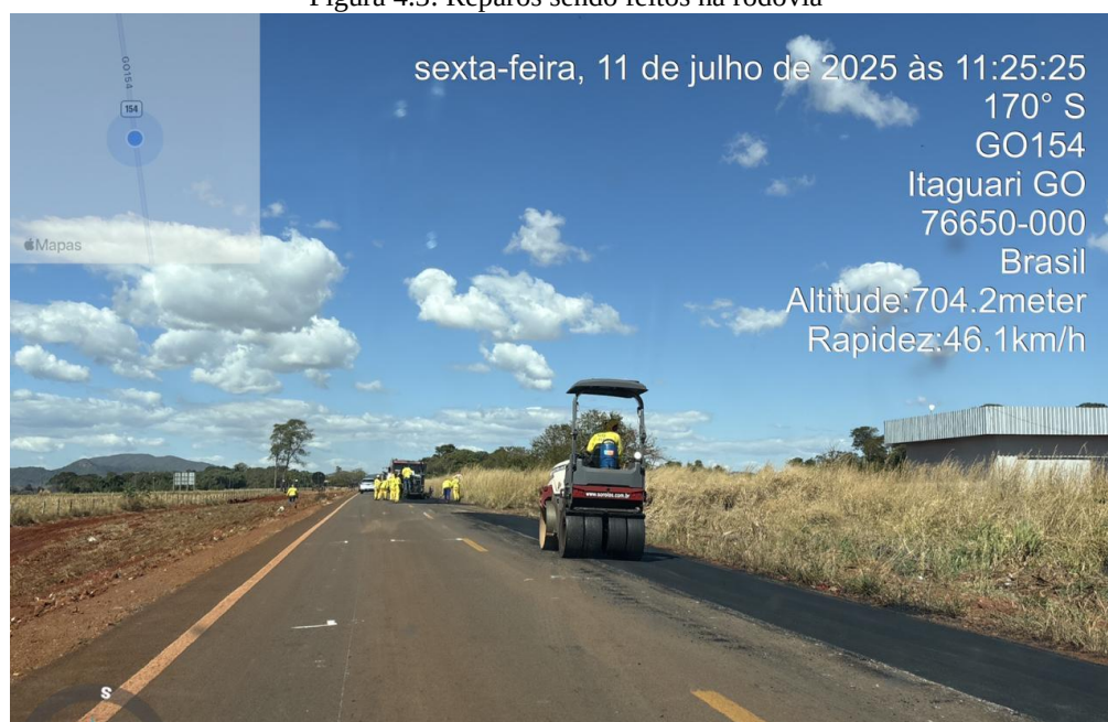
Figura 4.3: Reparos sendo feitos na rodovia
