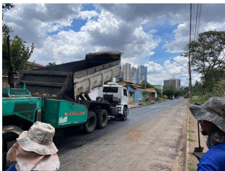
Figura 2.4 – aplicação de CBUQ
