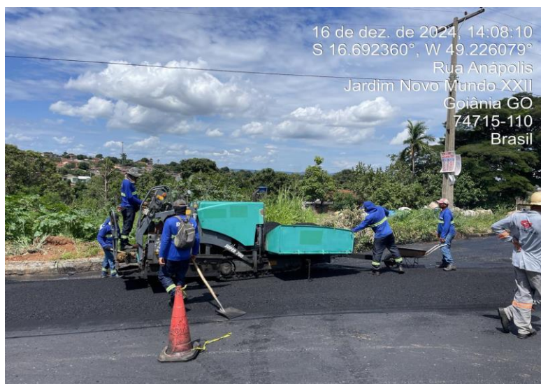
Figura 2.5 – aplicação de CBUQ
