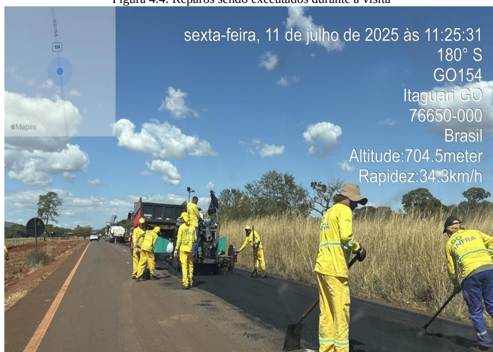
Figura 4.4: Reparos sendo executados durante a visita
