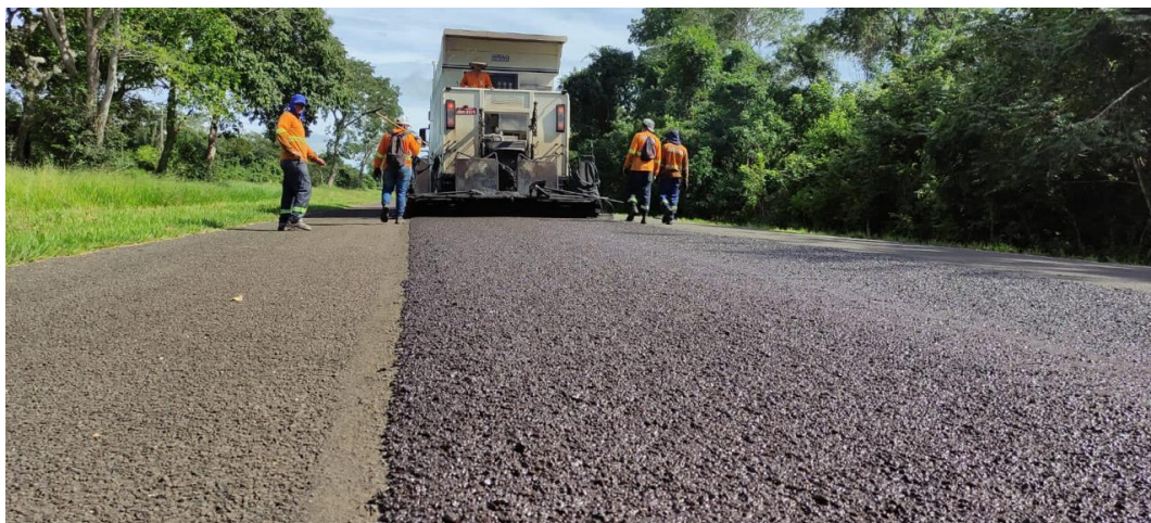
Figura 2.9 – Usina móvel de microrrevestimento
