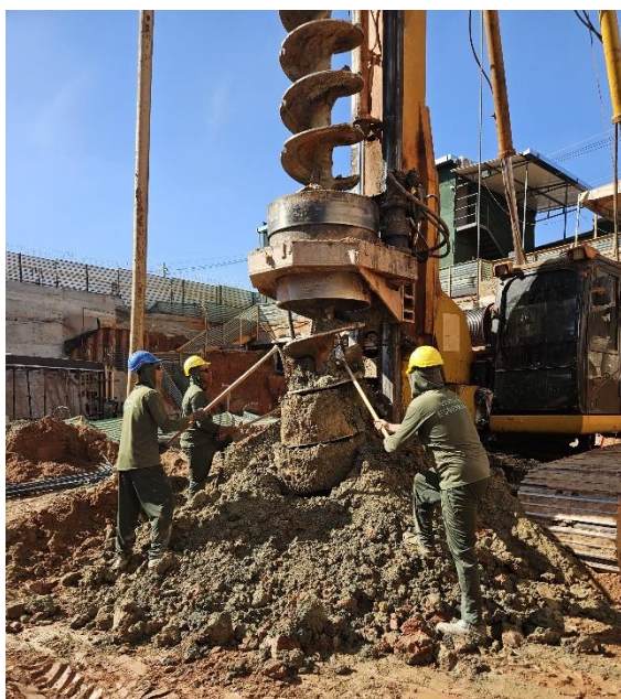
Figura 4 – Extração da haste e limpeza do solo.
