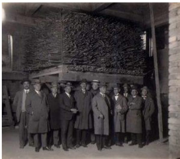
Figura 1 – Prova de carga em sapata no edifício Martinelli em São Paulo, no ano de 1928.
