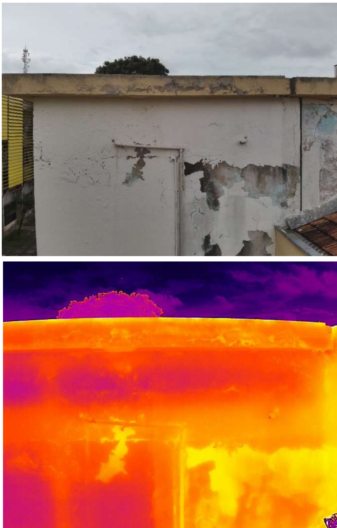
Figura 77 – A: Visão de parte da Fachada Oeste. B: Representação termográfica da Figura 77A
