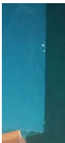
Fotografia 51 – Deterioração do revestimento em madeirite da lateral da plateia inferior do Teatro (Cor no gráfico: rosa).
