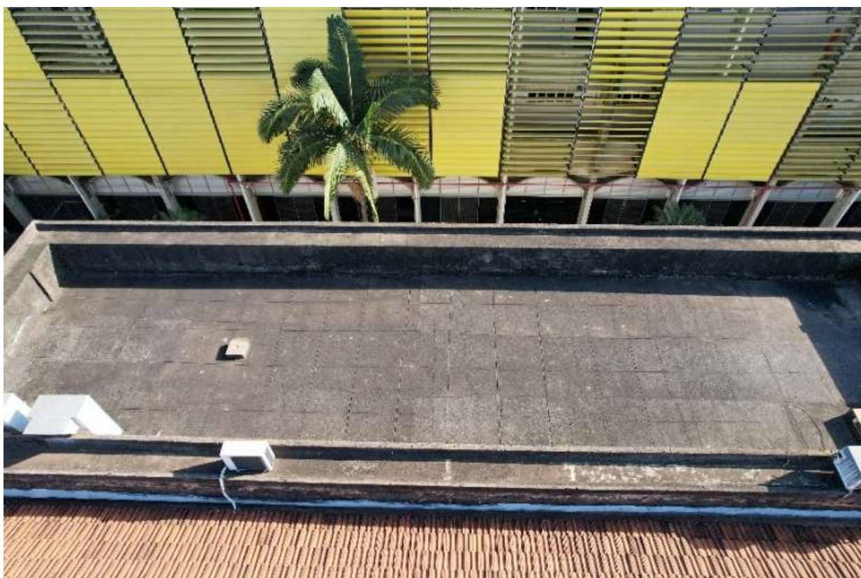
Figura 63 – Cobertura do Teatro IFG – Campus Goiânia em direção a Fachada Norte às 08:00.
