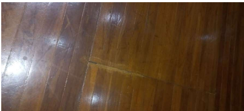
Fotografia 54 – Fenda construtiva no piso do palco do Teatro (Cor no gráfico: roxo).
