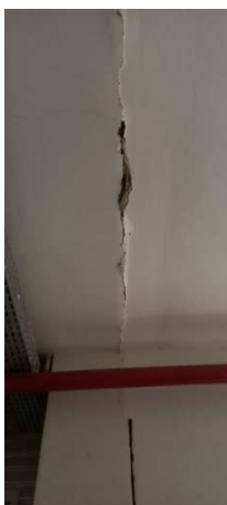
Fotografia 33 – Ausência de tratamento das juntas de dilatação na circulação em direção ao Foyer 2 (Cor no gráfico: preto).
