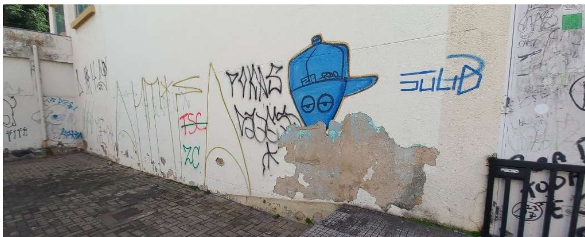
Figura 79 – Parte inferior da Fachada Sul.
