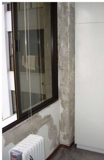
Figura 24 – Reboco pulverulento.
