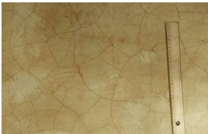
Figura 22 – Fissuras mapeadas.
