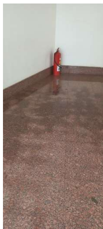
Fotografia 47 – Piso com manchas e som cavo (Cor no gráfico: amarelo e vermelho).
