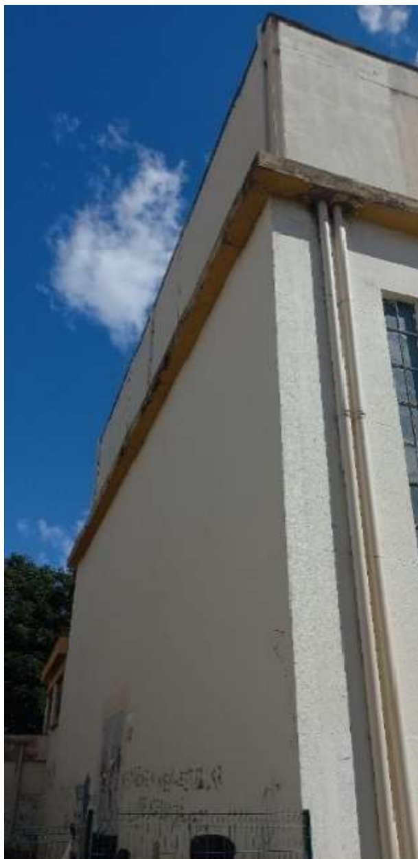
Figura 78 – Parte da Fachada Sul.
