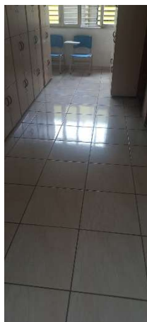
Fotografia 82 – Som cavo na circulação da sala com os sanitários (Cor no gráfico: roxo claro).
