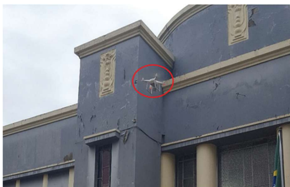
Figura 51 – Realização dos registros fotográficos da fachada de um edifício por meio da utilização de VANT.
