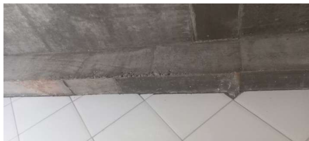
Fotografia 85 – Agregado graúdo aparente na viga situada nos sanitários (Cor no gráfico: verde limão).
