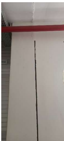
Fotografia 32 – Ausência de tratamento das juntas de dilatação na circulação em direção ao Foyer 2 (Cor no gráfico: preto).
