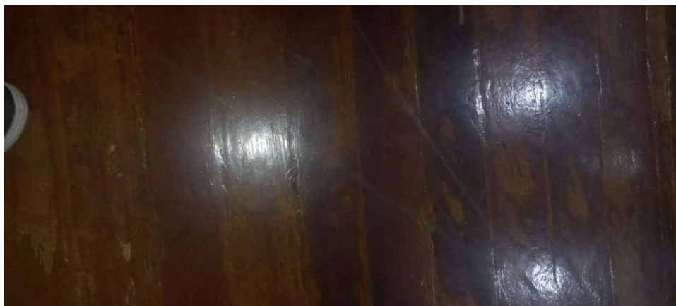
Fotografia 55 – Fenda natural da madeira no piso do palco do Teatro (Cor no gráfico: roxo).
