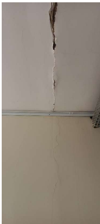
Fotografia 34 – Ausência de tratamento das juntas de dilatação na circulação em direção ao Foyer 2 (Cor no gráfico: preto).
