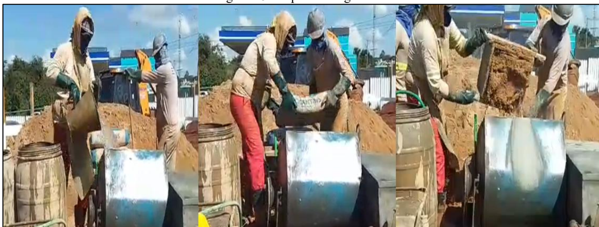
Figura 28: Preparo da argamassa
