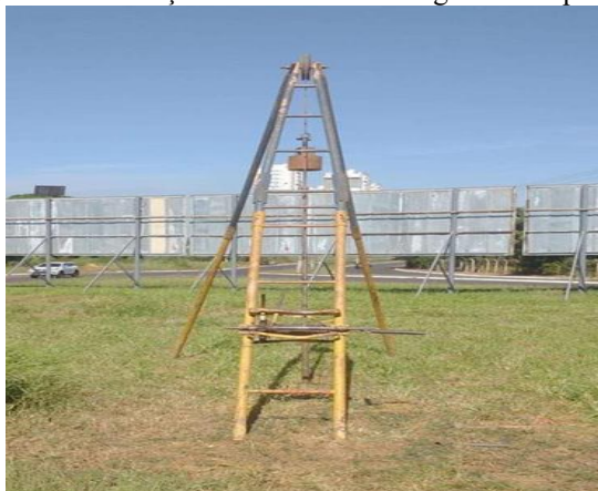
Figura 13: Execução dos furos de sondagem da empresa B
