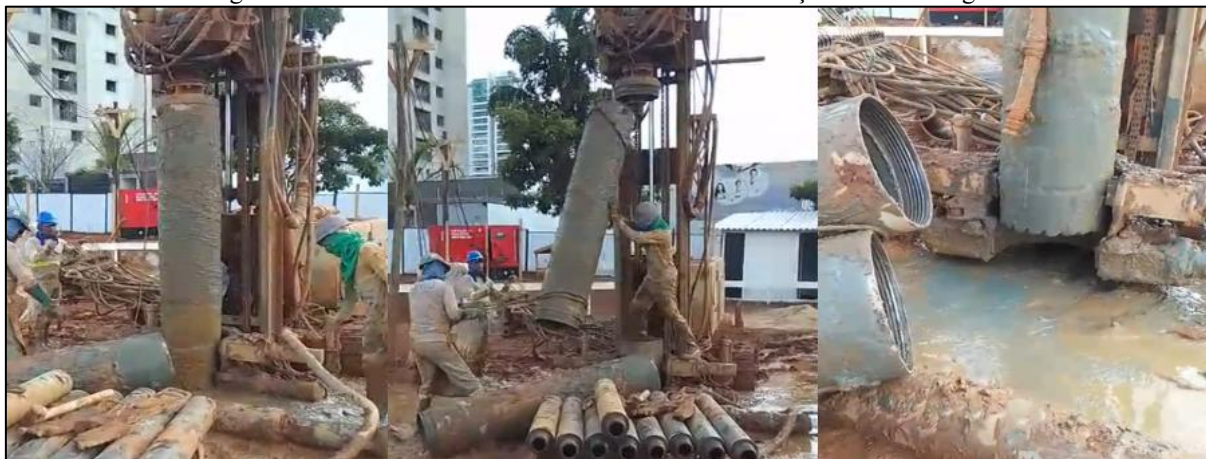
Figura 30: Retirada do revestimento metálico e finalização da concretagem
