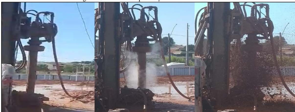
Figura 26: Processo de perfuração da camada de rocha
