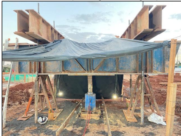
Figura 31: Sistema de reação e dispositivo de aplicação de carga
