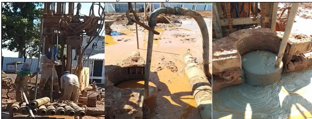
Figura 29: Concretagem da estaca
