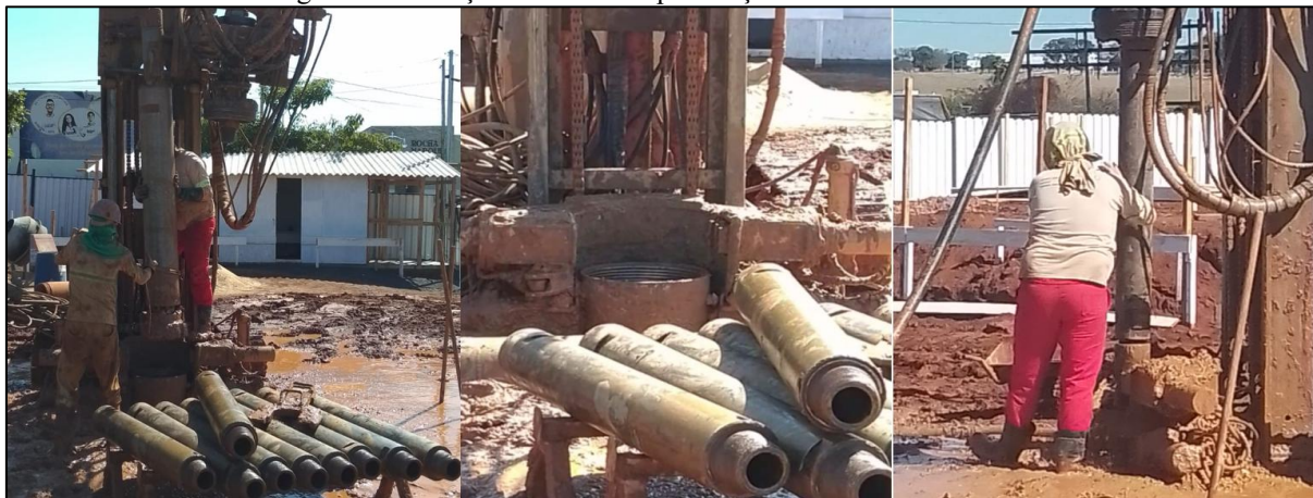
Figura 25: Avanço das hastes de perfuração e revestimento do furo
