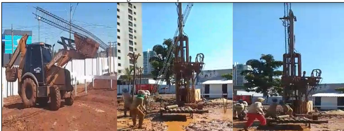
Figura 27: Introdução da armadura
