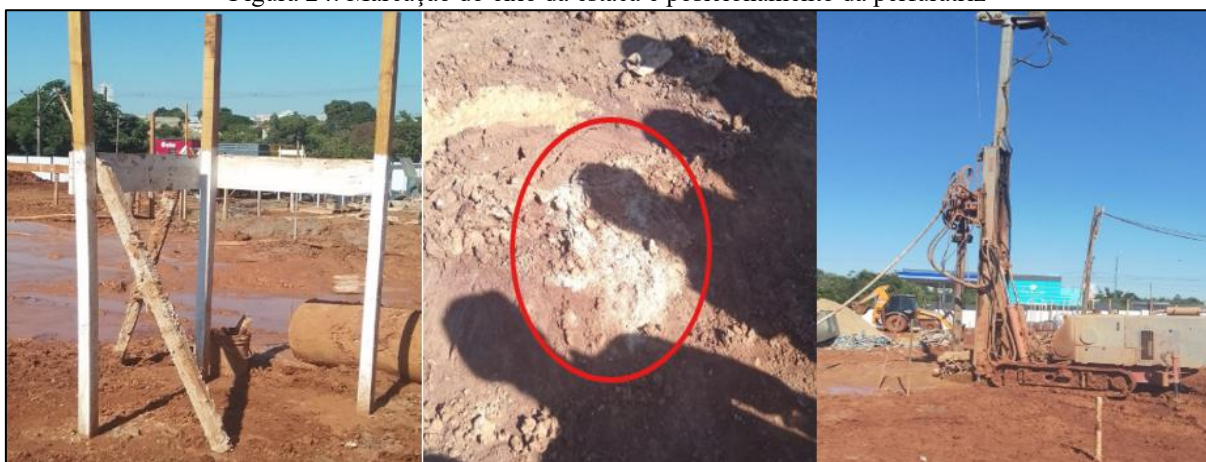
Figura 24: Marcação do eixo da estaca e posicionamento da perfuratriz
