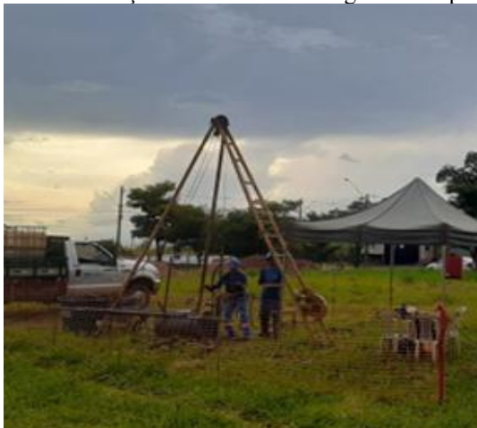
Figura 10: Execução dos furos de sondagem da empresa A
