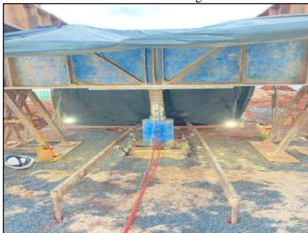
Figura 33: Deflectômetros fixados em vigas de referência metálica.
