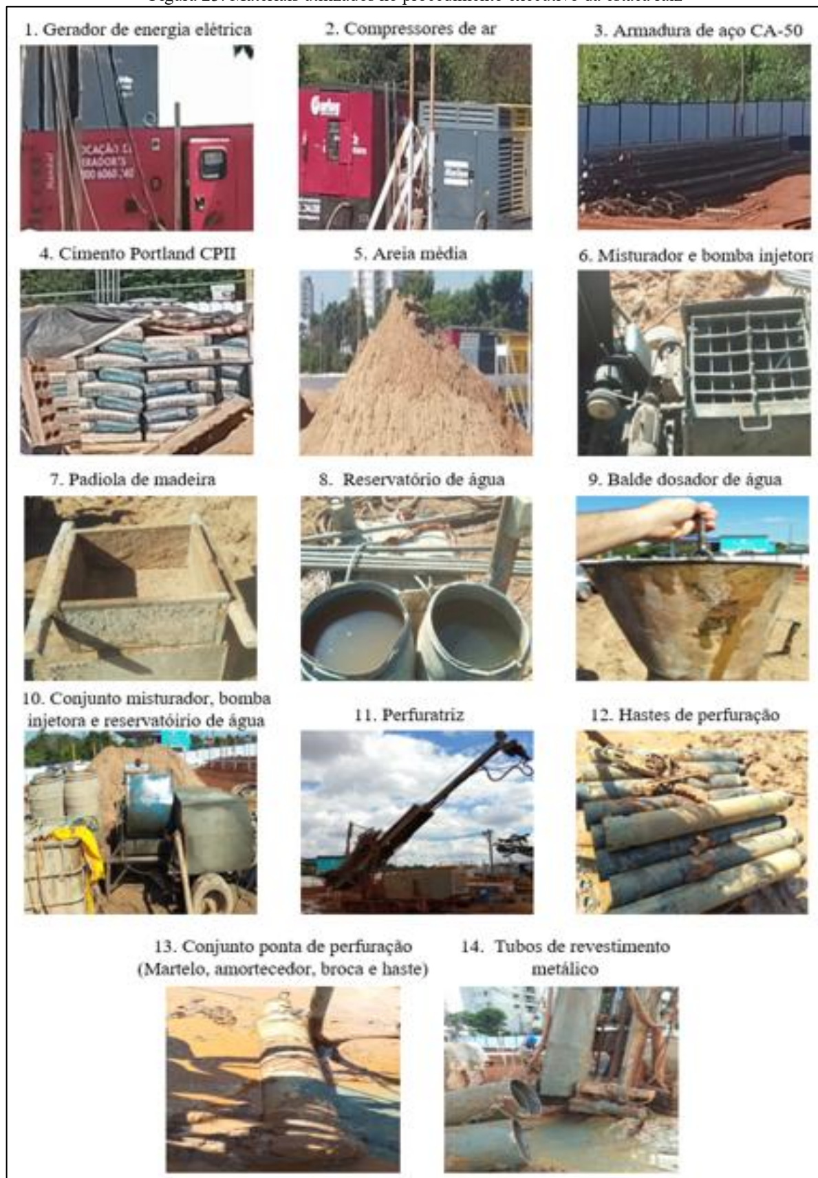
Figura 23: Materiais utilizados no procedimento executivo da estaca raiz
