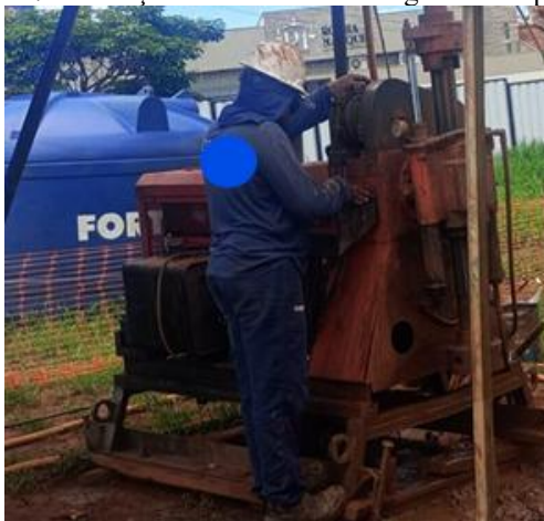
Figura 17: Execução dos furos de sondagem da empresa C
