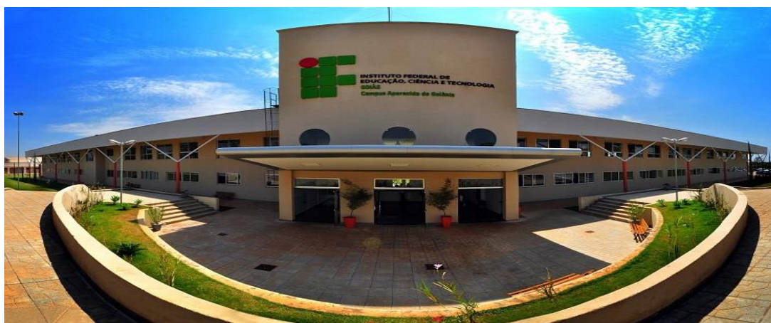
Figura 6: fachada do Câmpus Aparecida de Goiânia
