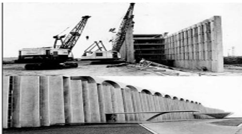
Figura 14: Quartel General de Brasília - construção
