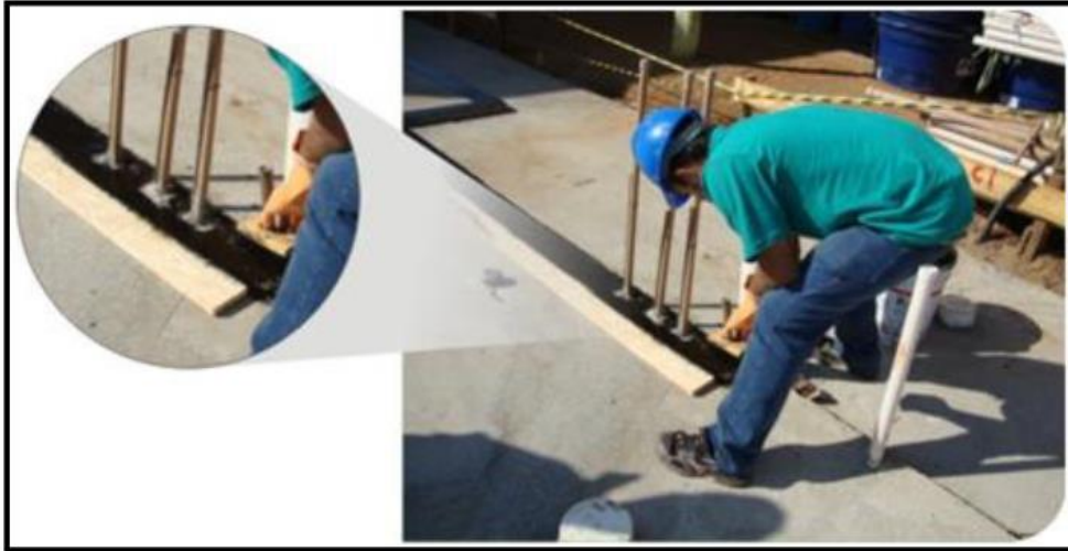
Figura 2.5 - Impermeabilização da base para os tijolos de solo-cimento
