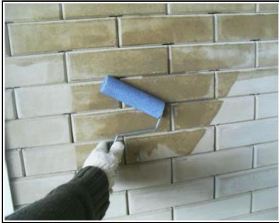
Figura 2.9 - Aplicação de resina impermeabilizante nos tijolos de solo-cimento
