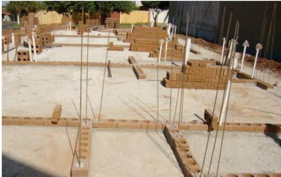
Figura 2.7 - Primeira fiada dos tijolos de solo-cimento finalizada
