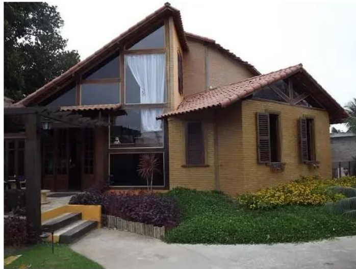
Figura 2.4 - Casa de tijolo ecológico com janelas de vidro
