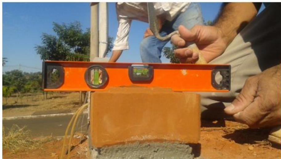
Figura 2.6 - Execução e verificação de nível da primeira fiada
