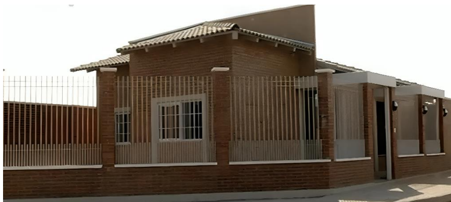
Figura 2.11 - Casa feita com tijolo de solo-cimento em Gurupi, Tocantins
