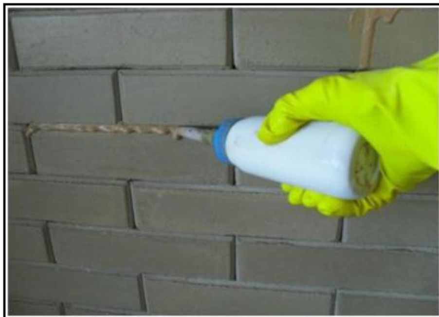
Figura 2.10 - Execução de rejunte nos tijolos de solo-cimento
