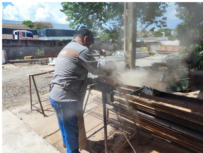
Figura 3.7 - Corte dos blocos com auxílio de serra
