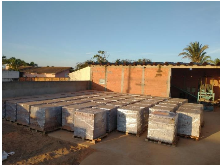
Figura 4.1 - Local de armazenamento e fabricação dos tijolos de solo-cimento
