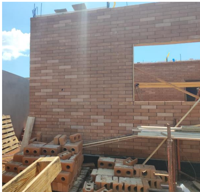
Figura 2.3 - Tijolos de Solo cimento em obra no município de Jataí-GO
