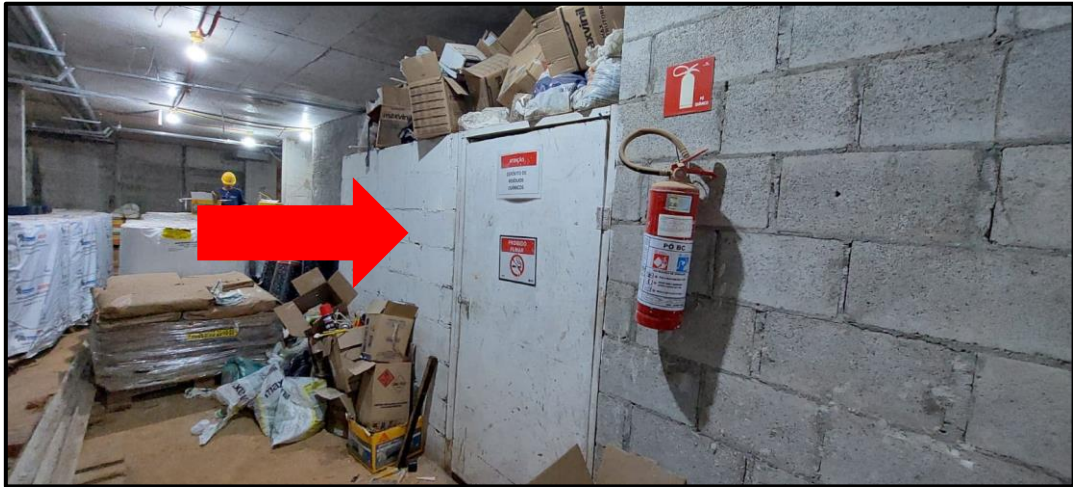
Figura 4 - Armazenamento de resíduos perigosos
