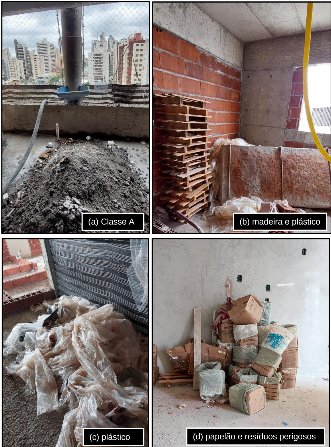
Figura 6 - Resíduos gerados nas obras, sendo: Classe A (a), madeira e plástico (b), plástico (c), papelão e resíduos perigosos (d)
