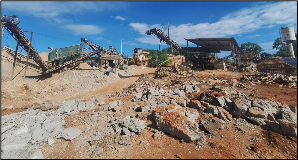
Figura 12 - Visão geral do pátio
