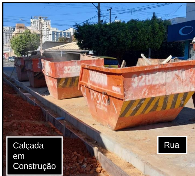
Figura 5 – Caçambas dispostas na rua, em frente à obra
