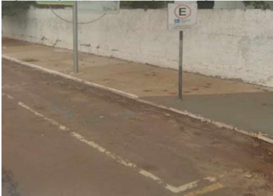
Figura 4.9 – Vagas de estacionamento na via pública fora dos padrões normativos
