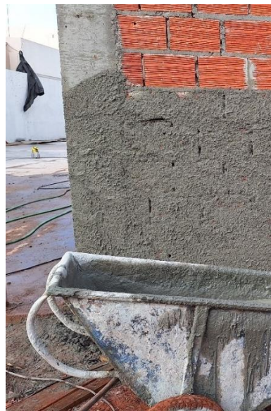
Figura 2.2 – Tipos de chapisco. (a) Chapisco aberto. (b) Chapisco fechado.
