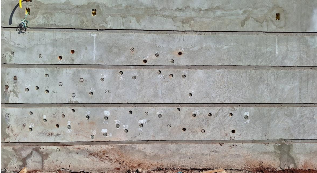
Figura 4.9 – Parede com identificação dos corpos de prova após realização do ensaio.
