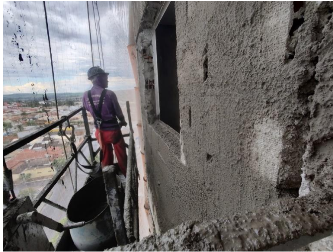
Figura 2.3 – Chapisco convencional aplicado em alvenaria de fachada.
