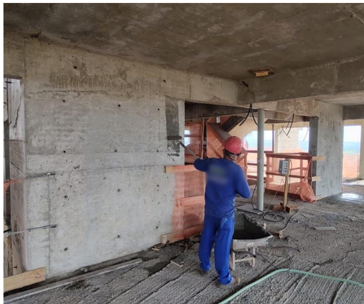
Figura 2.4 – Chapisco rolado sendo aplicado em estrutura de concreto armado internamente.
