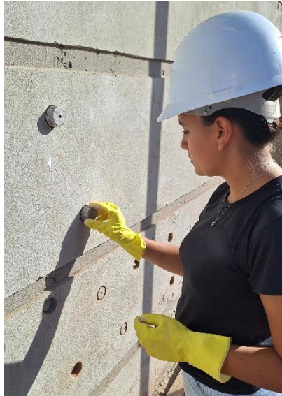
Figura 4.11 – Cortes a seco do revestimento.
