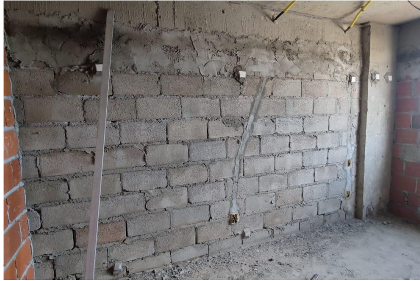
Figura 2.12 – Taliscas fixas em uma parede de blocos de concreto.
