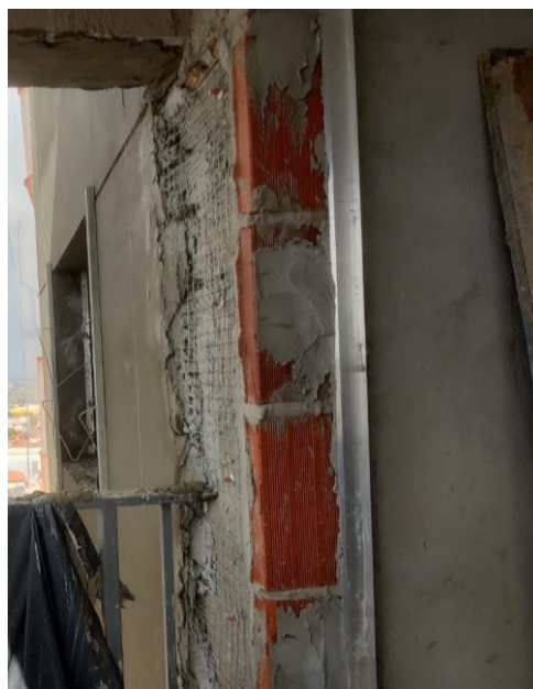
Figura 2.9 – Tela metálica zincada aplicada na região de encontro entre concreto e bloco cerâmico.
