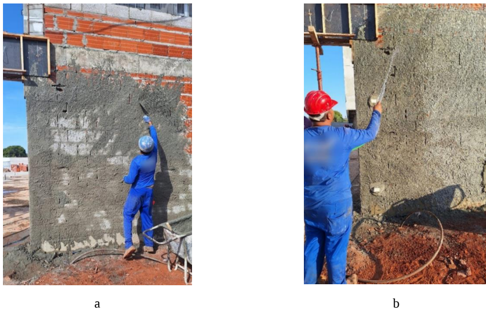
Figura 4.5 – Execução do chapisco. (a) Lançamento do chapisco. (b) Cura úmida do chapisco.
