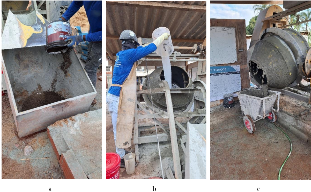
Figura 4.4 – Preparação das argamassas de chapisco. (a) Colocação da areia de britagem na betoneira. (b) Colocação da água com aditivos. (c) Chapisco finalizado sendo despejado em girica.
