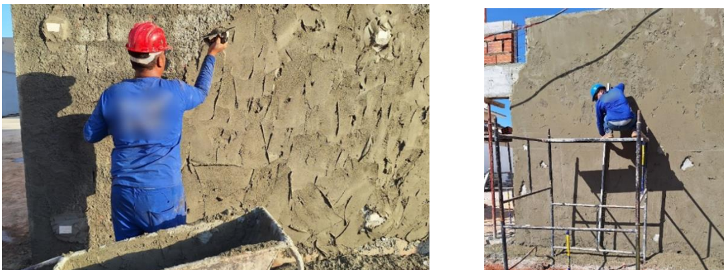
Figura 4.7 – Execução da argamassa de revestimento. (a) Lançamento da primeira camada. (b) Sarrafeamento da segunda camada.
