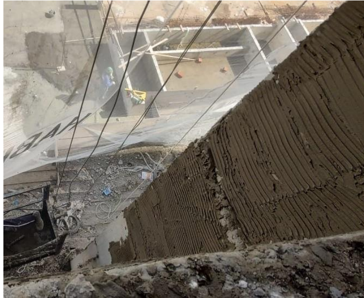
Figura 2.5 – Chapisco industrializado sendo aplicado em estrutura de concreto armado em fachada.
