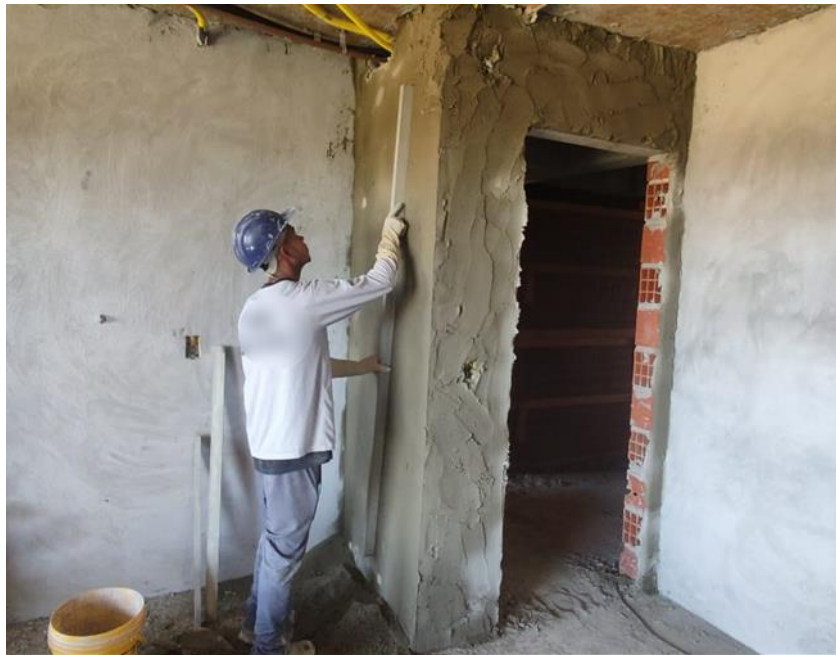
Figura 2.14 – Sarrafeamento da argamassa de revestimento.
