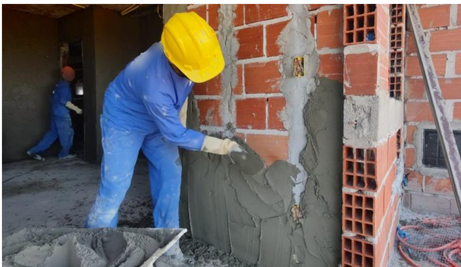
Figura 2.13 – Lançamento da argamassa com colher de pedreiro.
