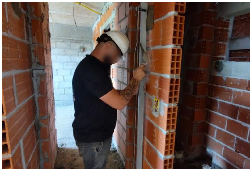
Figura 2.11 – Taliscamento sendo executado com prumo fixado em uma régua.
