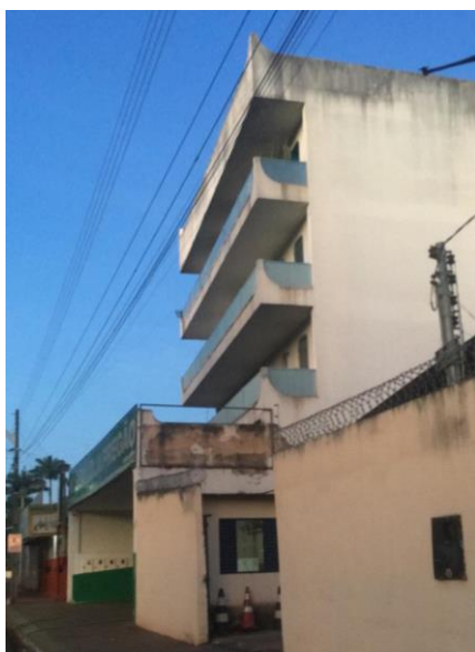
Figura 7 – Edifício ED41 situado à Avenida Goiás, Vila Progresso
