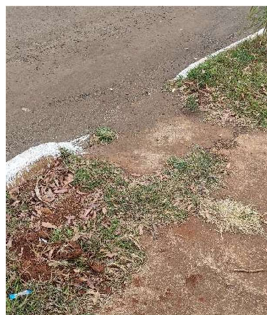
Figura 4.64: Rampa de acesso irregular
