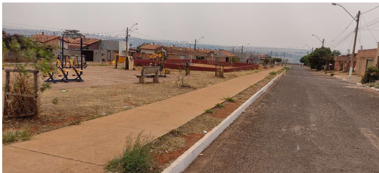
Figura 4.39: Situação do piso
