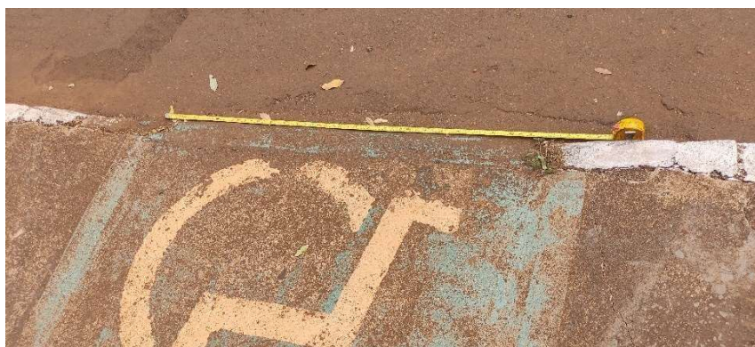
Figura 4.30: Aferição comprimento Rampa de acesso
