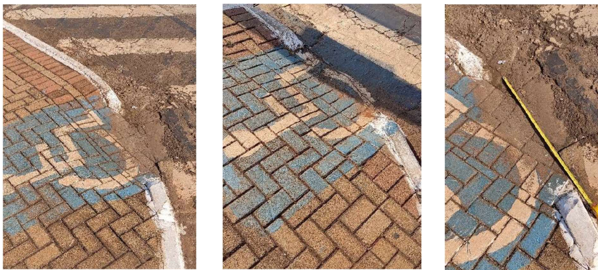
Figura 4.24: Situação Rampa de acesso
