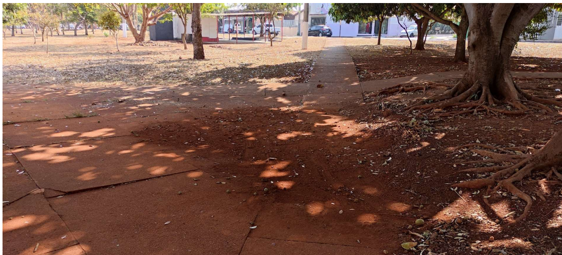
Figura 4.56: Falta de sinalização direcional e de alerta ao longo da calçada
