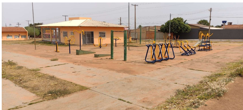
Figura 4.46: Falta de sinalização na calçada
