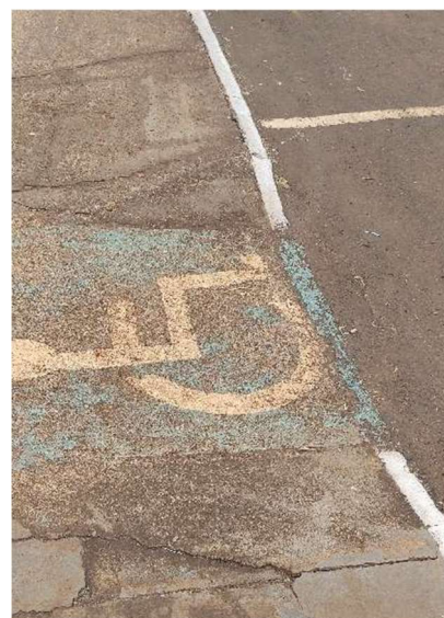
Figura 4.29: Rampa de acesso
