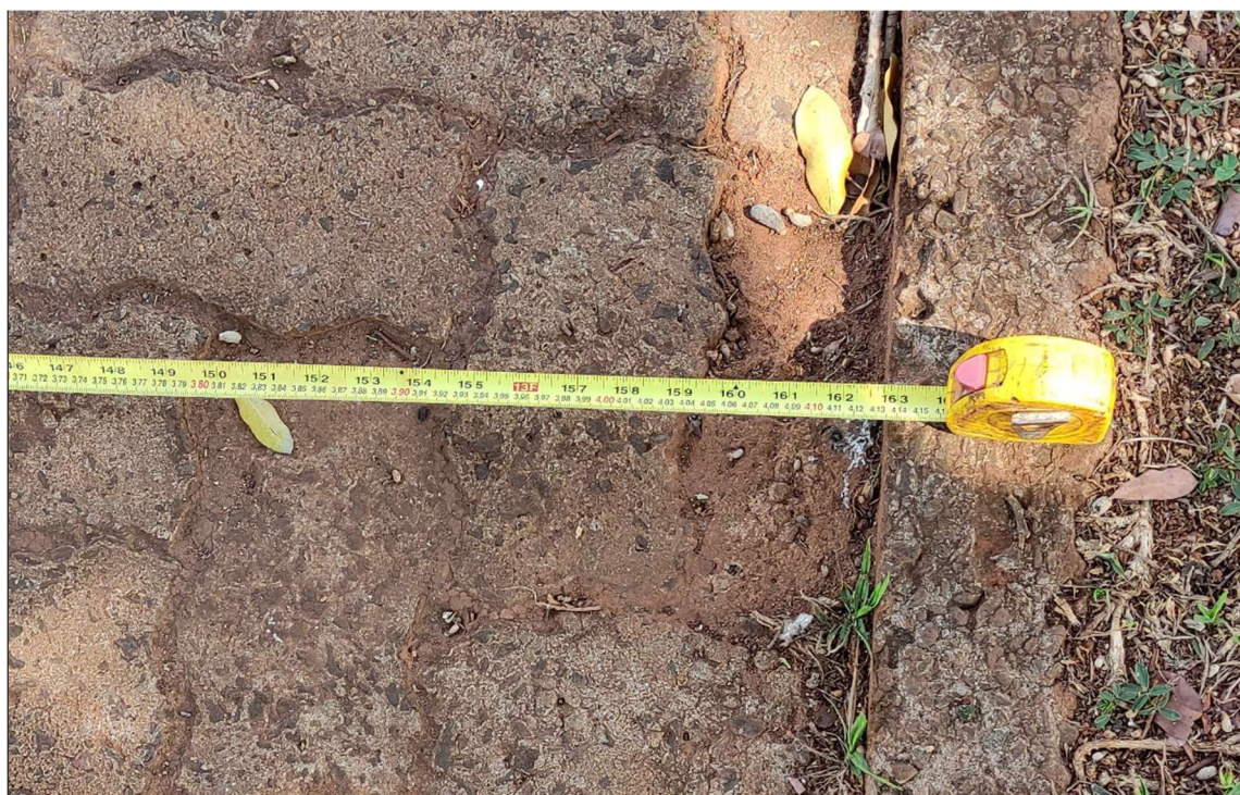
Figura 4.5: Largura da Calçada Avaliada
