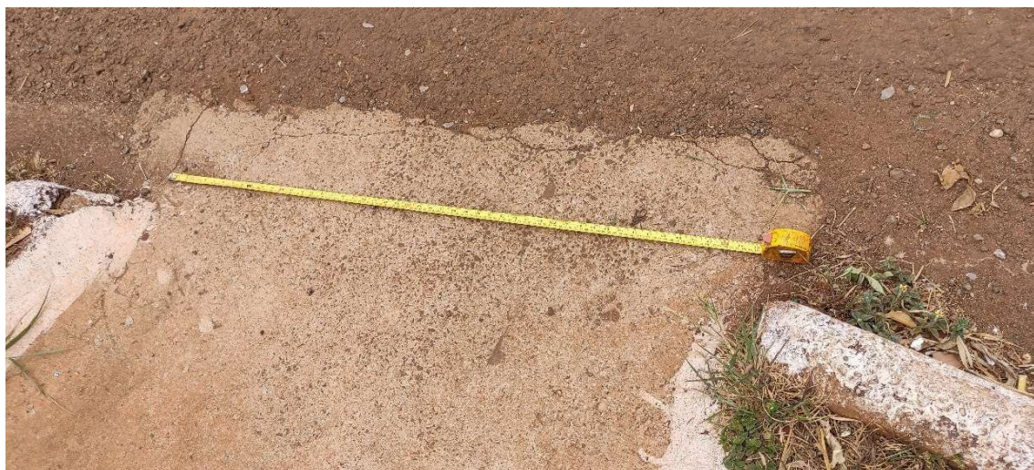
Figura 4.41: Aferição rampas de acesso
