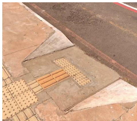
Figura 3.4: Calçada com sinalização de alerta
