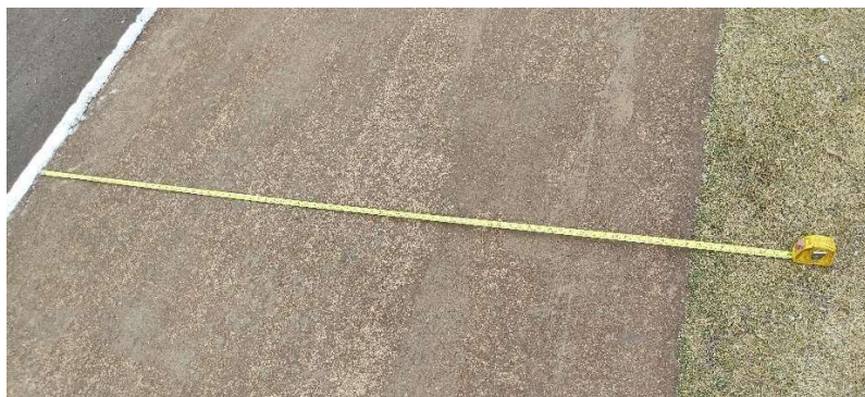
Figura 4.27: Largura da calçada avaliada
