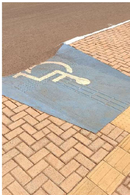
Figura 4.70: Rampas de acesso
