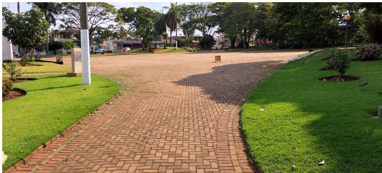
Figura 4.23: Falta de sinalização no decorrer na calçada
