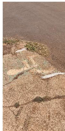
Figura 4.48: Rampa de acesso
