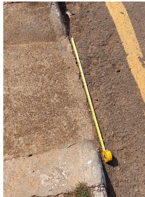
Figura 4.8: Comprimento rampa de acesso
