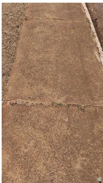
Figura 4.51: Material do piso
