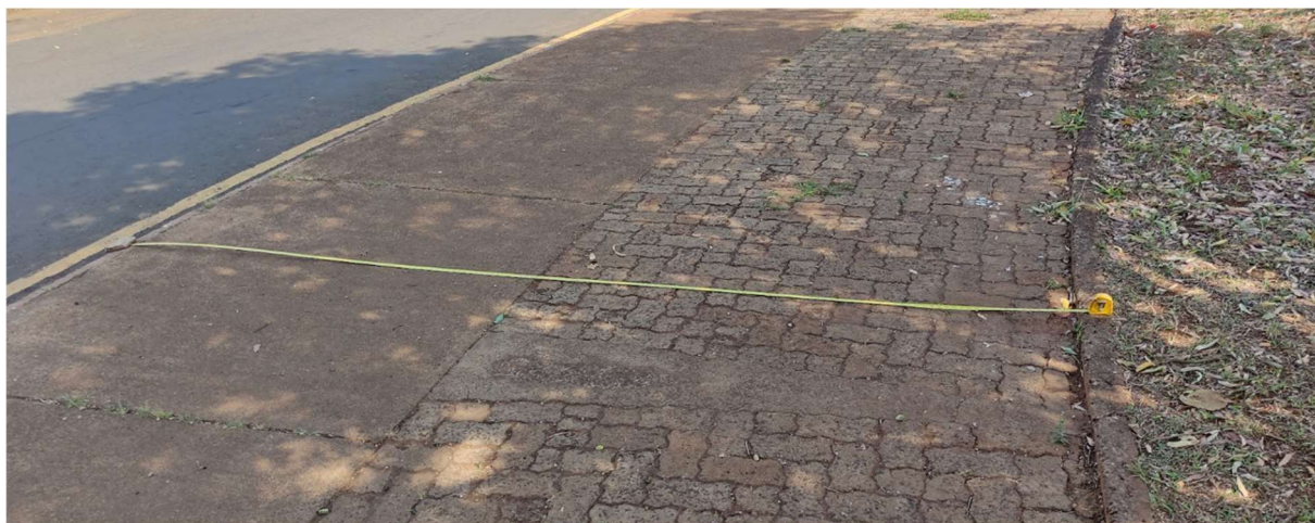
Figura 4.4: Largura da Calçada Avaliada
