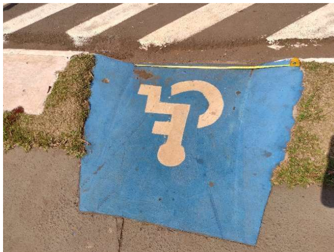
Figura 4.15: Rampa de acesso aferida
