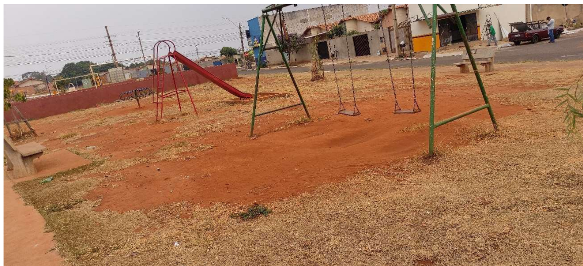
Figura 4.38: Falta de calçadas para acesso a equipamentos da praça
