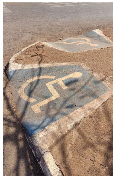
Figura 4.58: Rampas de acesso
