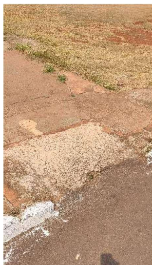
Figura 4.47: Rampa de acesso
