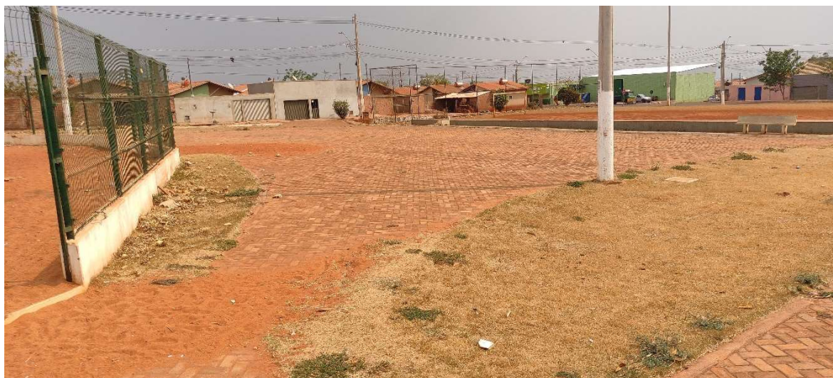
Figura 4.35: Falta de Sinalização ao longo de toda a calçada
