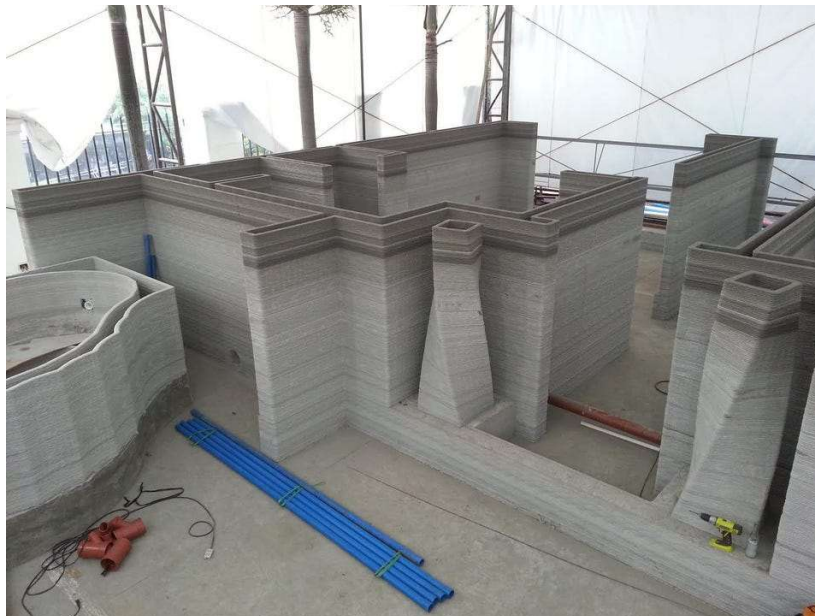
Figura 2.1 – Execução de edificação em impressão 3D.
