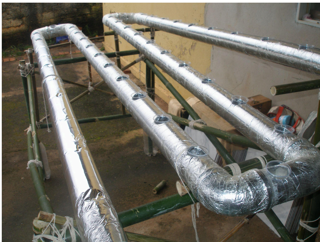
Figura 4 - Estruturas das canaletas 2.
