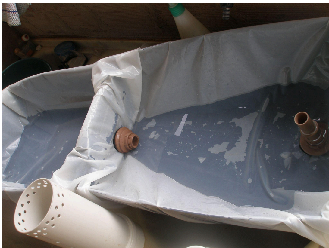
Figura 7 - Montando cama para filtragem de água com pedras de argila.
