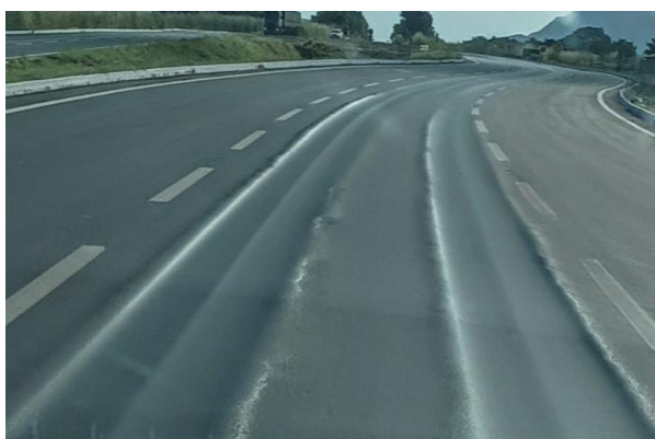
Figura 5 - Afundamento plástico
